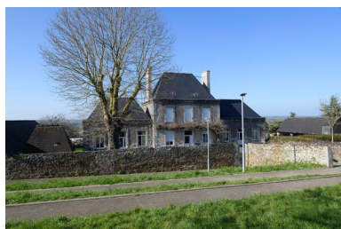
École primaire de garçons Saint-Joseph. Vue d'ensemble depuis le sud-ouest. Phot. Armelle Maugin IVR52_20254900399NUCA
