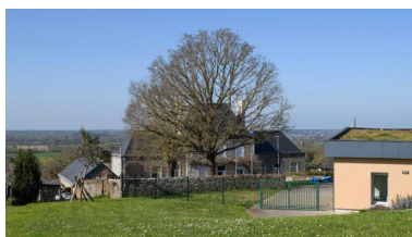
École primaire de garçons Saint-Joseph. Vue d'ensemble depuis le sud-ouest. Phot. Armelle Maugin IVR52_20254900398NUCA
