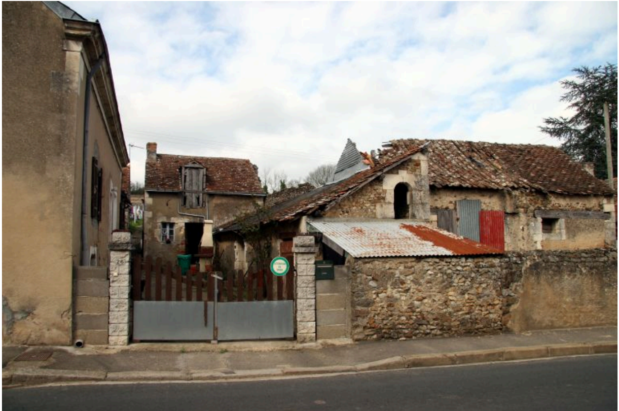
Façade sur la rue.
