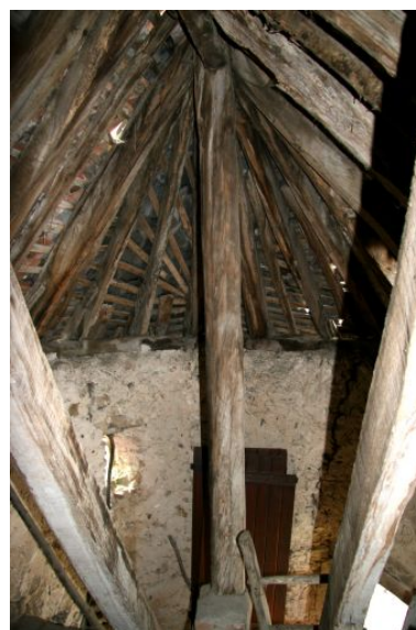
Couvrement de la tourelle. Phot. Jean-Baptiste Darrasse IVR52_20057202102NUCA
