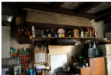
Hotte de la cheminée de la cuisine : linteau de bois et étagère. Phot. Jean-Baptiste Darrasse IVR52_20057202106NUCA
