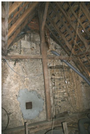
Charpente du comble au-dessus de la cuisine. Phot. Jean-Baptiste Darrasse IVR52_20057202101NUCA
