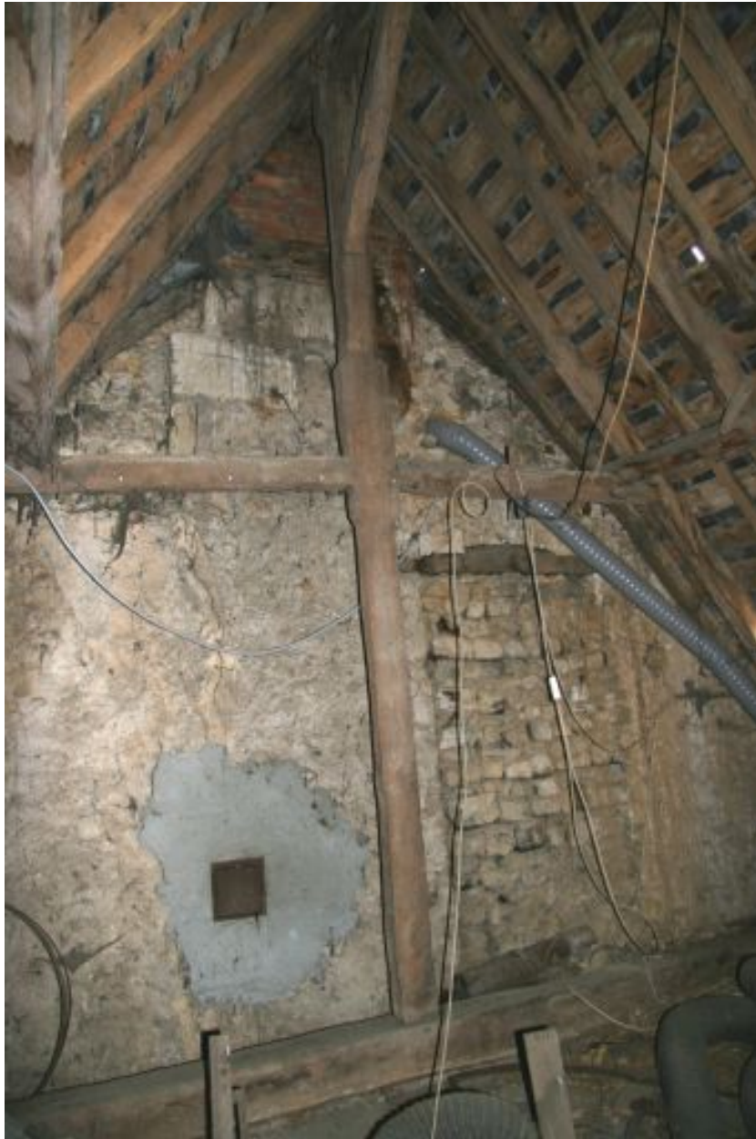
Charpente du comble au-dessus de la cuisine.
