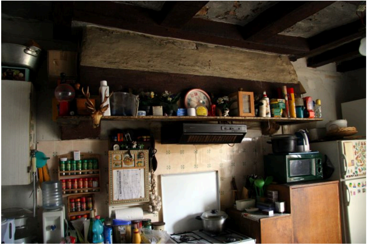
Hotte de la cheminée de la cuisine : linteau de bois et étagère.
