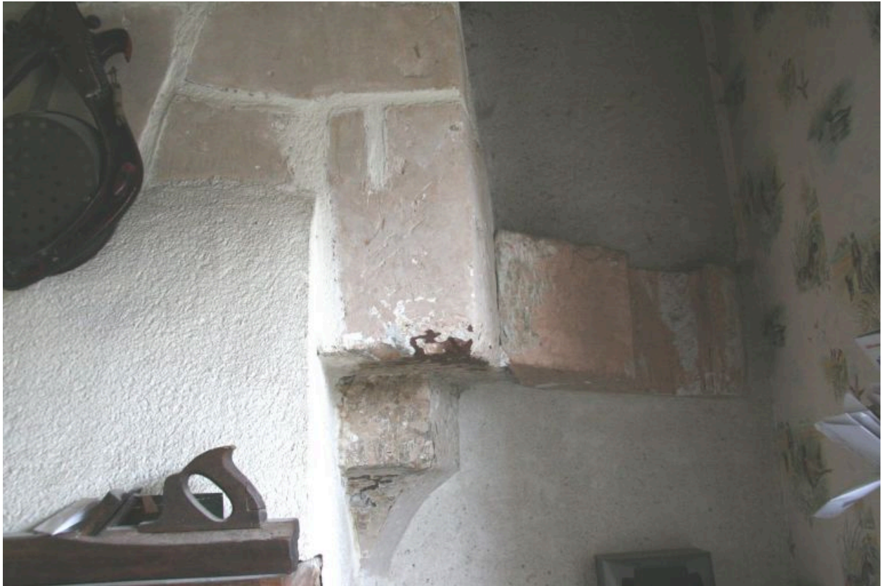
Salle centrale, cheminée en pierre, détail : piédroit.
