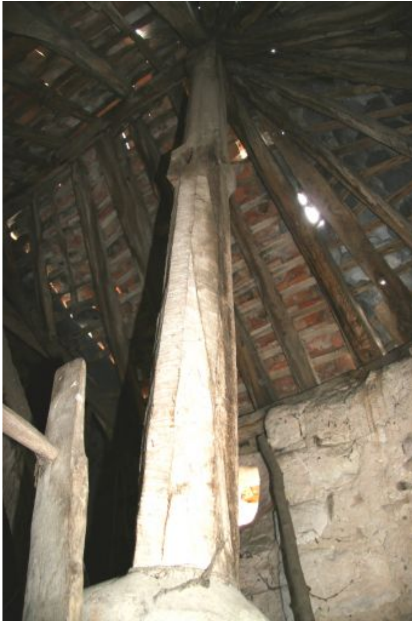
Couvrement de la tourelle : poinçon en réemploi.
