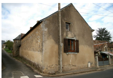
Vue de volume : maison à l'angle avec le chemin du nouveau cimetière. Phot. Jean-Baptiste Darrasse IVR52_20057202109NUCA
