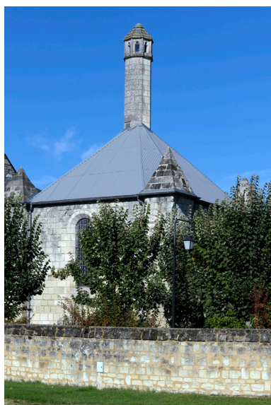
Chapelle Sainte-Catherine : mise hors d'eau provisoire par une couverture en bac acier prélaqué, posé en 2010. Phot. Bruno Rousseau IVR52_20124901859NUCA
