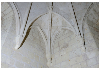
Chapelle haute, voûte, angle sud-est : détail de la trompe (dont clefs à motifs illisibles des formerets). Phot. Bruno Rousseau IVR52_20134900875NUCA
