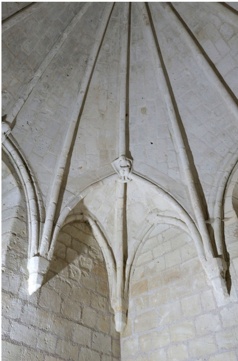
Chapelle haute, voûte, angle nord-ouest.
