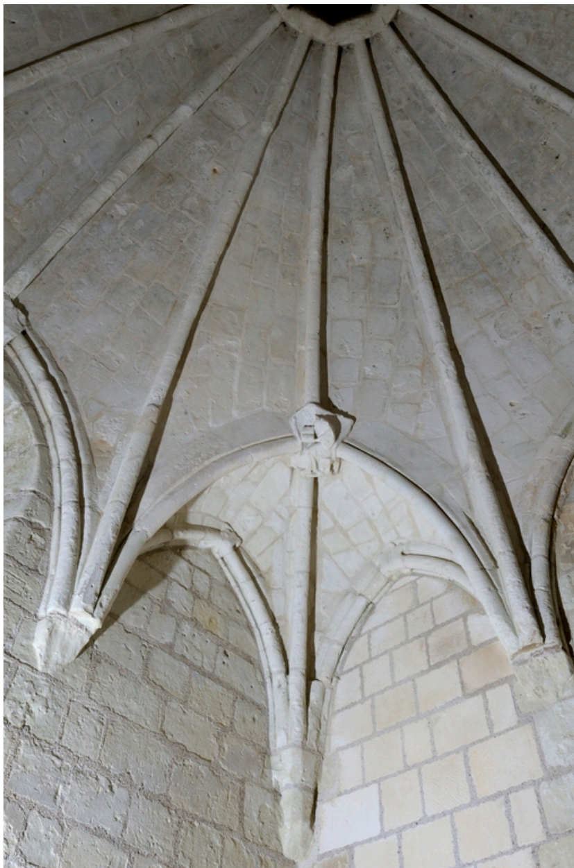
Chapelle haute, voûte, angle sud-ouest.
