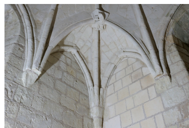
Chapelle haute, voûte, angle sud-ouest : détail de la trompe (dont clefs à ornements végétaux des formerets). Phot. Bruno Rousseau IVR52_20134900877NUCA
