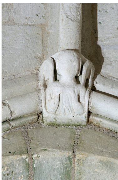
Chapelle haute, voûte, baie ouest, clef du formeret : ange.
