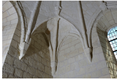
Chapelle haute, voûte, angle nord-est : détail de la trompe (dont clef à motif illisible du formeret de droite). Phot. Bruno Rousseau IVR52_20134900881NUCA
