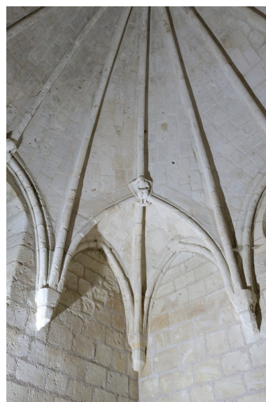
Chapelle haute, voûte, angle nord-ouest.
