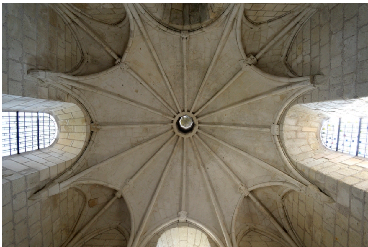
Chapelle haute : voûte bombée à quartiers rayonnants et nervures multiples (nord à gauche, ouest en haut).
