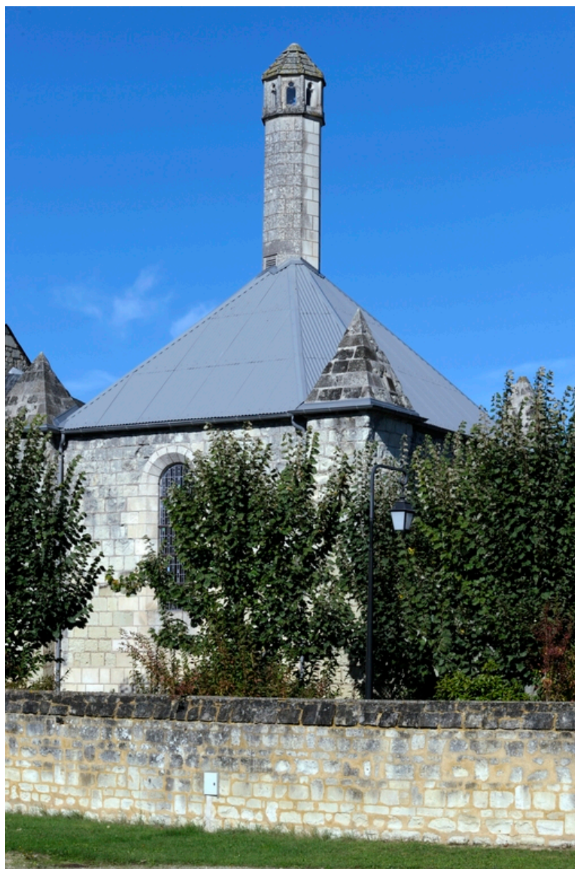
Chapelle Sainte-Catherine : mise hors d'eau provisoire par une couverture en bac acier prélaqué, posé en 2010.
