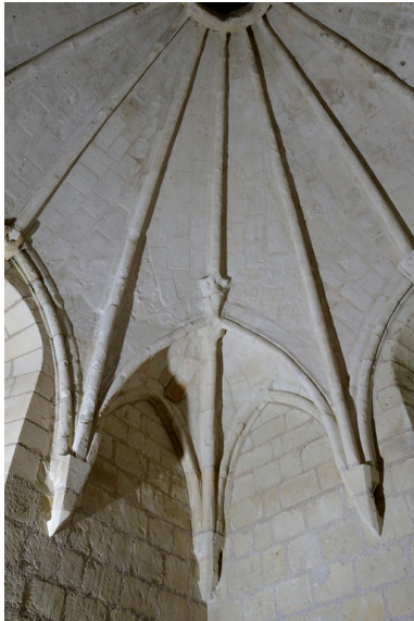
Chapelle haute, voûte, angle nord-est. Phot. Bruno Rousseau IVR52_20134900880NUCA
