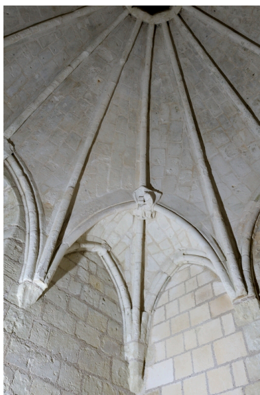
Chapelle haute, voûte, angle sud-ouest. Phot. Bruno Rousseau IVR52_20134900876NUCA
