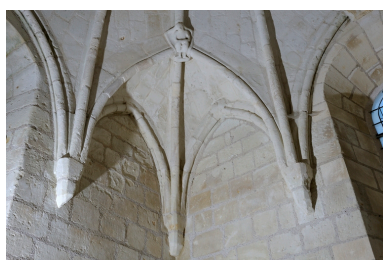
Chapelle haute, voûte, angle nord-ouest : détail de la trompe (dont clefs à motifs illisibles des formerets).
