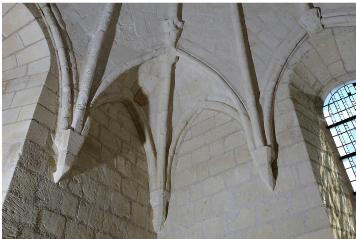
Chapelle haute, voûte, angle nord-est : détail de la trompe (dont clef à motif illisible du formeret de droite).
