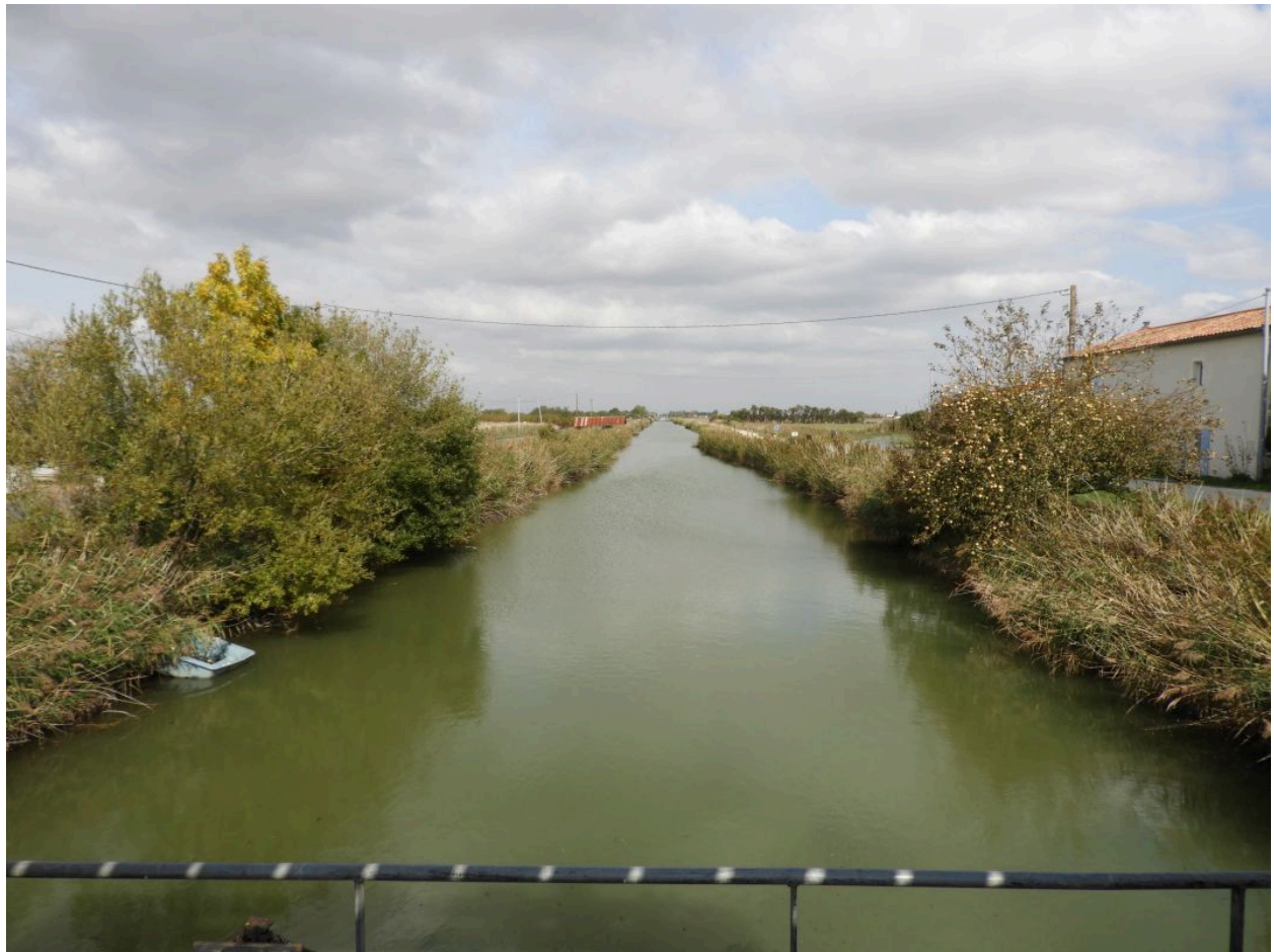
Le canal du Clain à la porte des Grands Greniers, vu en direction du nord.
