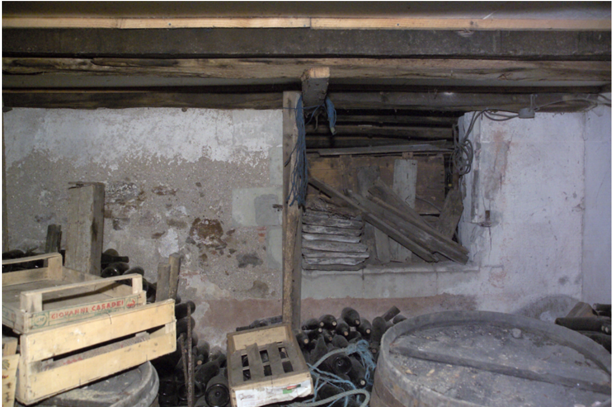
Le mur de façade de la précédente maison, détail d'une des baies située à gauche de l'ancienne entrée.
