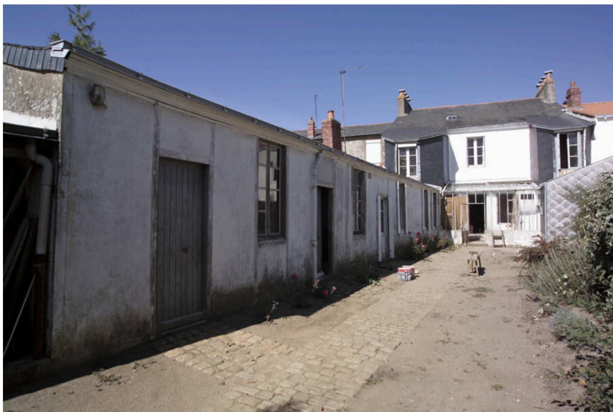
Vue d'ensemble depuis le jardin.
