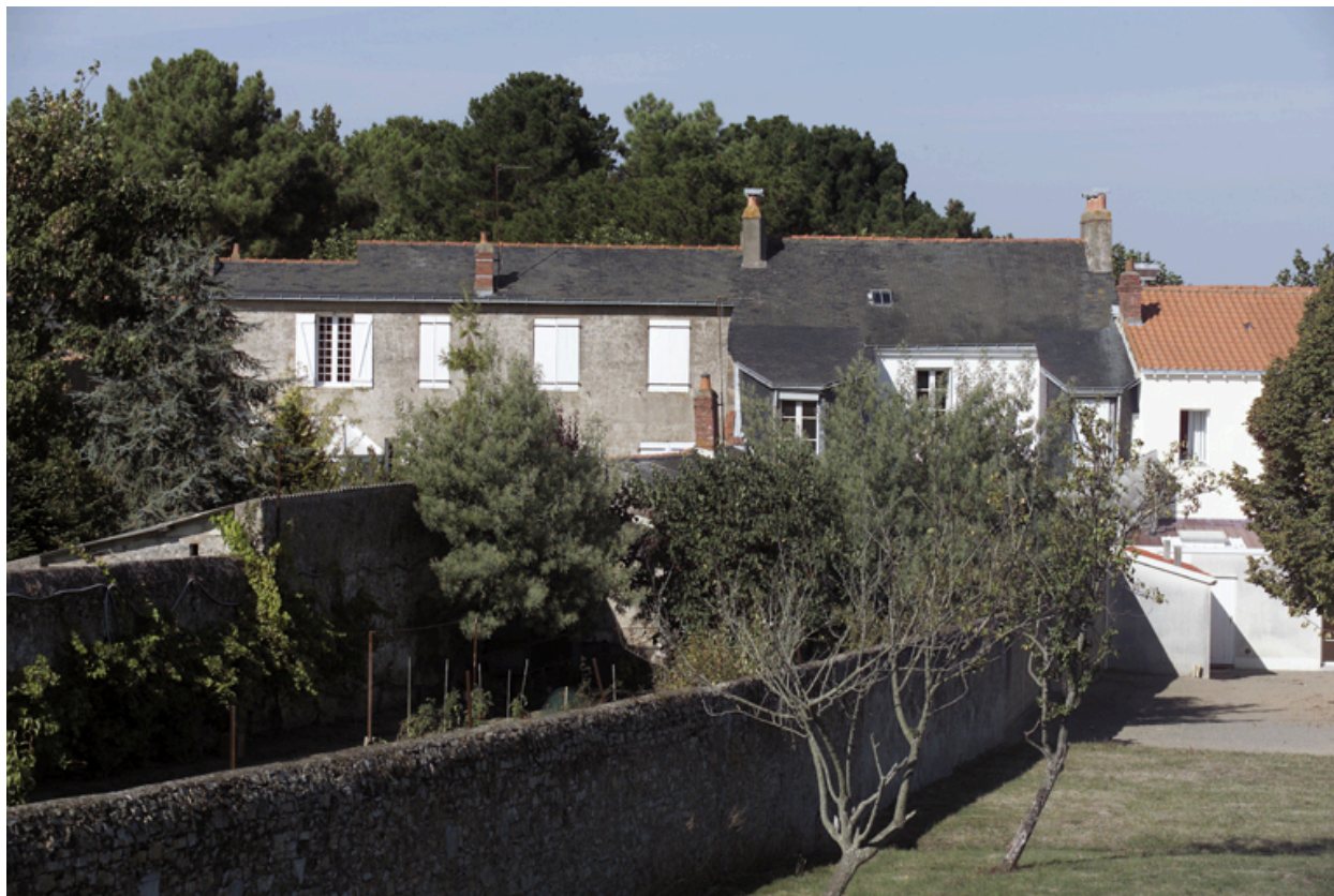
Vue des maisons adressées n° 9, n° 8, n° 7 quai Eole depuis l'impasse des Caillebotes, au centre, la maison n° 8.
