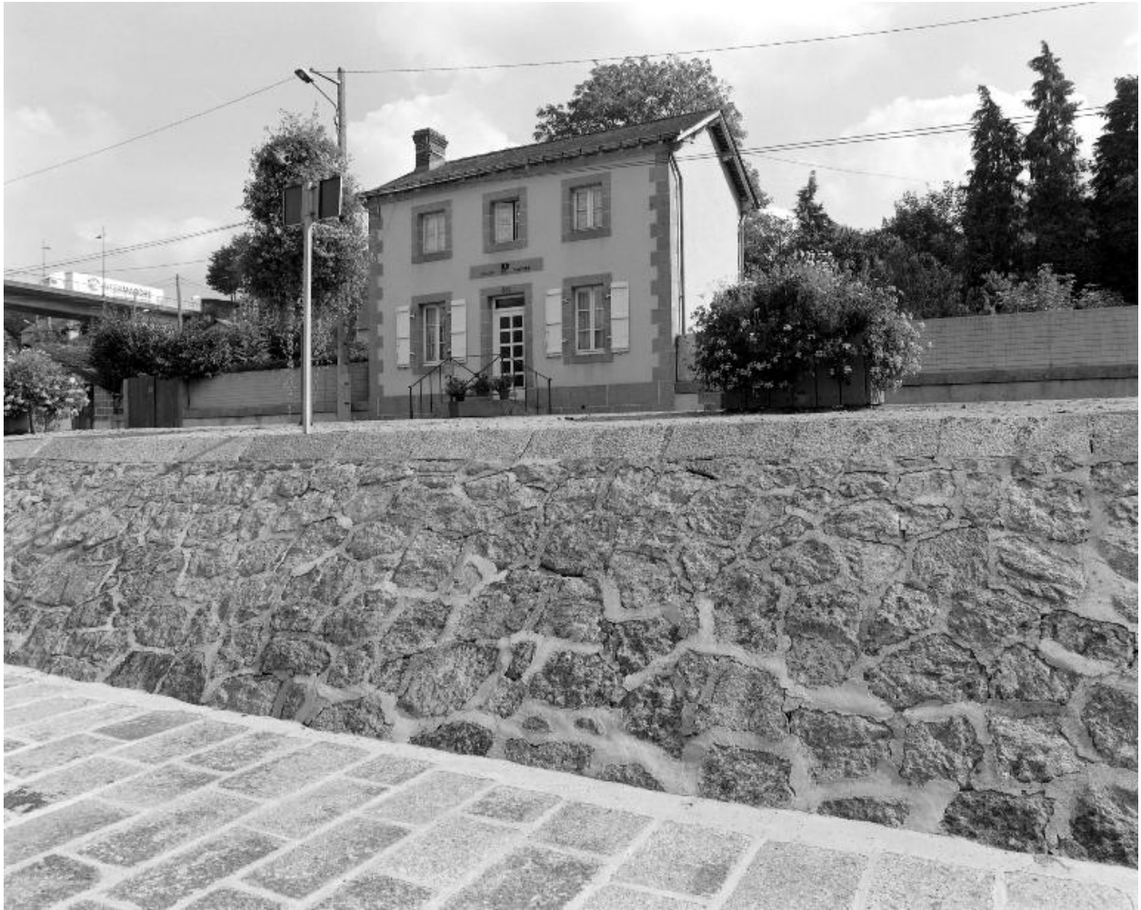
La maison éclusière.
