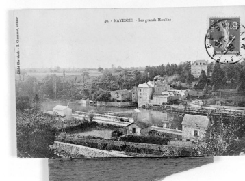
Vue d'ensemble du site depuis la rive gauche : maison éclusière, écluse, barrage, Grands Moulins. Autr. Chevrinais, Autr. E. Chouasnet, Repro. François Lasa IVR52_20015300374X
