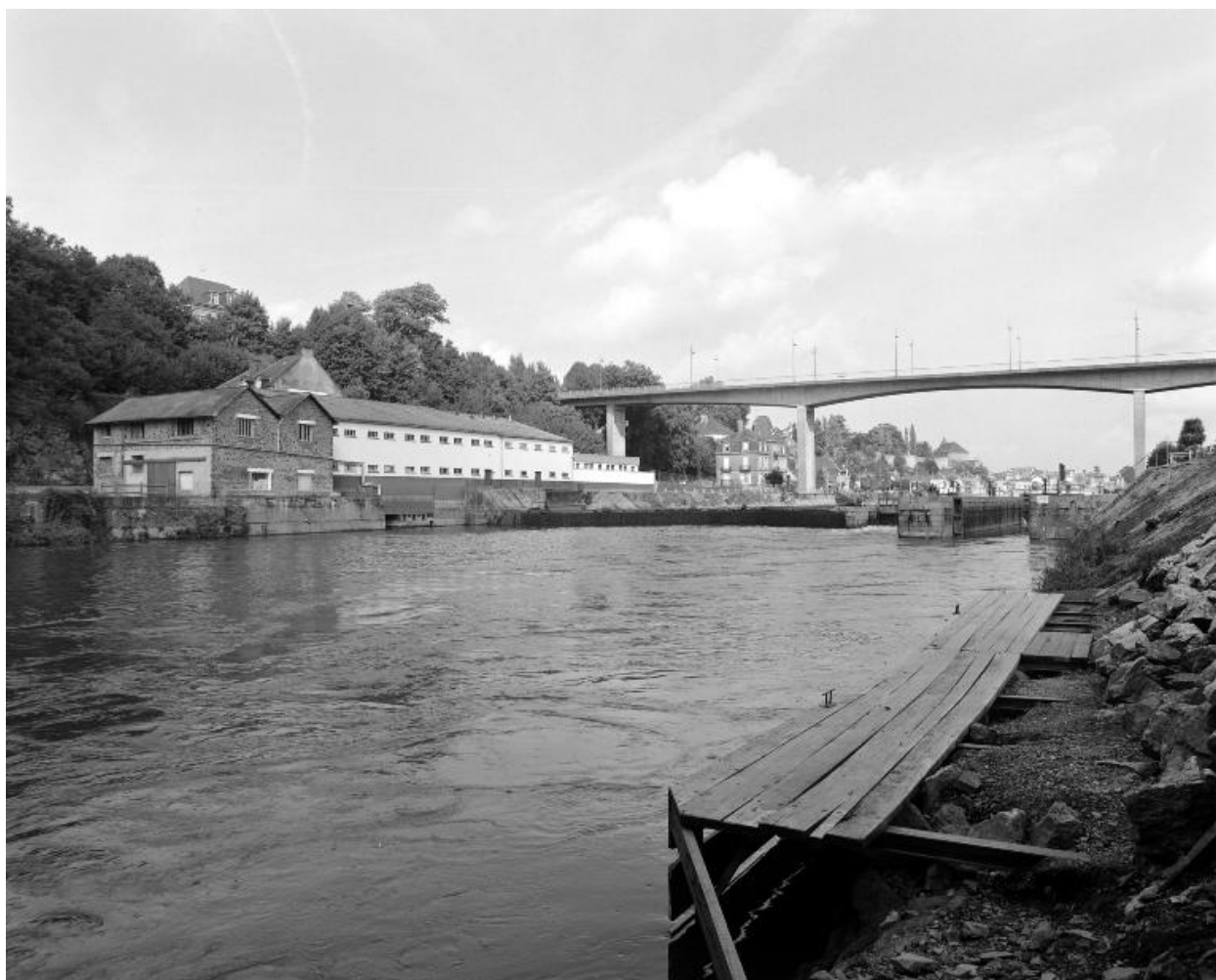
Les vestiges du moulin, le barrage, le pertuis, l'écluse et le pont vus depuis le ponton situé à l'aval.
