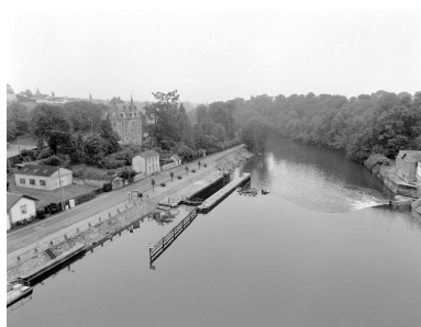
La maison éclusière, l'écluse et le barrage vus depuis le viaduc. Phot. François Lasa IVR52_20025301208X
