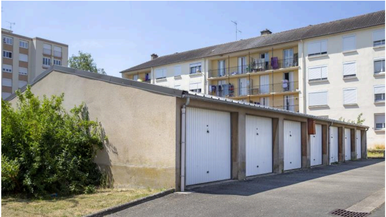
Vue des garages rue du Docteur-Ernest-Mordret.
