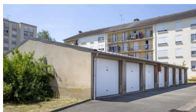
Vue des garages rue du Docteur-Ernest-Mordret. Phot. Pierre-Bernard Fourny IVR52_20197201767NUCA
