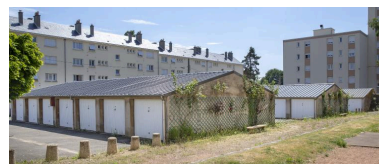
Vue des garages rue du Docteur- Ernest-Mordret. Phot. Pierre-Bernard Fourny IVR52_20197201761NUCA
