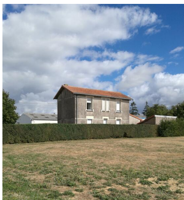
Vue du logement patronal depuis le sud. Phot. Mathilde Vozza IVR52_20244901179NUCA
