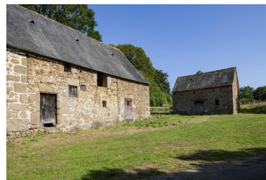
Logis nord et étable. Phot. Yves Guillotin IVR52_20215301435NUCA
