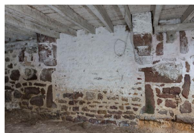
Logis central, manoir original, salle basse, cheminée. Phot. Yves Guillotin IVR52_20195300554NUCA
