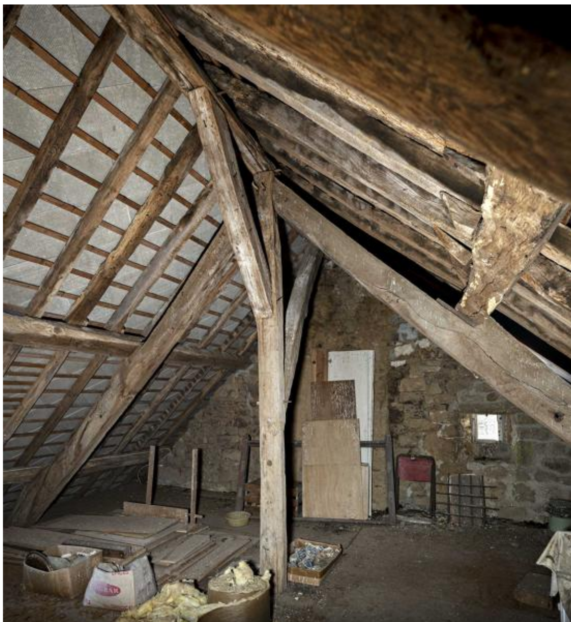
Logis sud, charpente.
