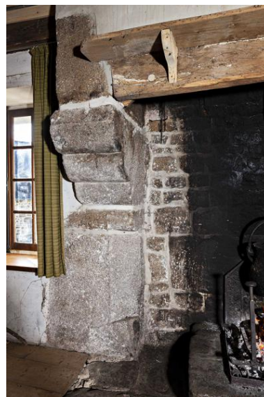
Logis sud, cheminée du mur-pignon sud. Phot. Yves Guillotin IVR52_20215301761NUCA
