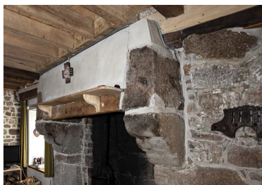
Logis sud, cheminée du mur-pignon sud. Phot. Yves Guillotin IVR52_20215301762NUCA
