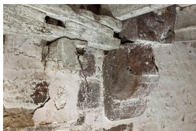
Logis central, manoir original, salle basse, cheminée. Phot. Yves Guillotin IVR52_20195300556NUCA
