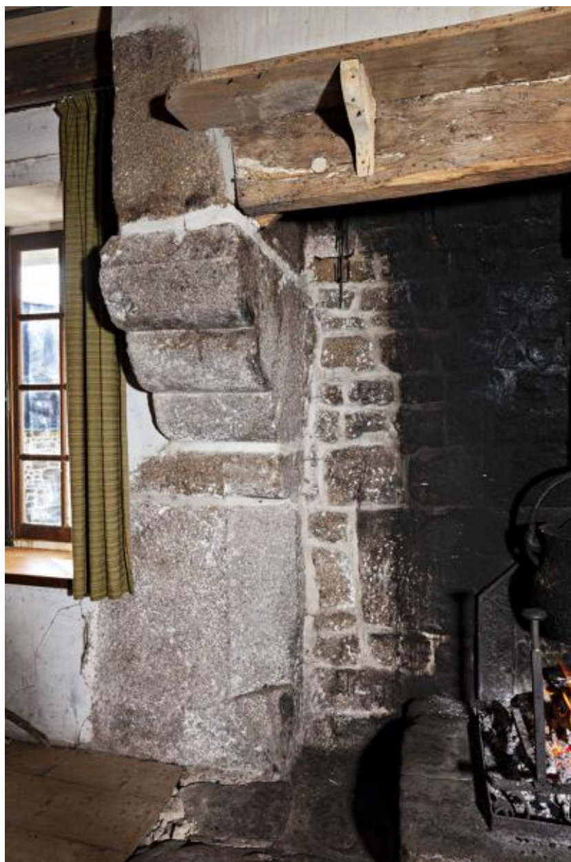
Logis sud, cheminée du mur-pignon sud.
