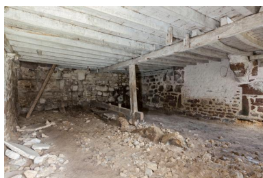
Logis central, manoir original, salle basse. Phot. Yves Guillotin IVR52_20195300552NUCA
