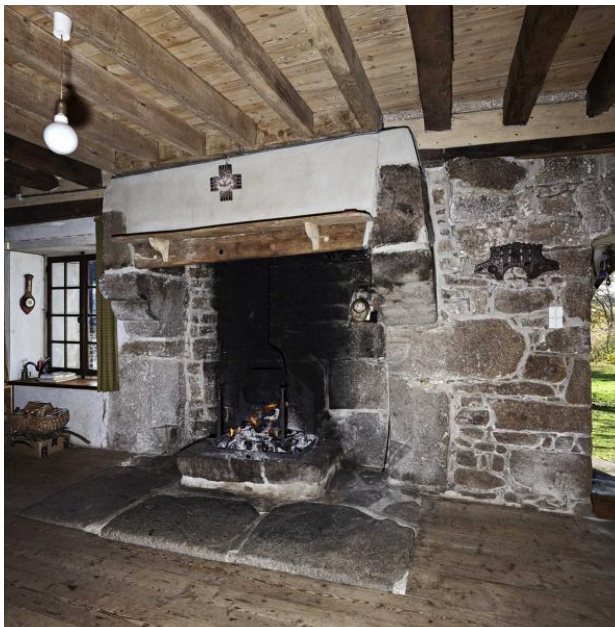
Logis sud, cheminée du mur-pignon sud.
