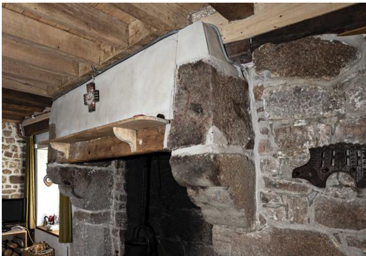
Logis sud, cheminée du mur-pignon sud.
