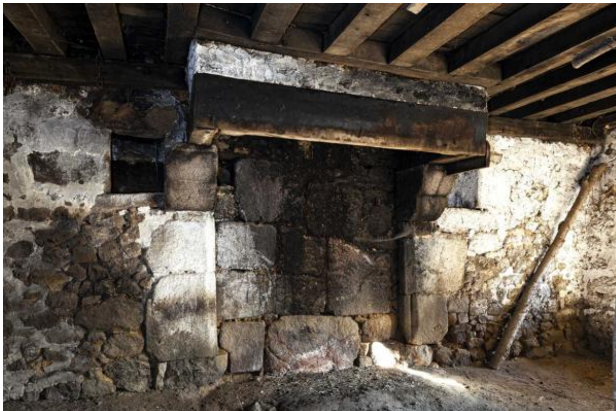
Logis nord, cheminée.
