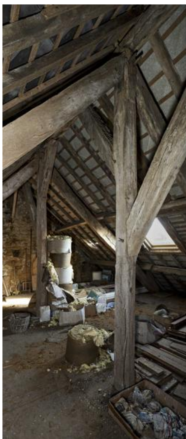
Logis sud, charpente. Phot. Yves Guillotin IVR52_20215301767NUCA
