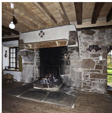
Logis sud, cheminée du mur-pignon sud. Phot. Yves Guillotin IVR52_20215301760NUCA
