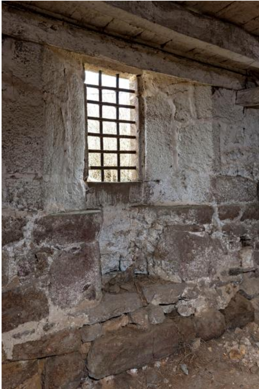
Logis central, manoir originel, salle basse, fenêtre à coussièges.
