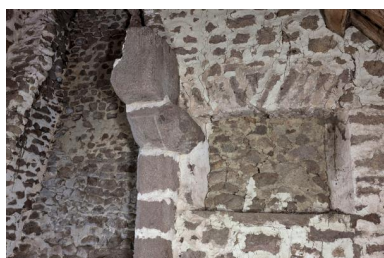
Logis central, manoir original, salle haute, cheminée. Phot. Yves Guillotin IVR52_20195300559NUCA
