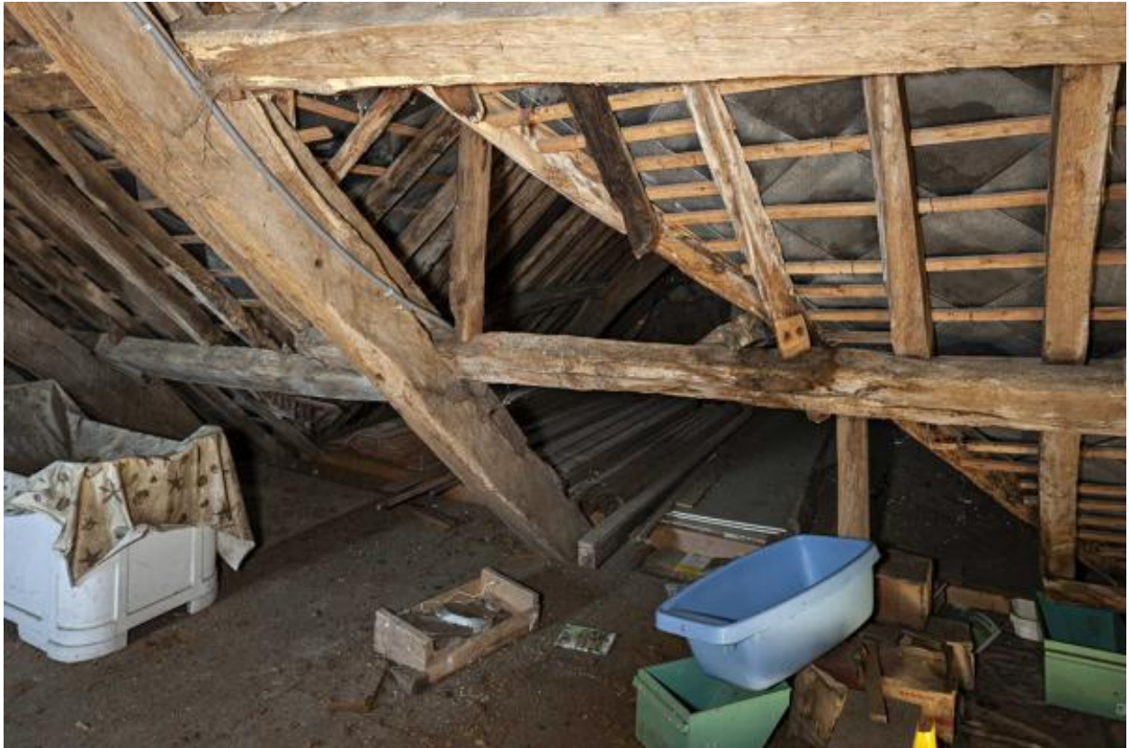
Logis sud, charpente.
