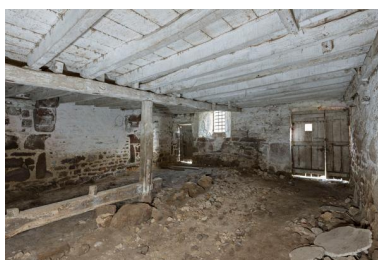
Logis central, manoir original, salle basse. Phot. Yves Guillotin IVR52_20195300553NUCA
