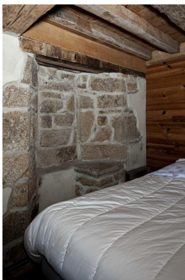
Logis sud, fenêtre bouchée à coussiège dans l'ancien mur- gouttereau ouest, au premier étage. Phot. Yves Guillotin IVR52_20215301764NUCA
