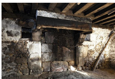
Logis nord, cheminée. Phot. Yves Guillotin IVR52_20215301771NUCA
