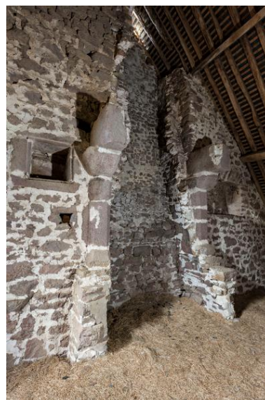
Logis central, manoir original, salle haute, cheminée. Phot. Yves Guillotin IVR52_20195300557NUCA
