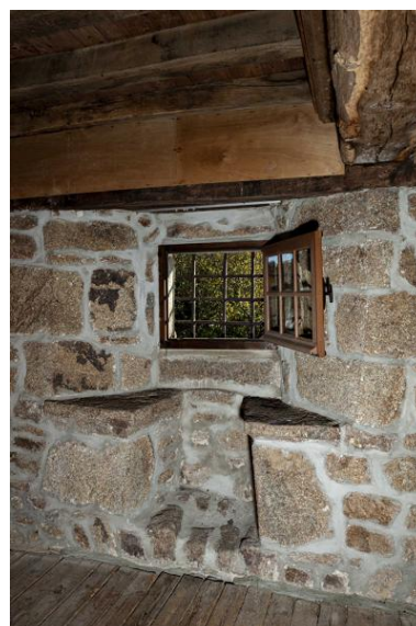
Logis sud, coussièges, fenêtre du comble. Phot. Yves Guillotin IVR52_20215301763NUCA
