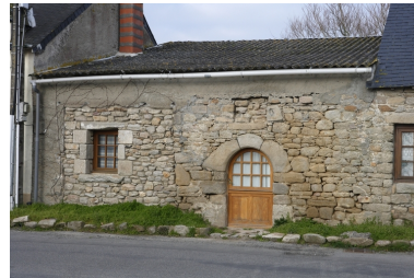
Vue du deuxième logis (20 rue de Kerignon). Phot. Denis Pillet IVR52_20084400048NUCA
