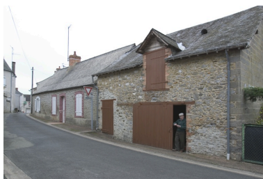
Vue d'ensemble depuis la rue au sud-est. Phot. François Lasa IVR52_20045303276NUCA
