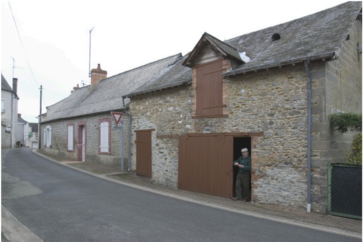
Vue d'ensemble depuis la rue au sud-est.
