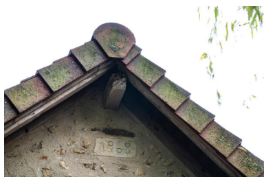
Dépendance : date portée. Phot. Thierry Seldubuisson IVR52_20247200434NUCA
