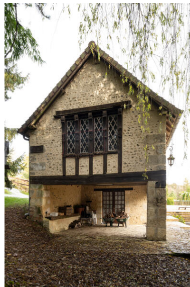
Dépendance. Phot. Thierry Seldubuisson IVR52_20247200433NUCA
