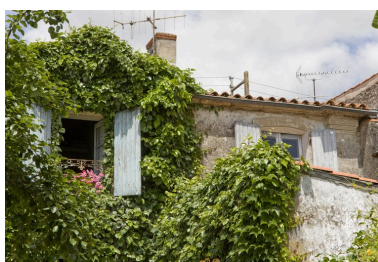
Détail de la façade sud (partie droite du dernier niveau). Phot. Patrice Giraud IVR52_20098500307NUCA
