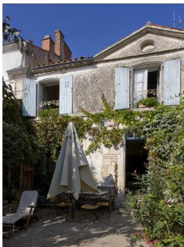
Vue de la façade principale, donnant au sud. Phot. Patrice Giraud IVR52_20098500510NUCA
