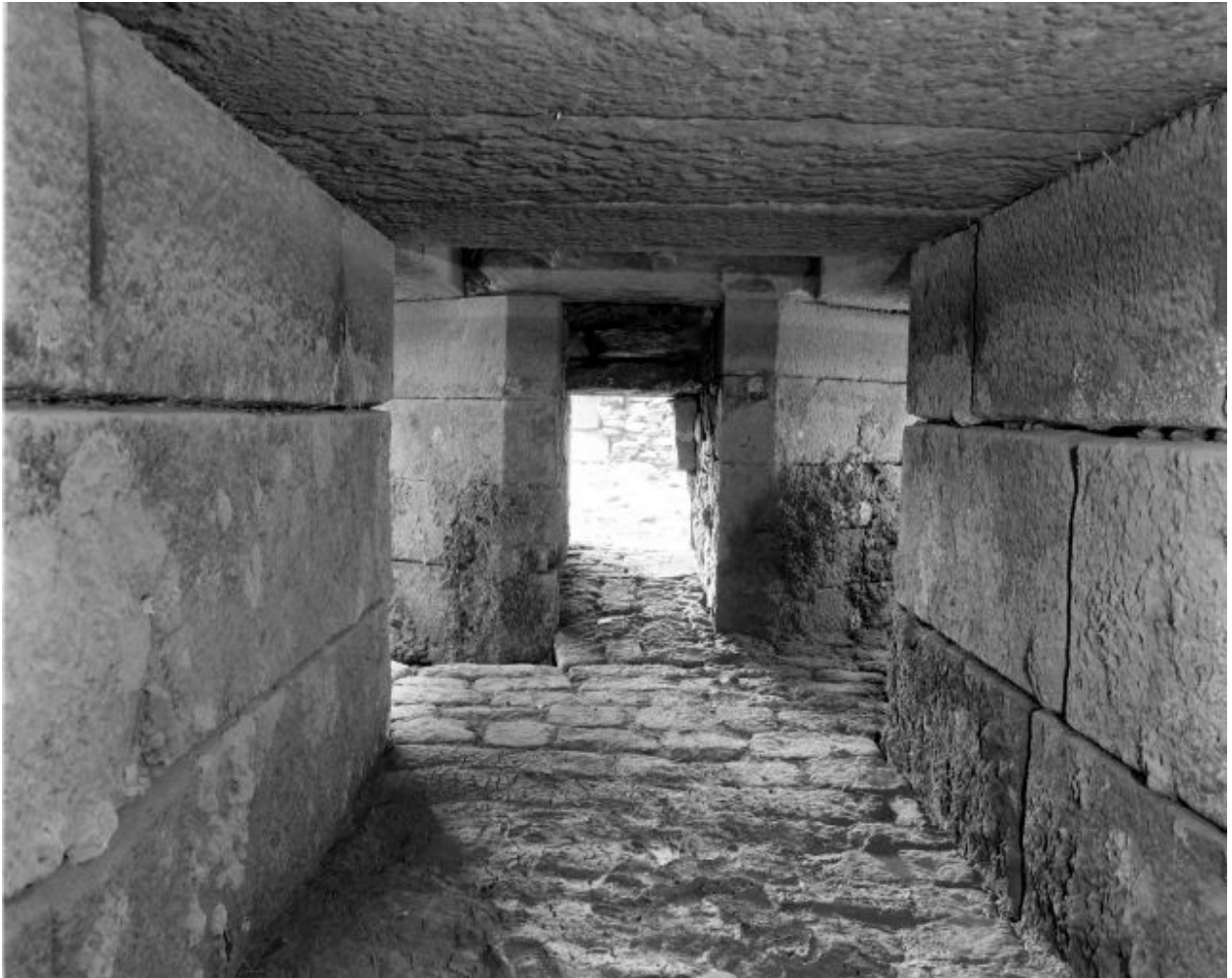
L'entrée et l'extrémité est du coursier central vus de l'ouest.
