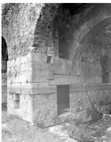
Entrées des coursiers depuis le nord-est. Vue de détail sur le bajoyer sud du coursier nord, les ouvertures du coursier central et le guide de la vanne. Phot. François Lasa IVR52_19855300309X
