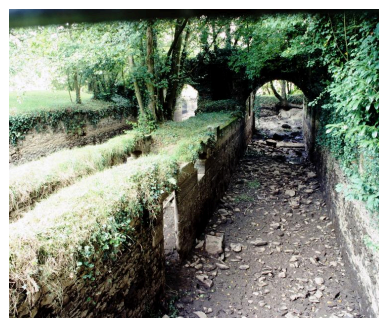
Le coursier latéral sud vu de l'ouest. A gauche, coursier central et coursier latéral nord.
