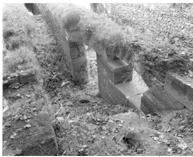
La partie centrale du coursier central vus de l'est : emplacement de la roue. Phot. François Lasa IVR52_19855300326X
