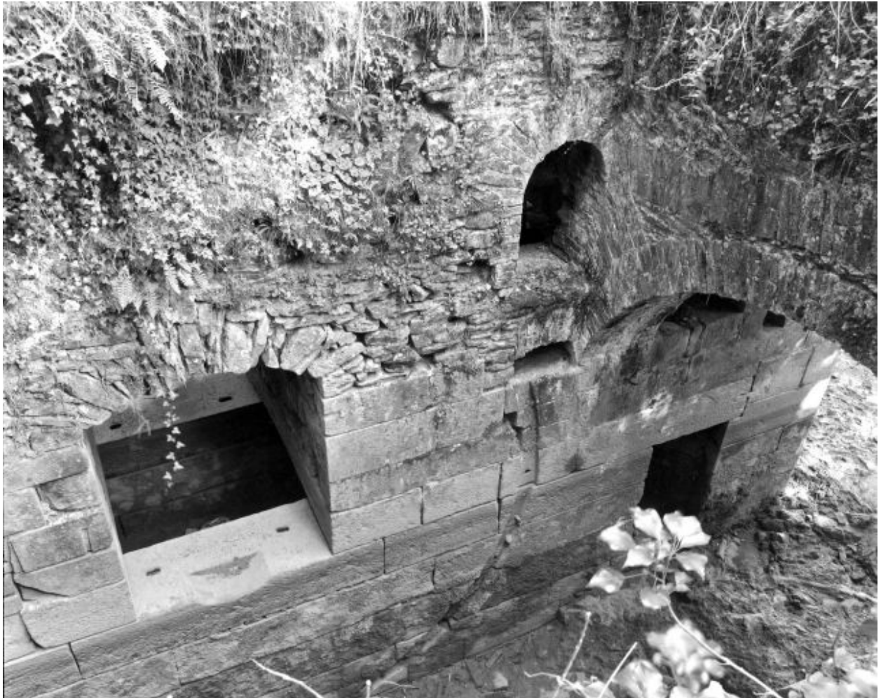
Vue plongeante depuis le sud sur le coursier latéral sud : mur bajoyer nord, arc, ouvertures sur le coursier central.
