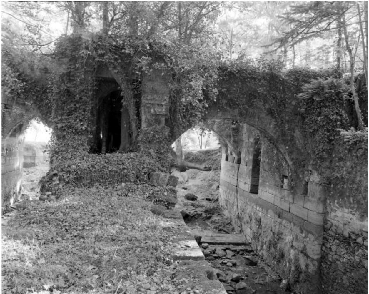
Le coursier central et le coursier latéral nord vus de l'ouest.
