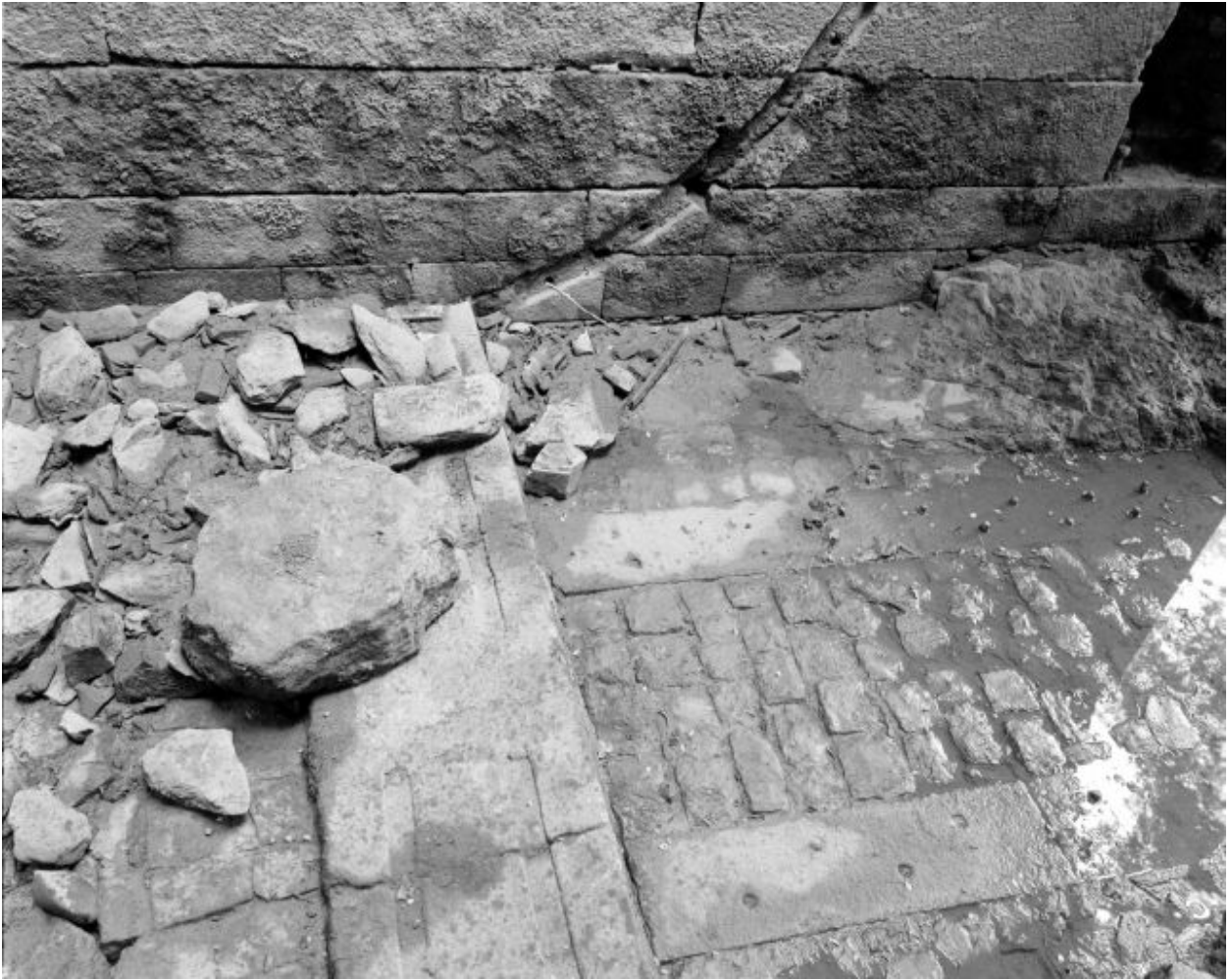
Vue de détail du radier du coursier latéral sud.
