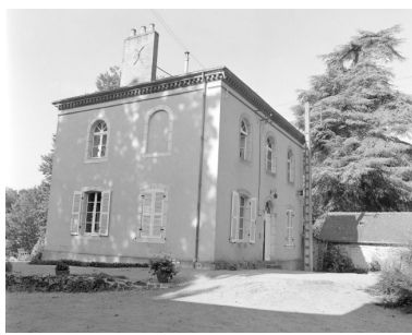
La maison du directeur. Façades est et nord. Phot. François Lasa IVR52_19855300324X
