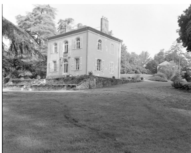
La maison du directeur. Façades sud et est. Phot. François Lasa IVR52_19855300323X
