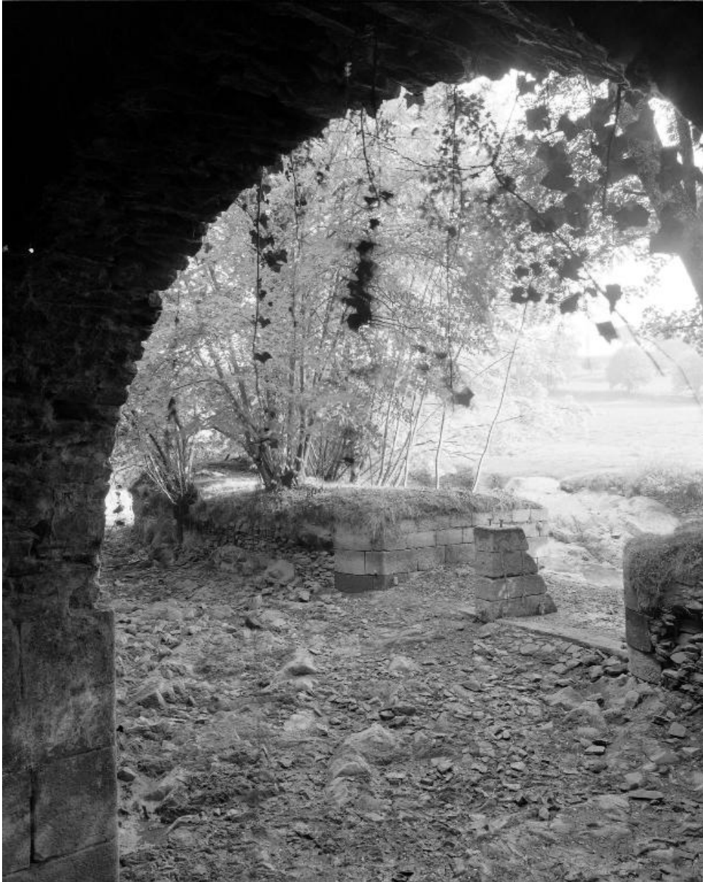
Vannes de décharge.
