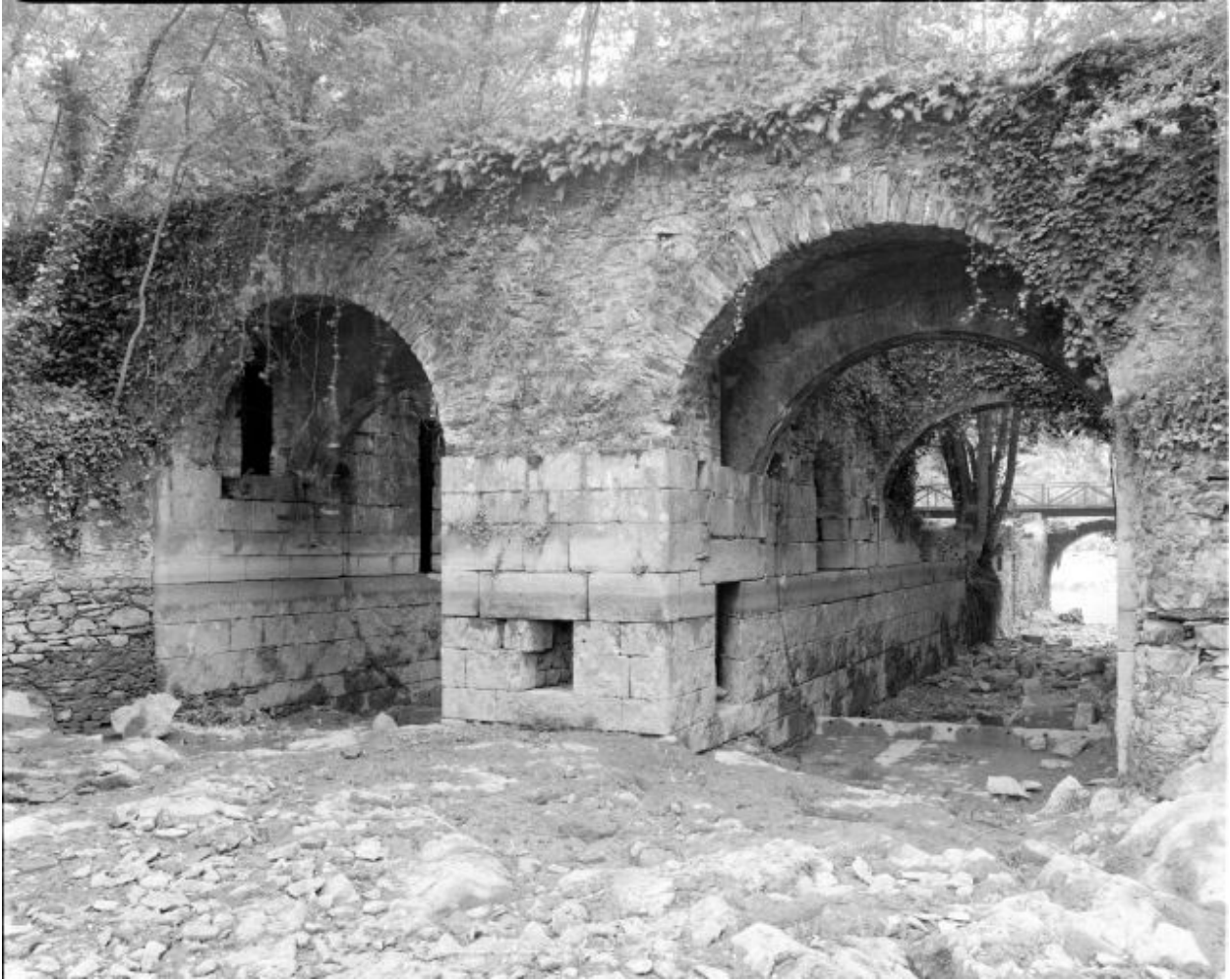
Les entrées des coursiers vues de l'est.
