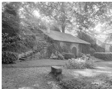
Ancien magasin. Façade sud. Phot. François Lasa IVR52_19855300322X
