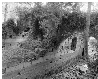
Le coursier latéral sud vu du sud-ouest : mur bajoyer nord, arc. A gauche, le mur bajoyer nord du coursier latéral nord.
