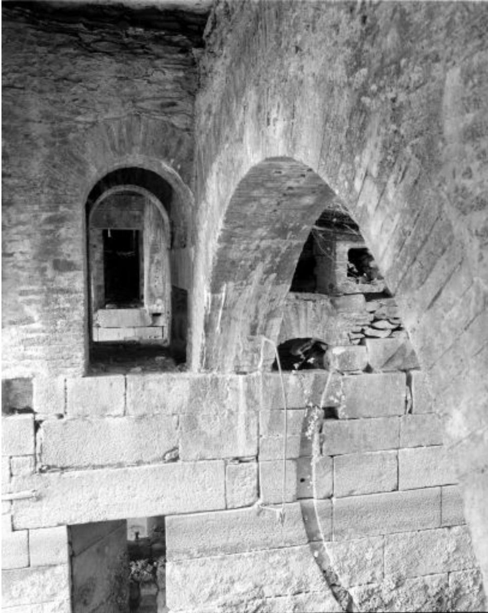
Vue de détail de la partie est du coursier latéral nord : mur bajoyer sud, arc, ouvertures donnant sur le coursier central, guide de la vanne qui épousait la forme de la roue.
