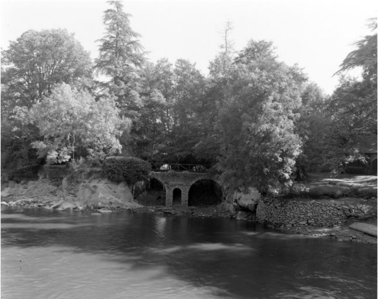
Les sorties d'eau, vues de l'ouest.
