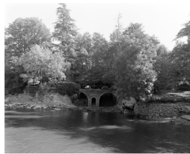
Les sorties d'eau, vues de l'ouest. Phot. François Lasa IVR52_19855300329X
