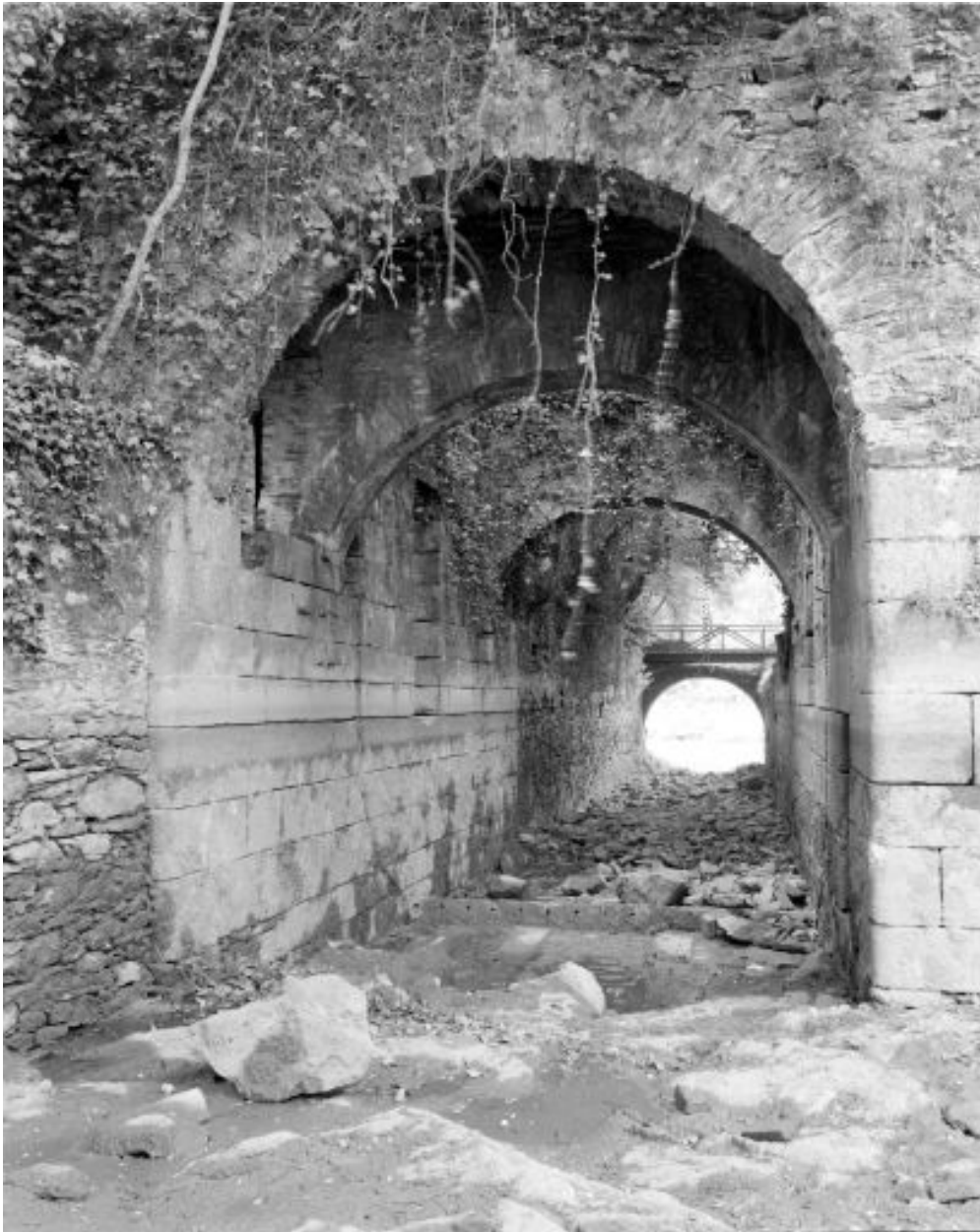
Le coursier latéral sud vu depuis l'est. au second plan, le seuil et le guide de la vanne
