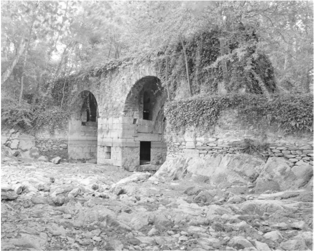
Les entrées des coursiers vues du nord-est.
