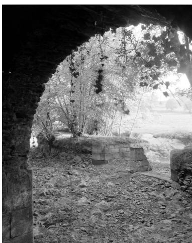
Vannes de décharge. Phot. François Lasa IVR52_19855300319X
