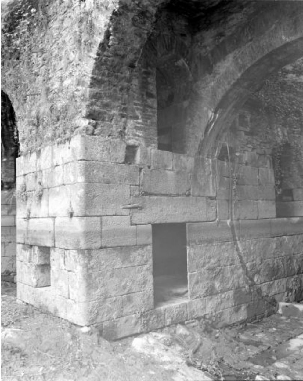
Entrées des coursiers depuis le nord-est. Vue de détail sur le bajoyer sud du coursier nord, les ouvertures du coursier central et le guide de la vanne.
