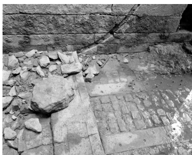
Vue de détail du radier du coursier latéral sud.
