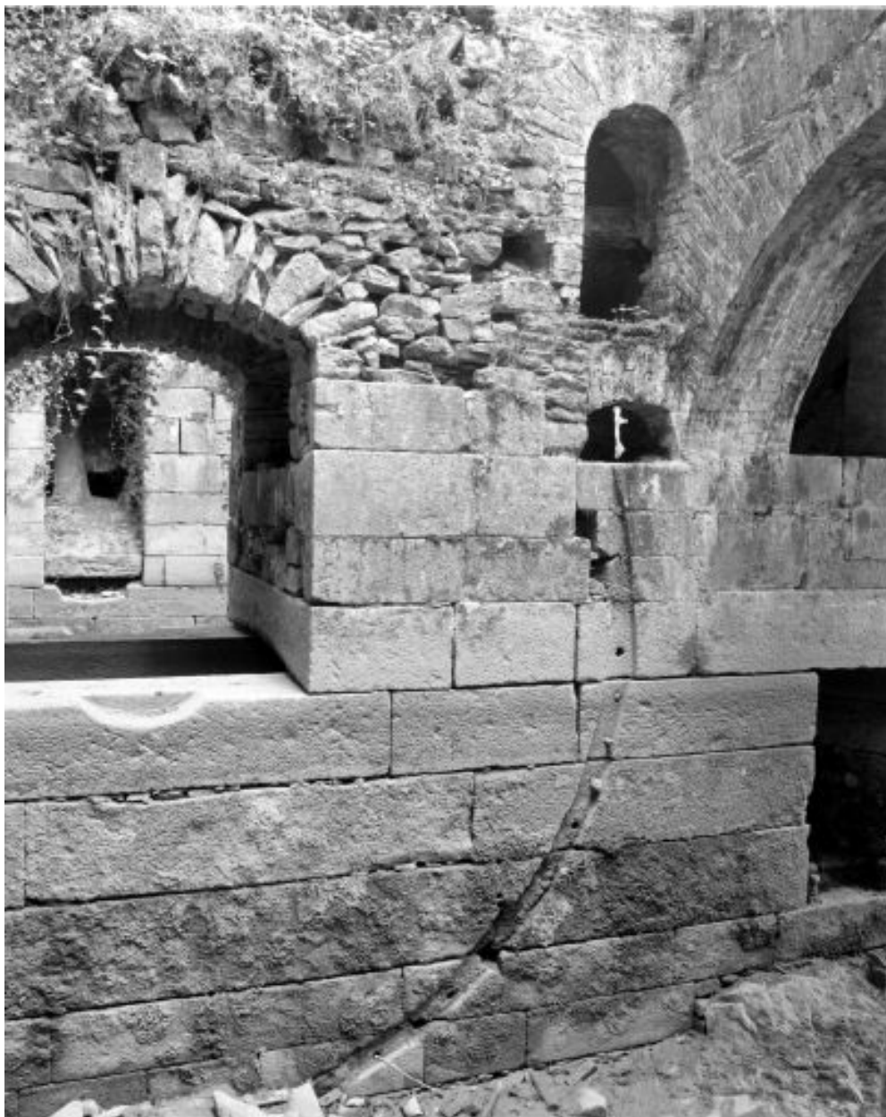
Partie est du coursier latéral sud. Vue de détail du mur bajoyer nord : seuil de la vanne épousant la forme de la roue, ouvertures donnant sur le coursier central.
