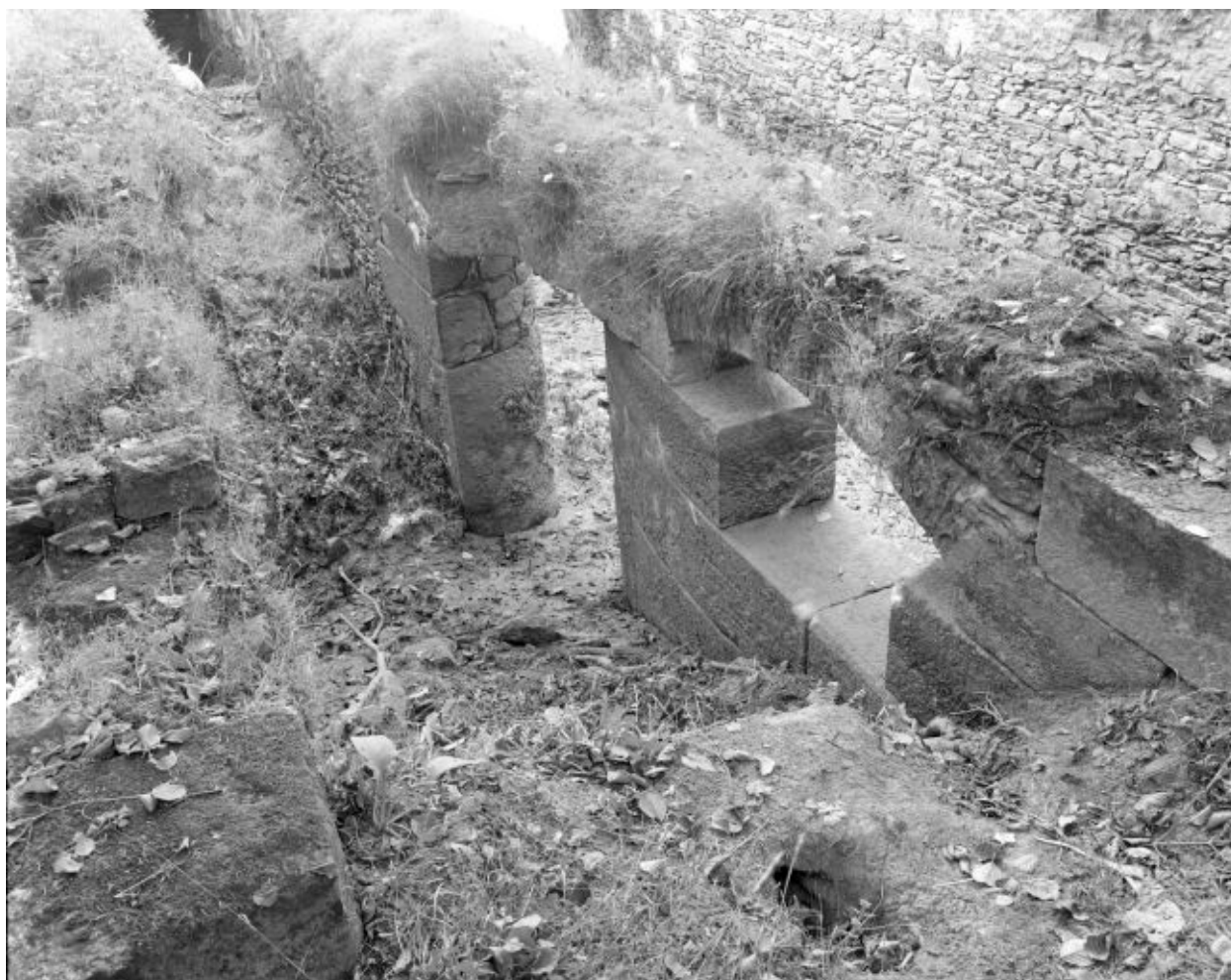
La partie centrale du coursier central vus de l'est : emplacement de la roue.
