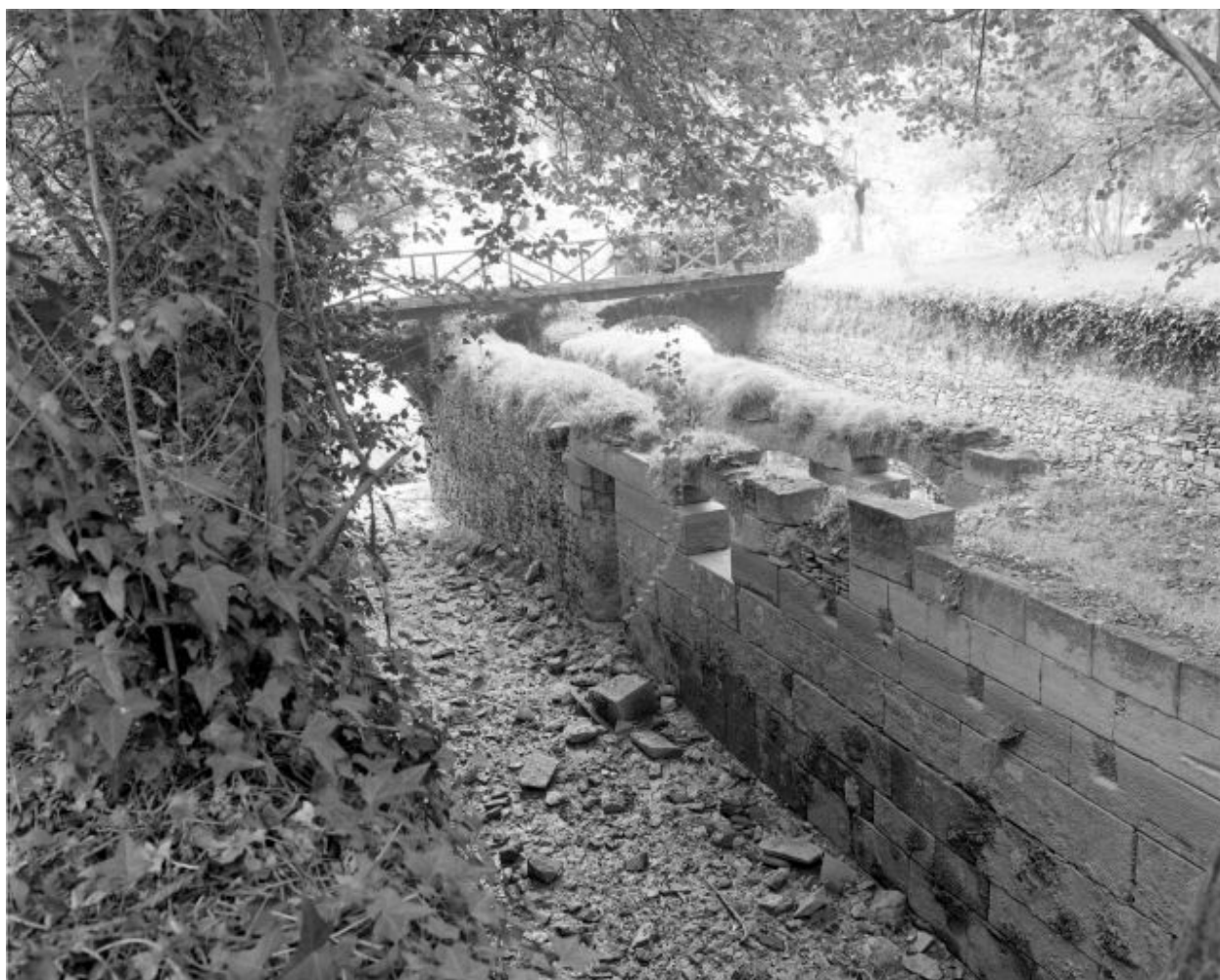
Le coursier latéral sud vu du sud-est : mur bajoyer nord. A droite, le coursier central et le coursier latéral nord.
