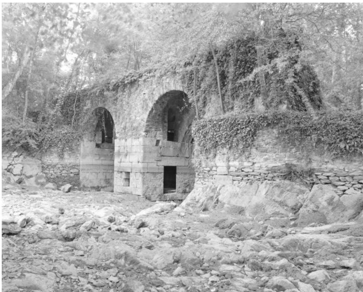
Les entrées des coursiers vues du nord-est.
