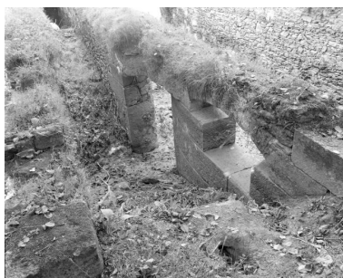
La partie centrale du coursier central vus de l'est : emplacement de la roue.
