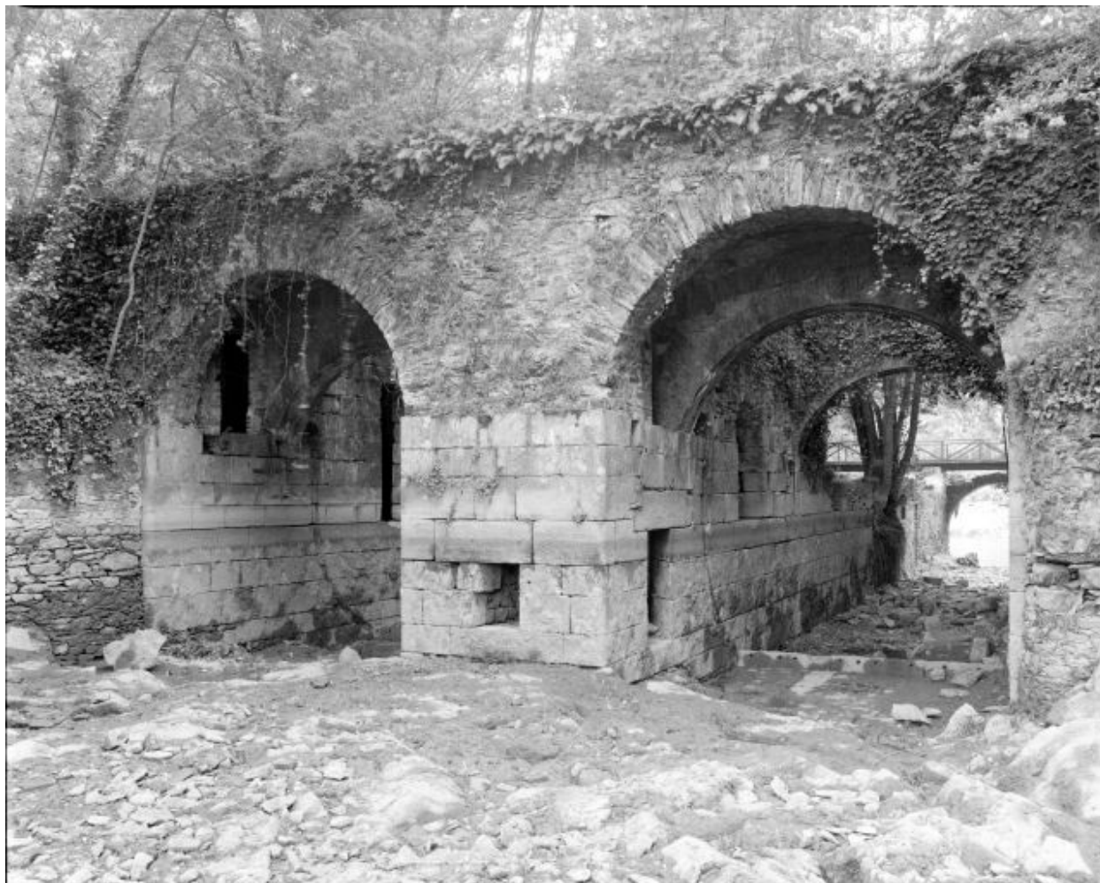
Les entrées des coursiers vues de l'est.
