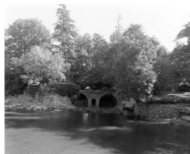
Les sorties d'eau, vues de l'ouest.
