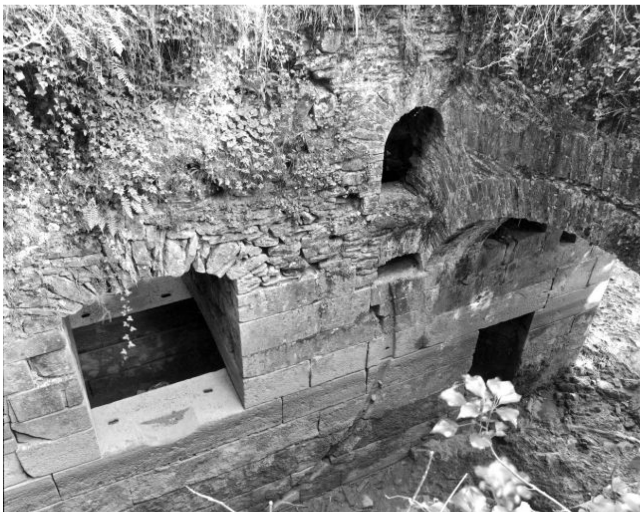
Vue plongeante depuis le sud sur le coursier latéral sud : mur bajoyer nord, arc, ouvertures sur le coursier central.
