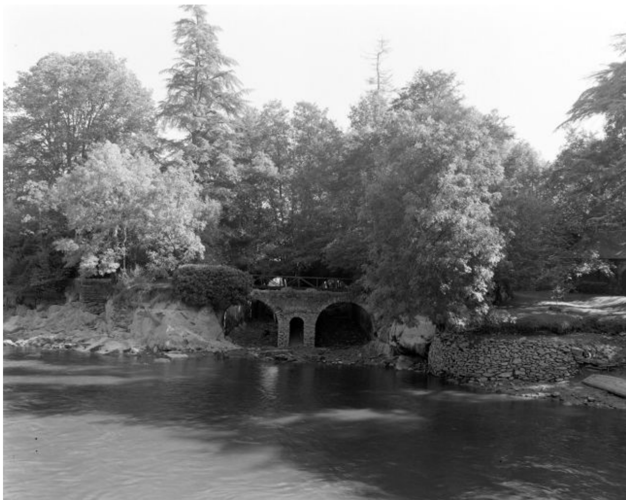
Les sorties d'eau, vues de l'ouest.
