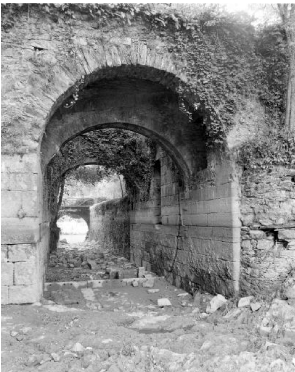
Le coursier latéral nord vu depuis l'est. Au second plan, le seuil de la vanne, pavé, et son guide, creusé dans le mur, qui épousait la forme de la roue.
