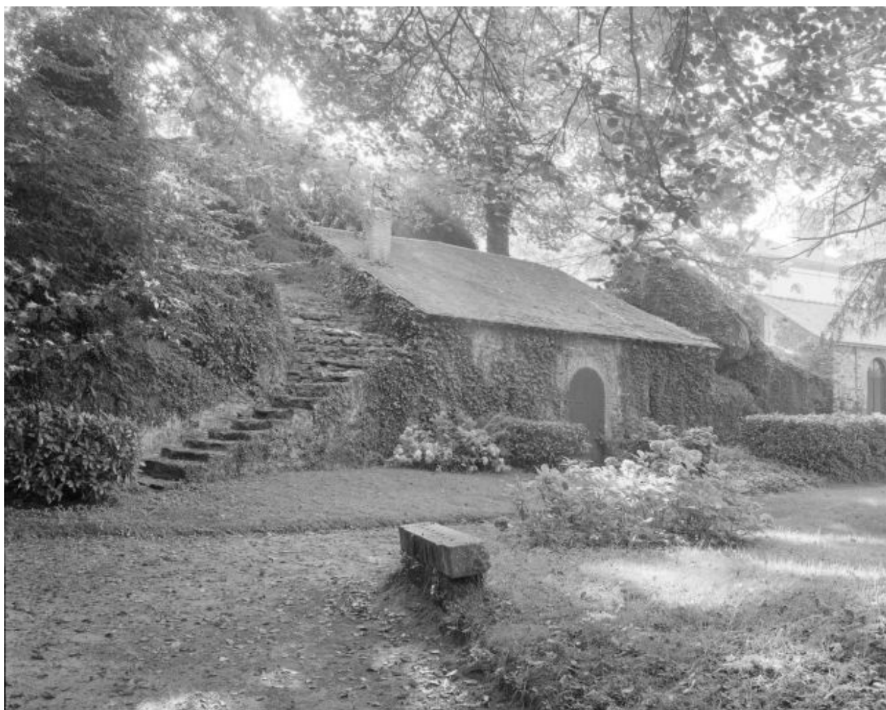
Ancien magasin. Façade sud.
