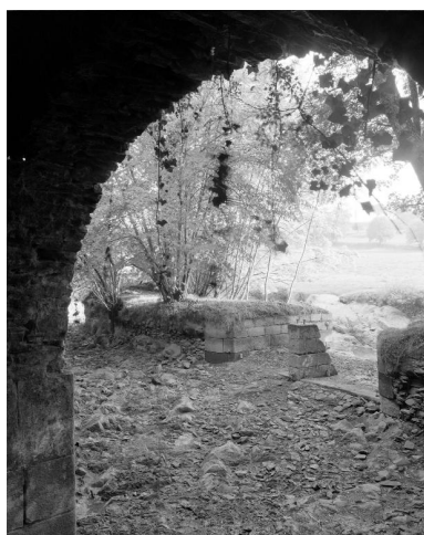
Vannes de décharge.
