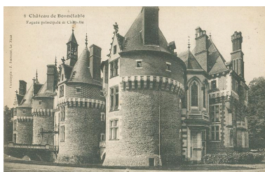
Vue du château depuis le nord. A droite, la chapelle et le pavillon ajoutés entre 1880 et 1888. Phot. Julien (reproduction) Hardy, Autr. J. Bouveret IVR52_20157200479NUCA
