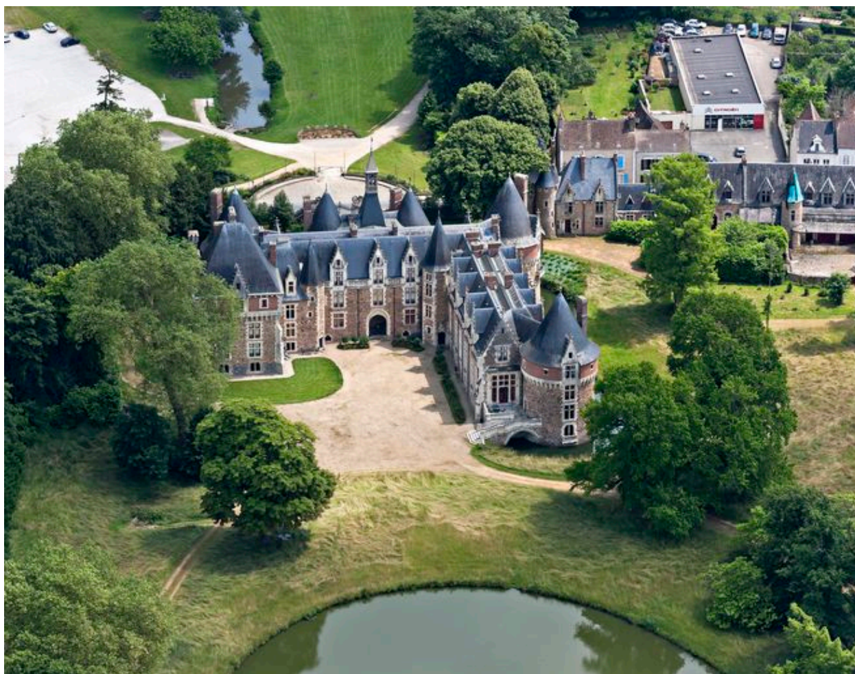
Vue aérienne depuis l'ouest.
