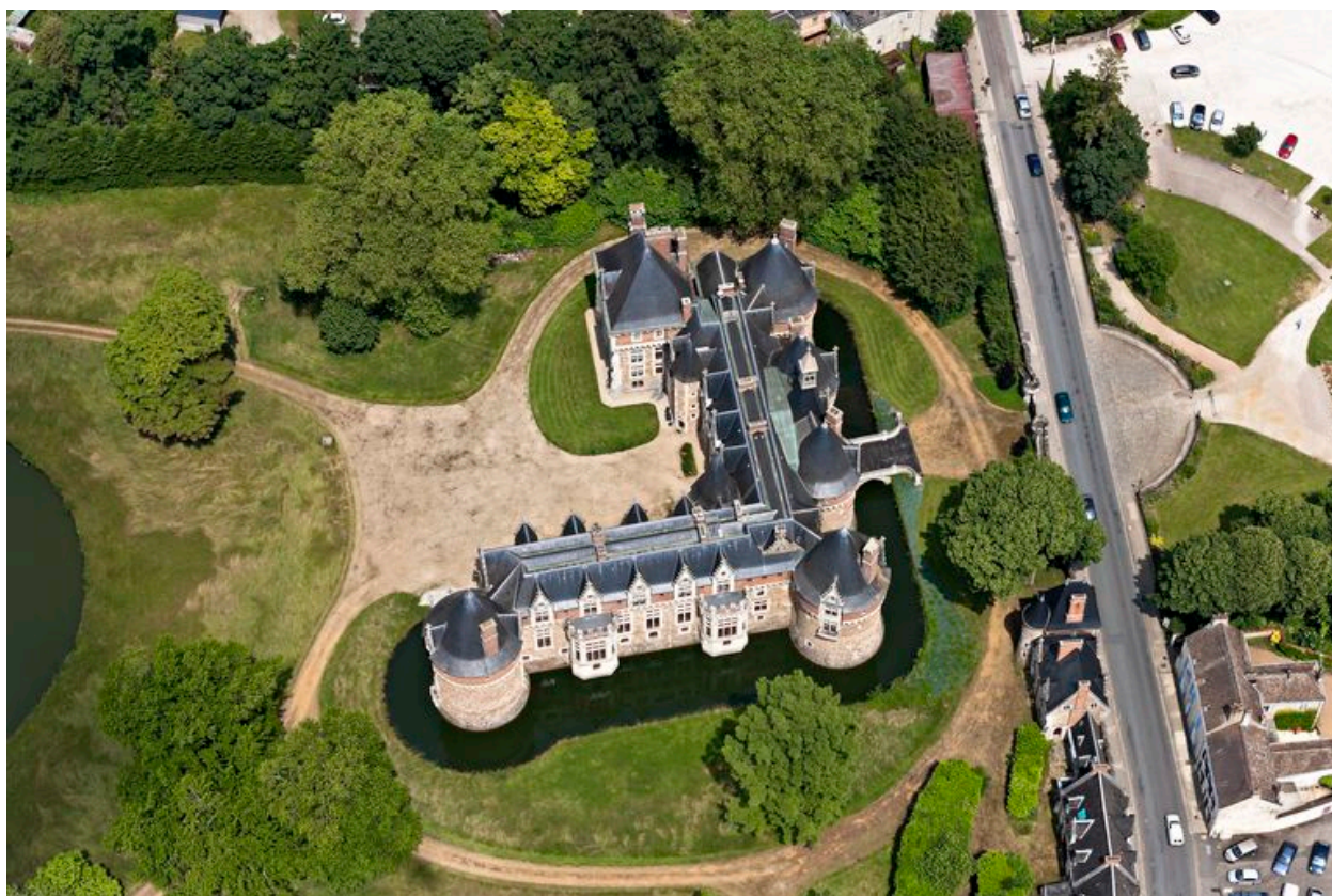
Vue aérienne de la toiture.
