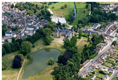
Vue aérienne générale depuis l'ouest. Phot. Yves Guillotin IVR52_20137201209NUCA
