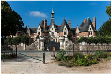
Le corps principal vu depuis la rue. Phot. Yves Guillotin IVR52_20147202070NUCA
