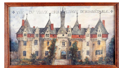
Vue de la façade est du château, avant la restauration du dernier quart du XIXe siècle. Phot. Bernard (reproduction) Renoux IVR52_20167200033NUCA
