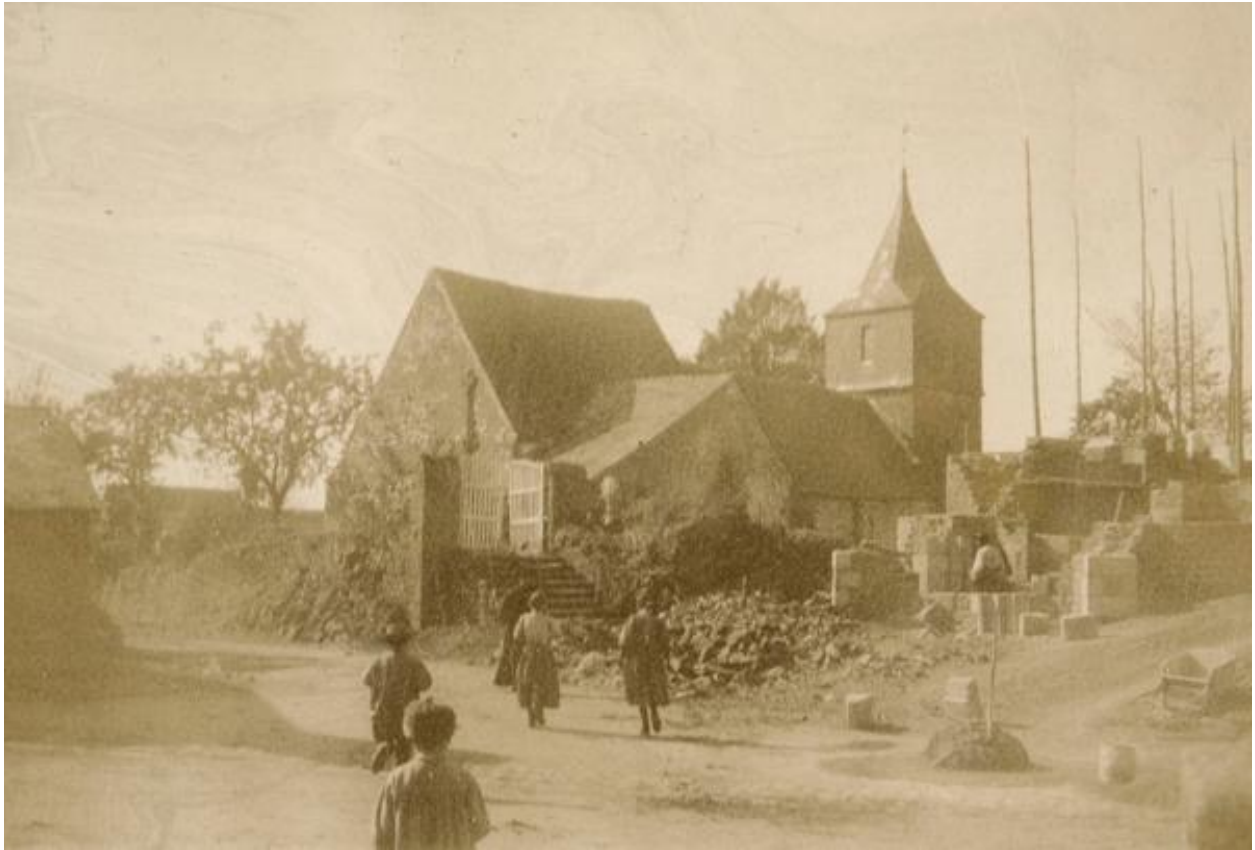
L'ancienne église du Housseau et l'actuelle en construction, 1900.
