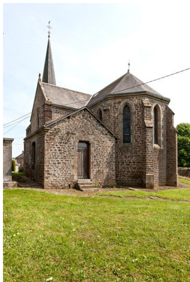
Vue de l'église du Housseau, chevet et sacristie. Phot. Yves Guillotin IVR52_20185300207NUCA
