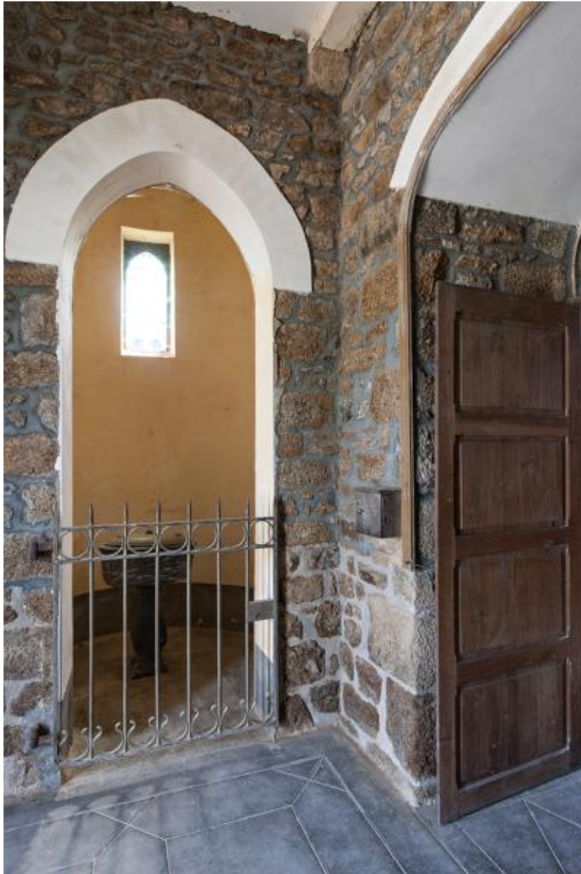
Chapelle des fonts de l'église du Housseau, vue depuis la tour clocher.
