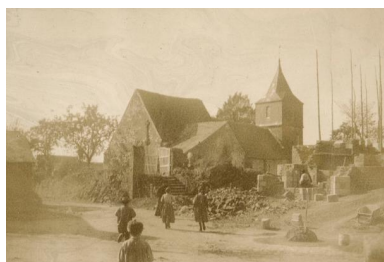
L'ancienne église du Housseau et l'actuelle en construction, 1900. Repro. Morgane Acou-Le Noan IVR52_20205300522NUCA
