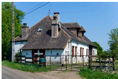
Vue générale depuis l'ouest. Phot. Yves Guillotin IVR52_20117200554NUCA
