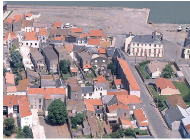
Vue aérienne, 1998, la maison est isolée sur la place Frégate Aréthuse, à droite. Autr. Christophe Yvernogeu, Phot. François Lasa IVR52_20054401344NUCA
