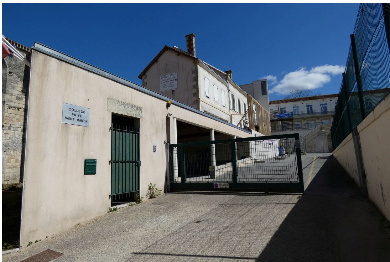
L'entrée du collège, à l'ouest.
