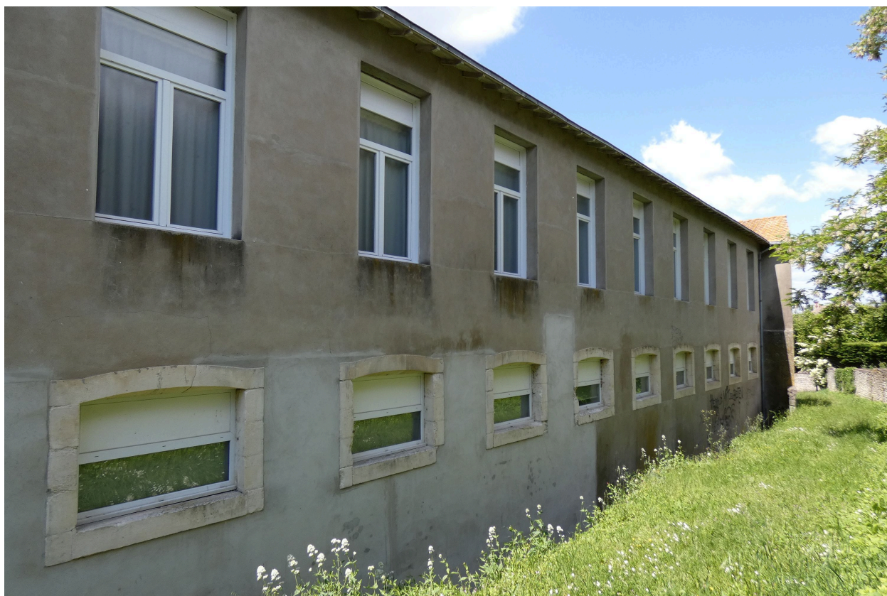
Elévation est du bâtiment est.
