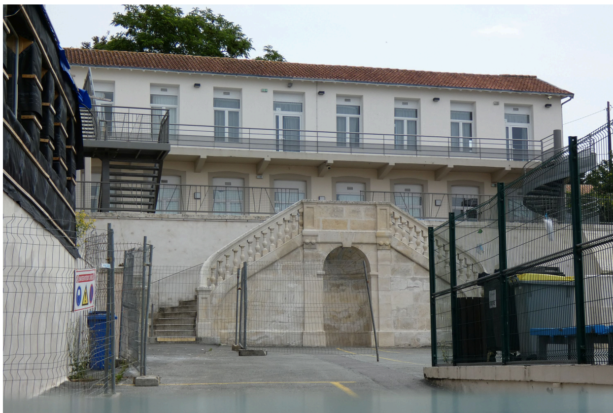
La cour ouest, l'escalier, puis la cour et le bâtiment est, vus depuis l'ouest.
