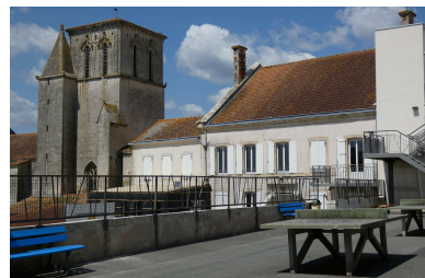
L'ancienne demeure, au nord de l'ensemble, vue depuis le sud. Phot. Yannis Suire IVR52_20238501521NUCA
