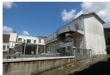
Le bâtiment est vu depuis le sud-ouest.
