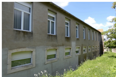
Elévation est du bâtiment est.
