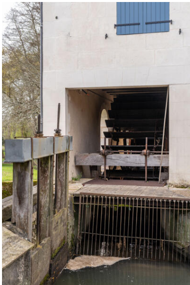
La cage de la roue et les vannes. Phot. Jeanne Minier IVR52_20267200304NUCA
