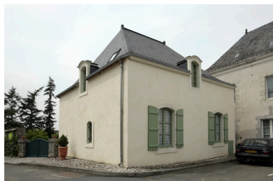
Vue depuis la place au sud-est. Phot. François Lasa IVR52_20075302178NUCA
