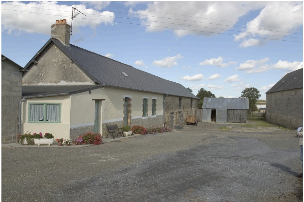
La ferme ouest vue depuis l'entrée de la cour au sud.
