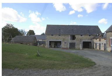
La ferme est vue depuis l'est : la resserre, l'étable, la porcherie. Au fond, la toiture de la ferme ouest. Phot. François Lasa IVR52_20045303047NUCA
