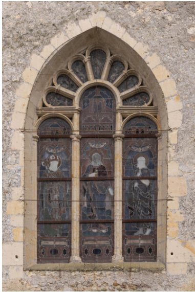
Fenêtre du pignon du bras nord du transept. Phot. Jeanne Minier IVR52_20267200311NUCA
