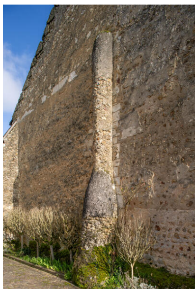
Contrefort hémicirculaire du pignon ouest. Phot. Jeanne Minier IVR52_20267200296NUCA
