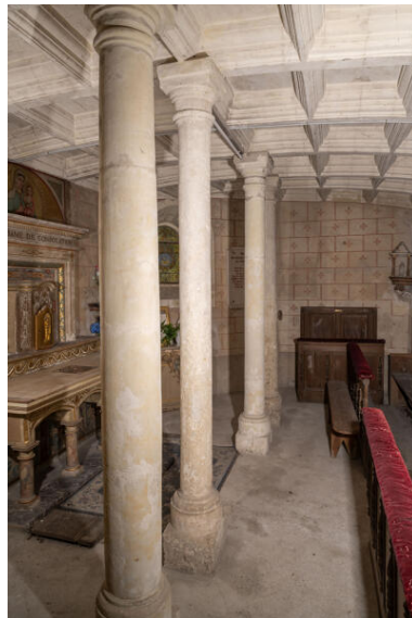
Chapelle basse : vue d'ensemble depuis le nord. Phot. Jeanne Minier IVR52_20267200187NUCA
