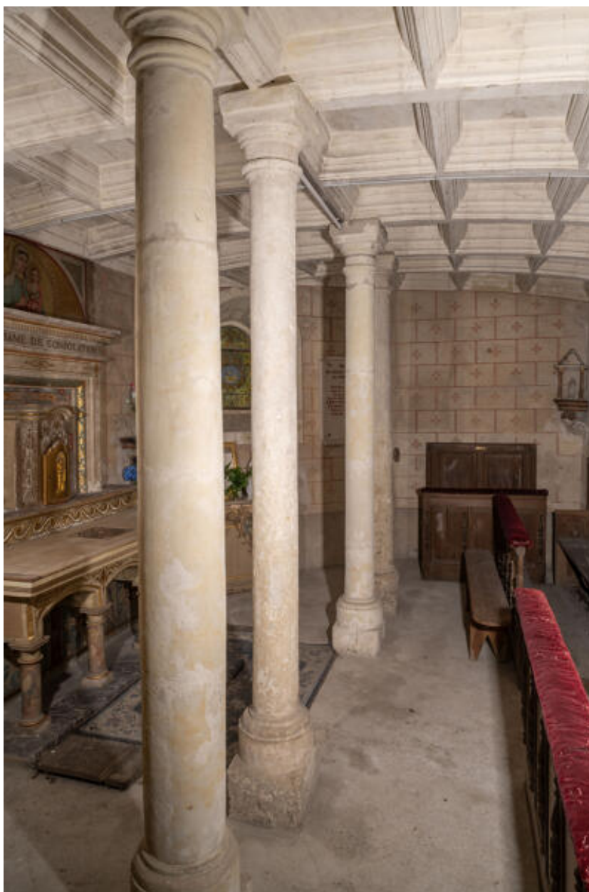
Chapelle basse : vue d'ensemble depuis le nord.
