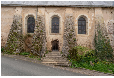
Le mur sud de la nef : vue frontale. Phot. Jeanne Minier IVR52_20267200308NUCA
