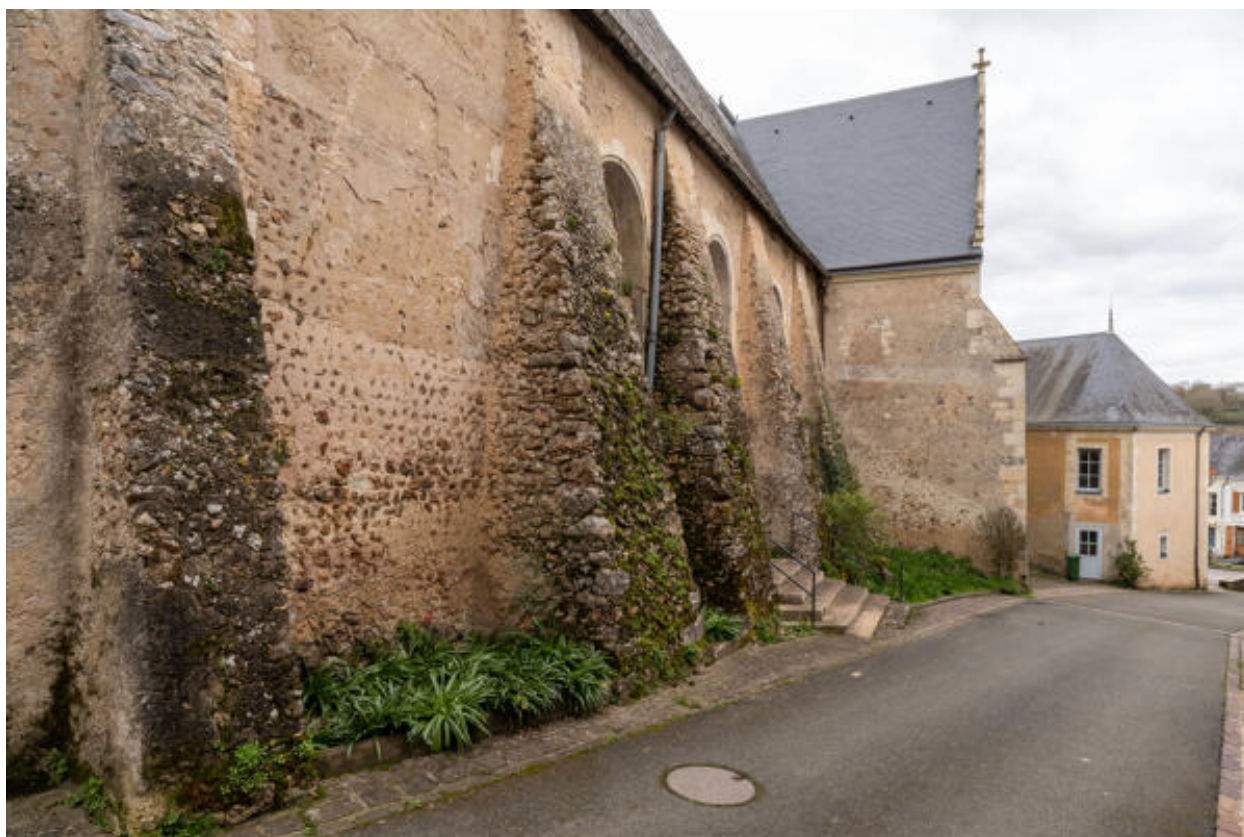
Le mur sud de la nef.
