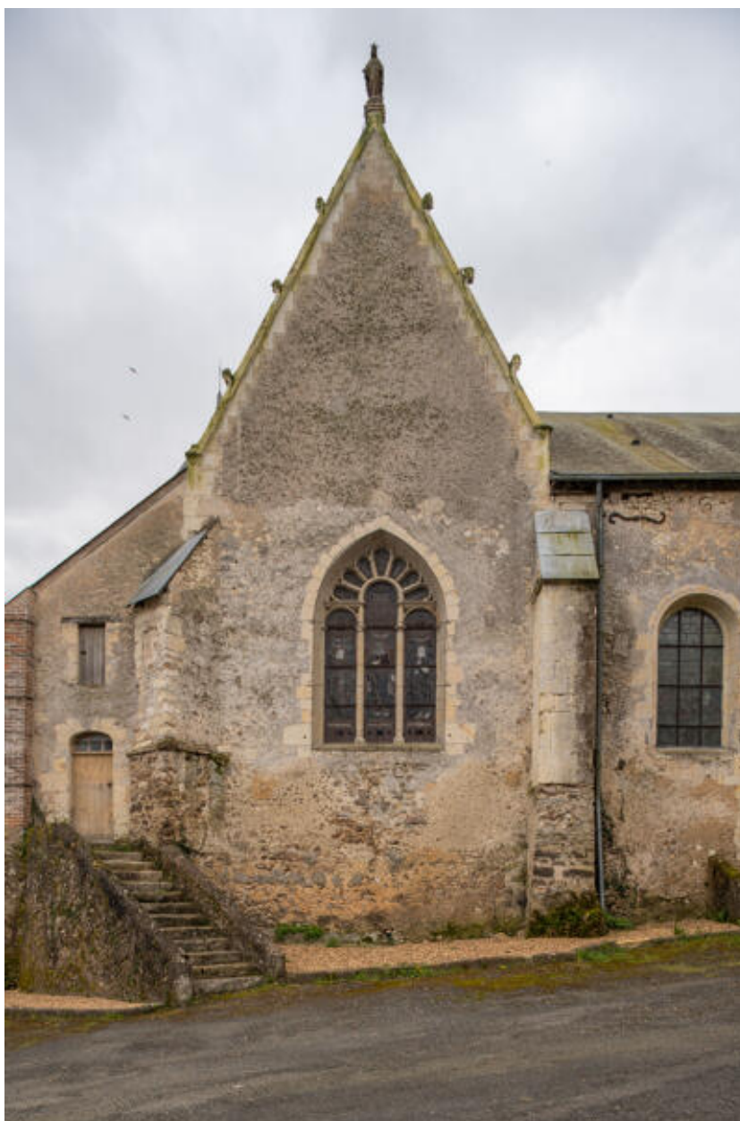
Le pignon du bras nord du transept.
