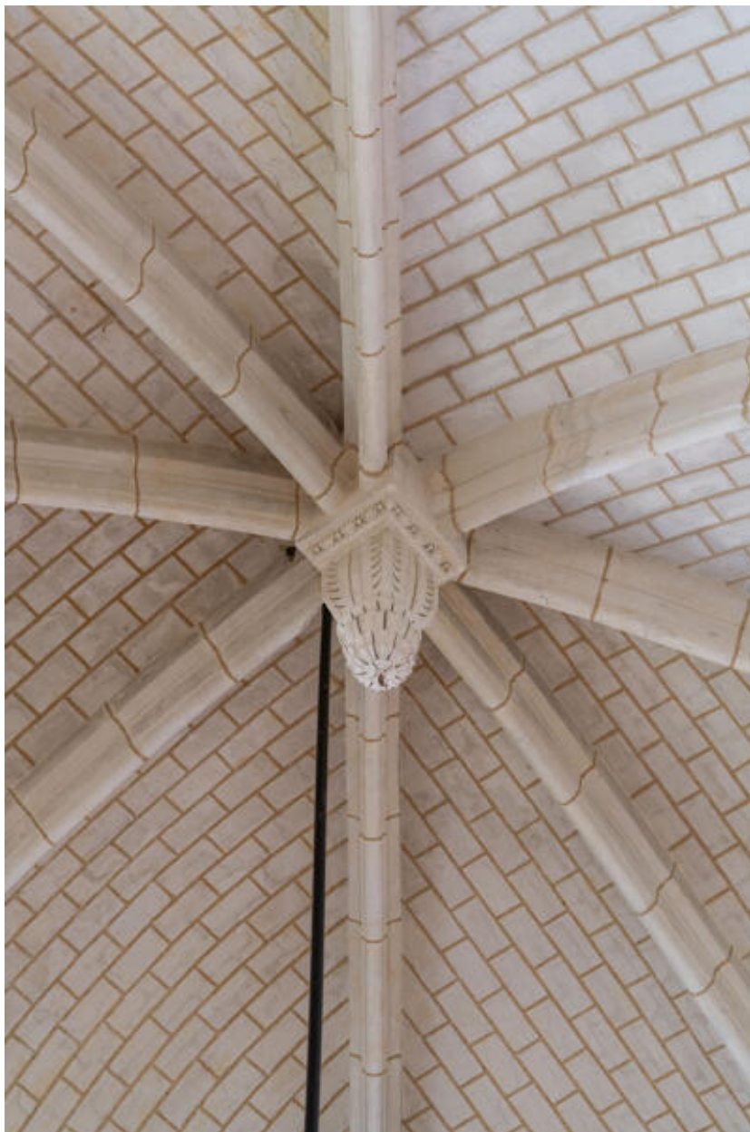
Voûte de la croisée du transept.
