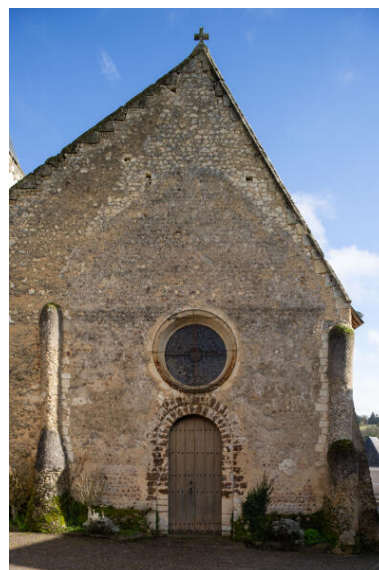
Le pignon ouest. Phot. Jeanne Minier IVR52_20267200237NUCA
