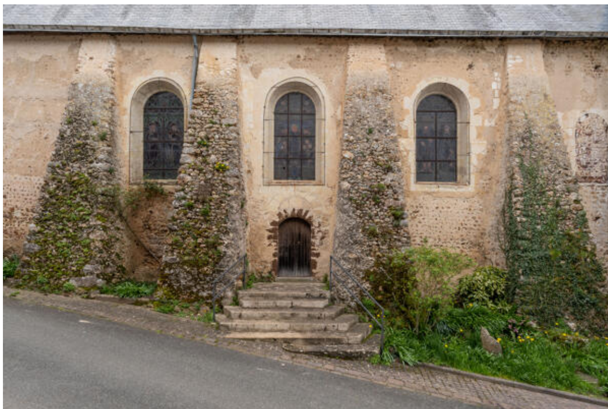
Le mur sud de la nef : vue frontale.
