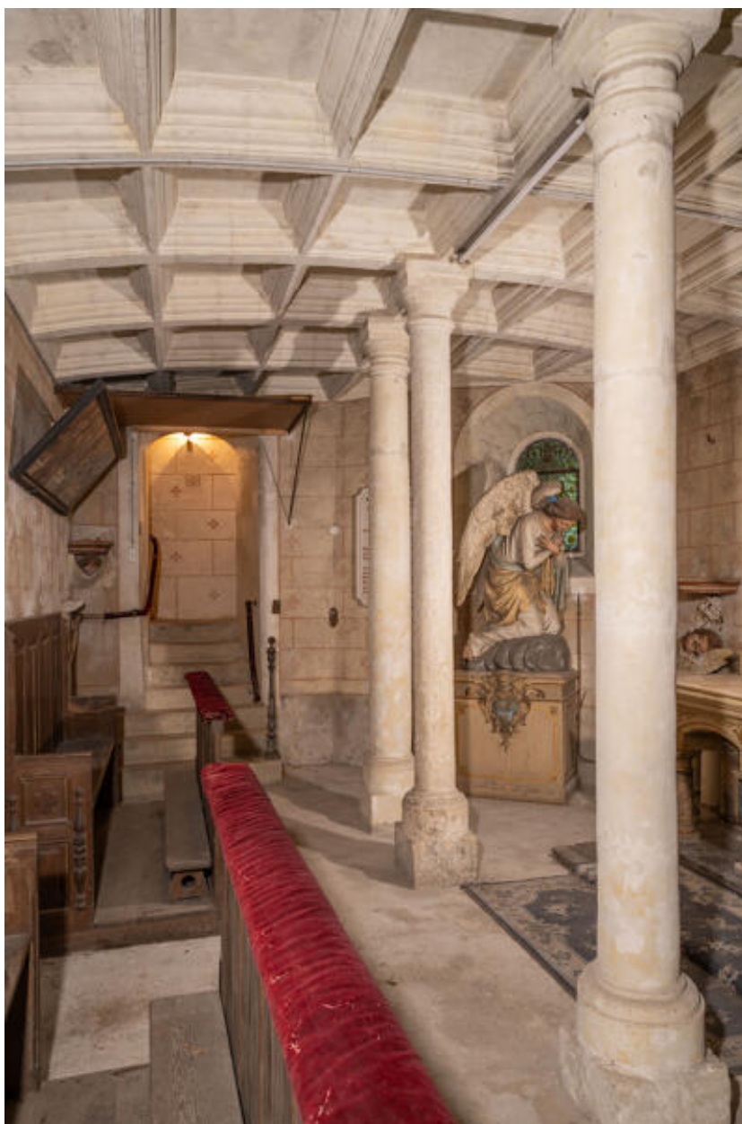
Chapelle basse : vue d'ensemble depuis le sud.
