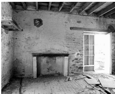
Rez-de-chaussée du moulin : cheminée adossée au mur ouest et porte d'entrée. Phot. François Lasa IVR52_20015300674X
