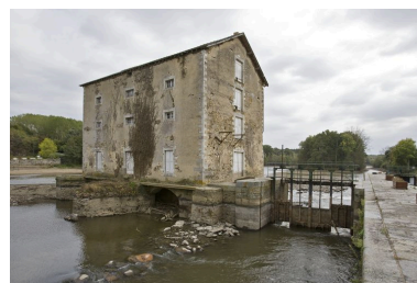
Vue de trois-quarts depuis l'écluse en amont, pendant les écourues de 2009 : façades nord et ouest, pertuis.
