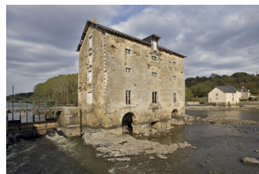
Vue de trois-quarts depuis l'écluse en aval, pendant les écourues de 2009 : façades ouest et sud. A gauche, le pertuis ; à droite le moulin situé rive gauche (à Fromentières).
