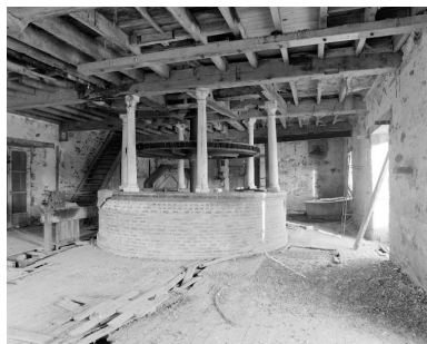
Rez-de-chaussée du moulin : la poquerie où est rassemblée la transmission. A gauche, la vanne d'amont de la turbine. Phot. François Lasa IVR52_20015300673X
