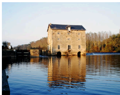
Vue depuis la rive droite en aval : écluse, pertuis, façade sud.
