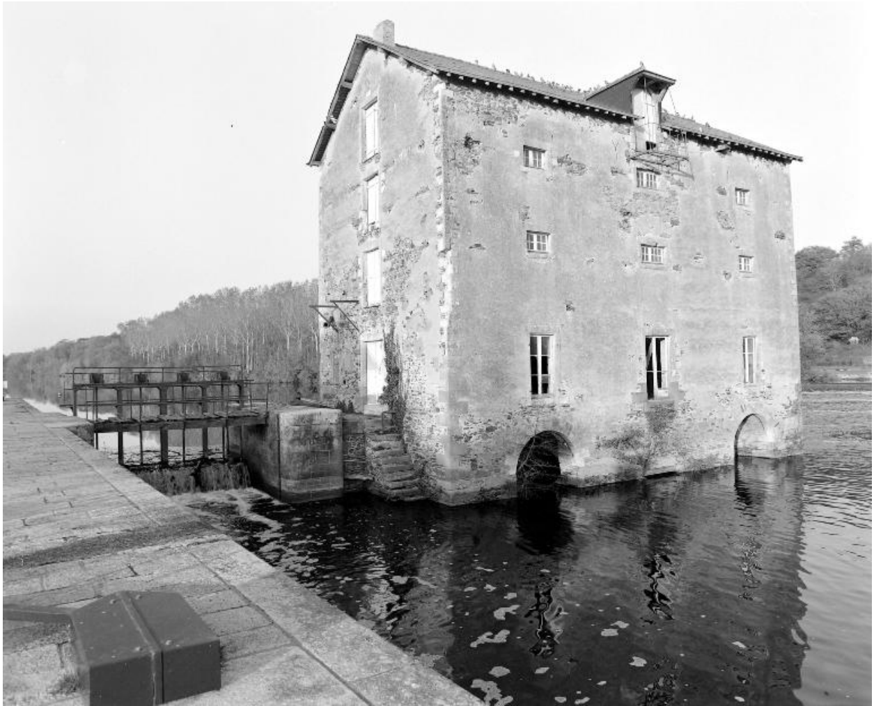
Vue de trois-quarts depuis l'écluse en aval : façades ouest et sud. A gauche, le pertuis.
