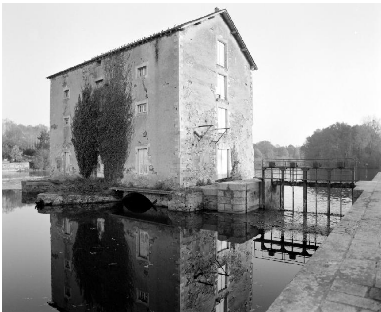
Vue de trois-quarts depuis l'écluse en amont : façades nord et ouest, pertuis.
