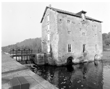
Vue de trois-quarts depuis l'écluse en aval : façades ouest et sud. A gauche, le pertuis.
