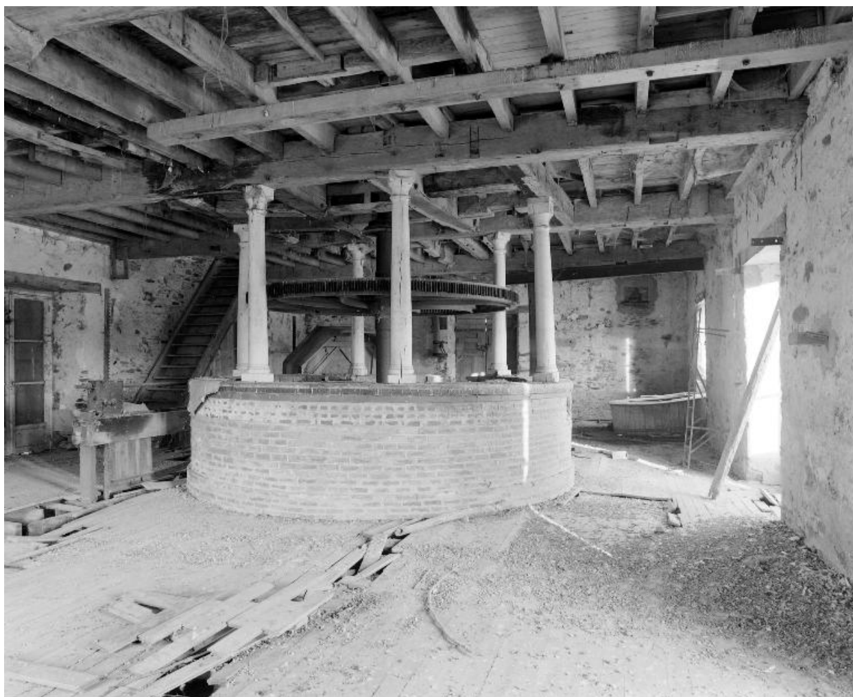
Rez-de-chaussée du moulin : la poquerie où est rassemblée la transmission. A gauche, la vanne d'amont de la turbine.
