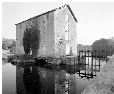
Vue de trois-quarts depuis l'écluse en amont : façades nord et ouest, pertuis.
