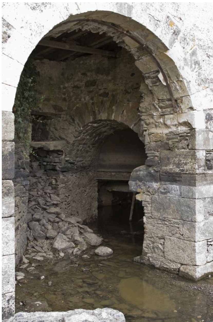
Vue de détail de la façade sud, pendant les écourues de 2009 : sortie du coursier ouest.
