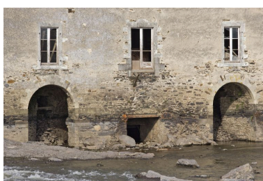
Vue partielle de la façade sud, pendant les écourues de 2009 : sorties des deux coursiers latéraux (où prenaient place les roues hydrauliques), et du coursier central (correspondant à la turbine).
