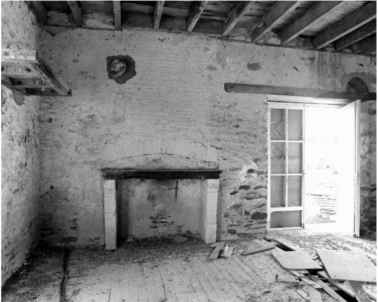
Rez-de-chaussée du moulin : cheminée adossée au mur ouest et porte d'entrée.
