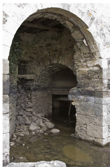
Vue de détail de la façade sud, pendant les écourues de 2009 : sortie du coursier ouest.
