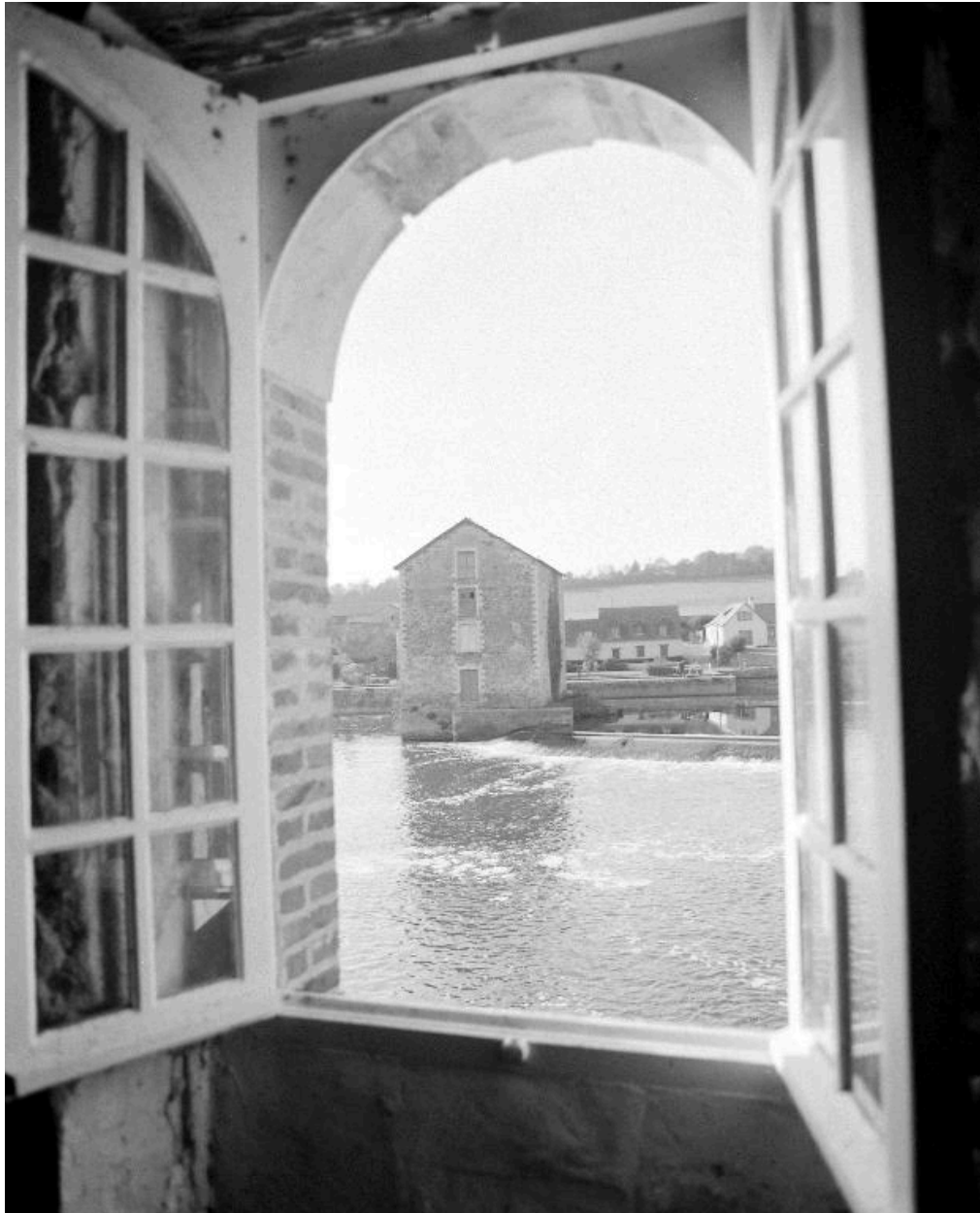
Vue depuis le premier étage du moulin situé rive gauche à Fromentières : façade ouest et anciennes dépendances (défigurées).
