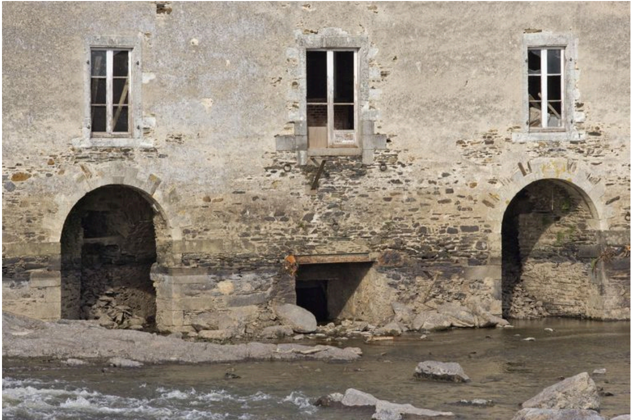
Vue partielle de la façade sud, pendant les écourues de 2009 : sorties des deux coursiers latéraux (où prenaient place les roues hydrauliques), et du coursier central (correspondant à la turbine).
