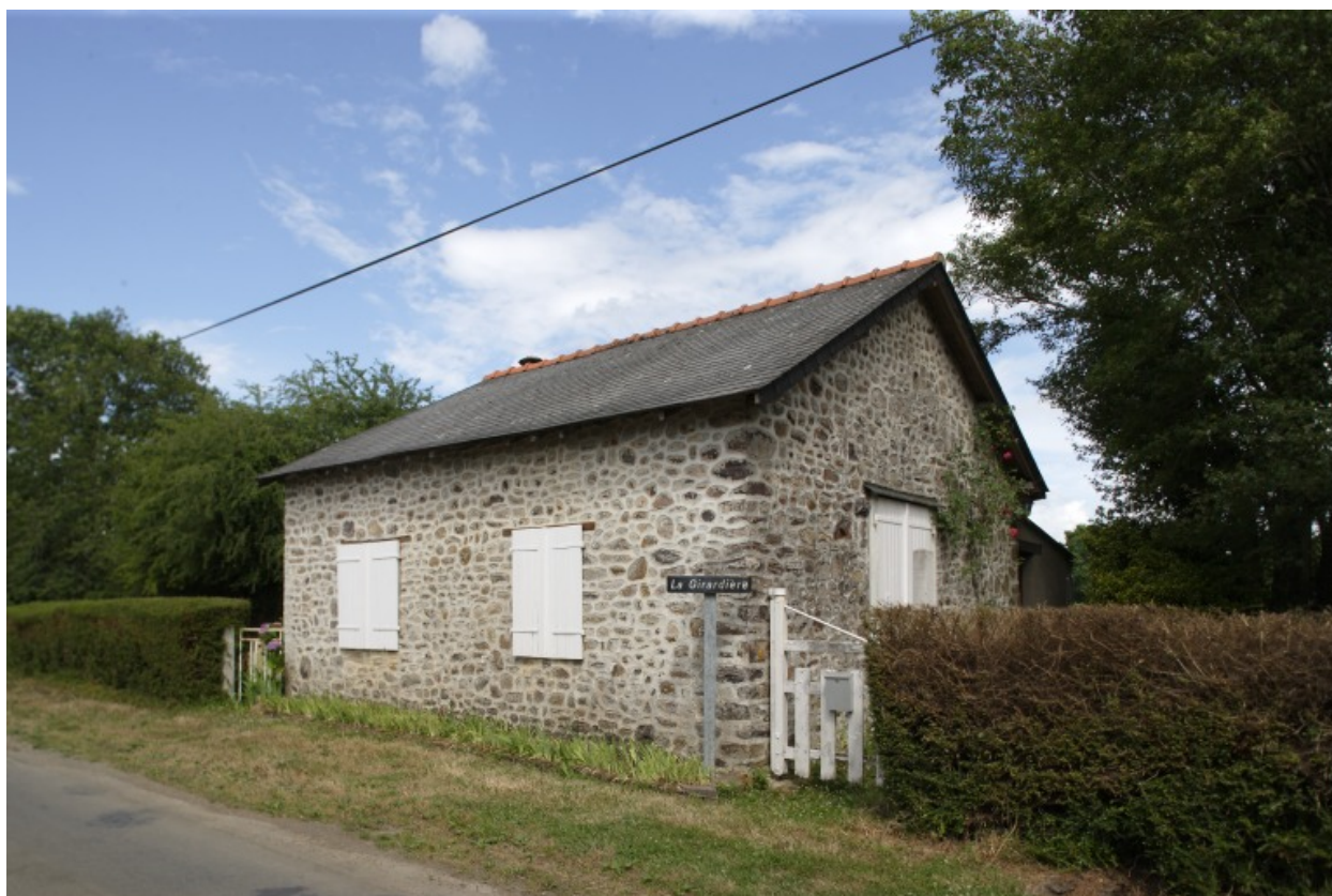
Vue depuis la route au sud-ouest.
