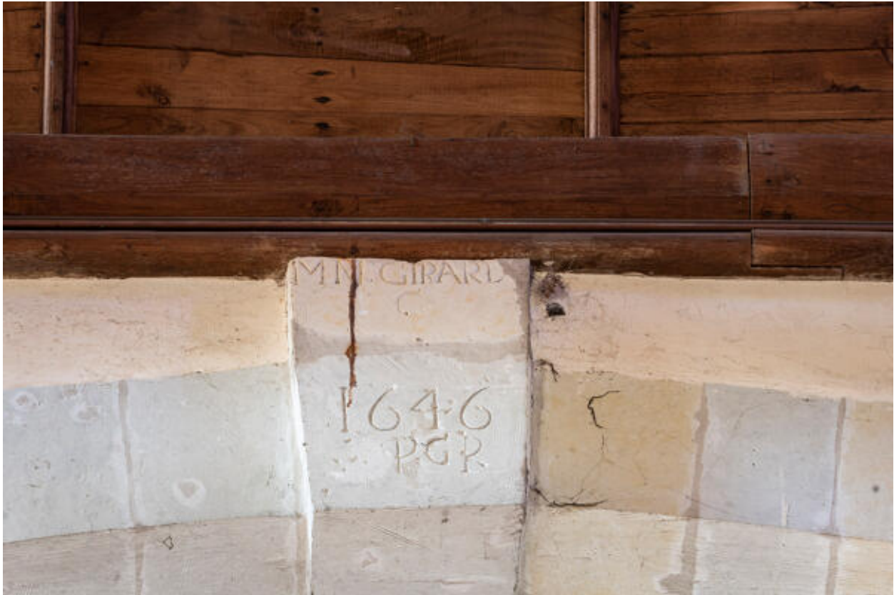
La date portée sur l'arc de la chapelle nord.
