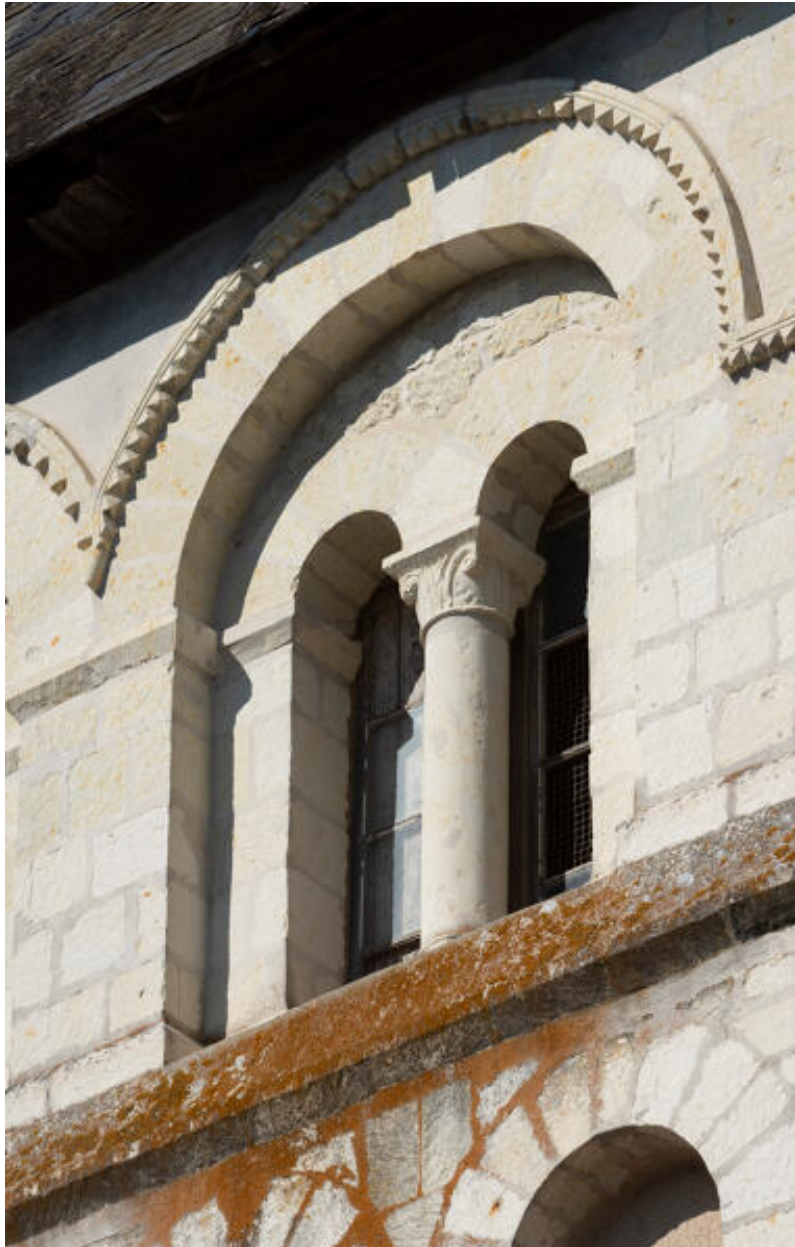
Le clocher, détail des baies géminées.
