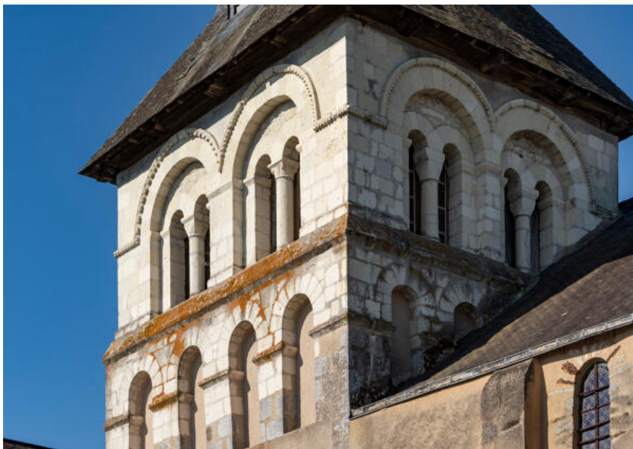
Le clocher, détail des arcatures et des baies géminées.
