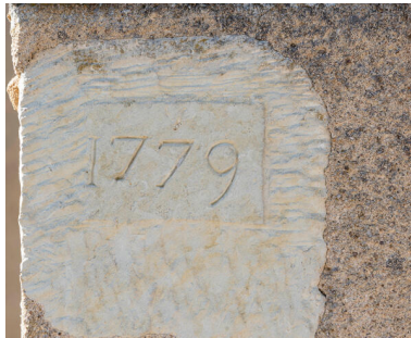
La sacristie, date portée. Phot. Thierry Seldubuisson IVR52_20225300801NUCA
