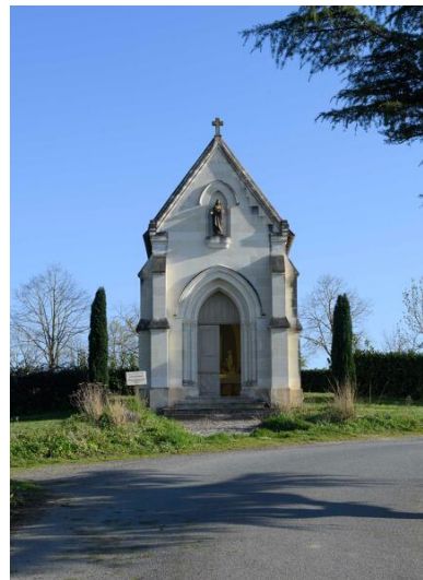
Chapelle Notre-Dame de la Salette. Vue depuis le sud. Phot. Armelle Maugin IVR52_20254900408NUCA
