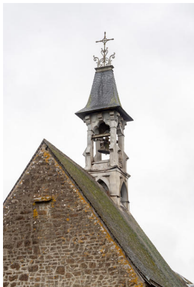
Le campanile surmontant l'ancien porche. Phot. Pierre-Bernard Fourny IVR52_20215300428NUCA
