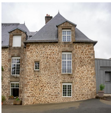
Le pavillon nord du château. Phot. Pierre-Bernard Fourny IVR52_20215300431NUCA
