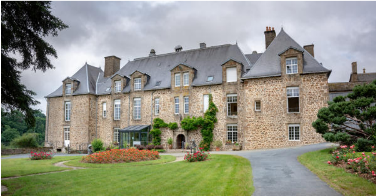
La façade antérieure du château.
