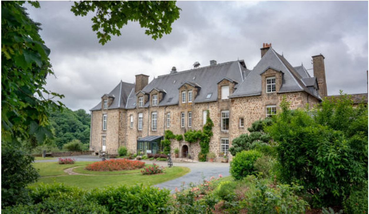
La façade antérieure du château.
