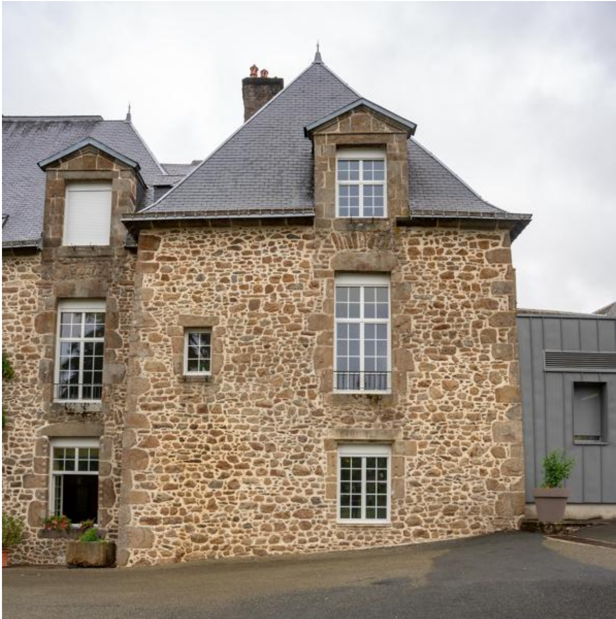
Le pavillon nord du château.
