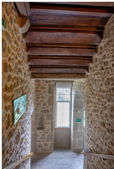
L'escalier du château. Phot. Pierre-Bernard Fourny IVR52_20215300437NUCA
