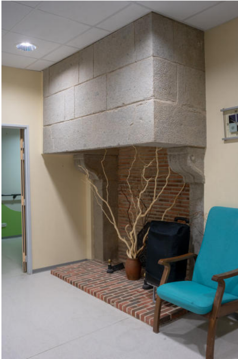
Une cheminée du premier étage.
