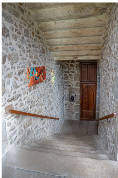
L'escalier du château. Phot. Pierre-Bernard Fourny IVR52_20215300458NUCA
