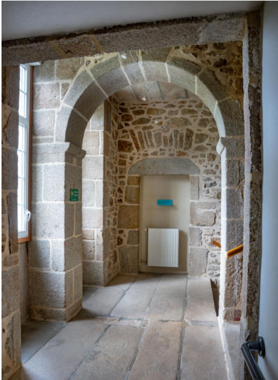
L'escalier du château, palier du premier étage.
