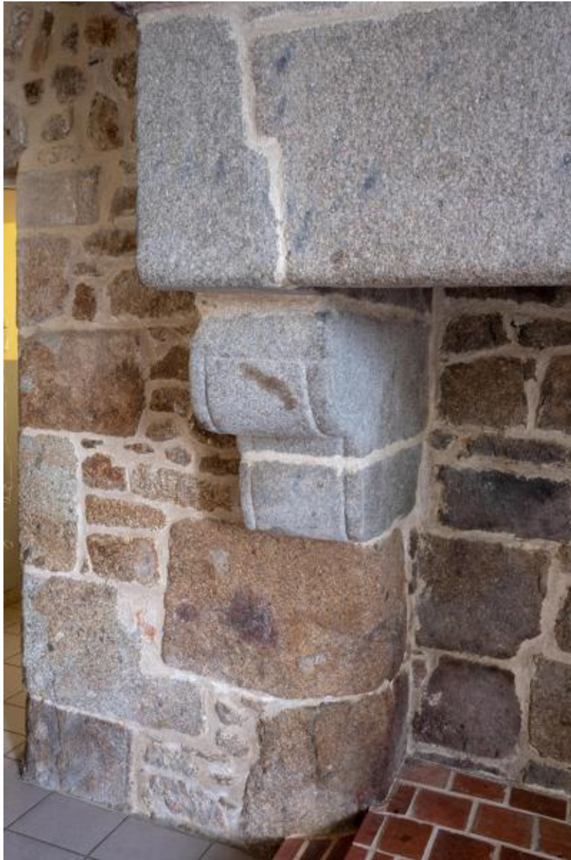
La grande cheminée du rez-de-chaussée du château, détail.
