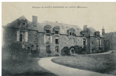
La façade antérieure du château, carte postale du début du XXe siècle. Repro. Morgane Acou-Le Noan IVR52_20215300149NUCA
