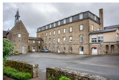
L'ancien dortoir. Phot. Pierre-Bernard Fourny IVR52_20215300424NUCA
