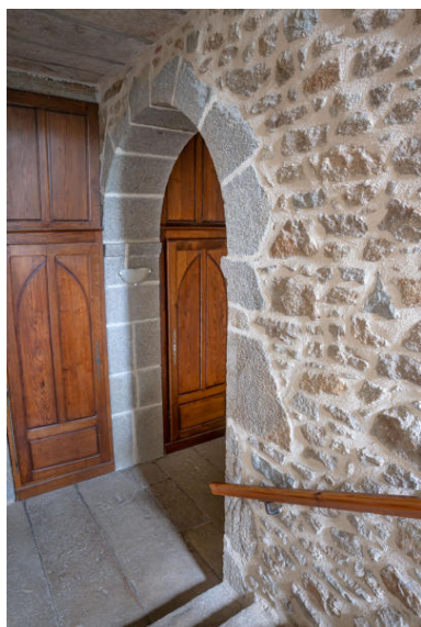
L'escalier du château. Phot. Pierre-Bernard Fourny IVR52_20215300459NUCA
