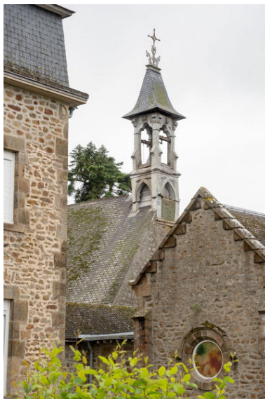
Le campanile surmontant l'ancien porche. Phot. Pierre-Bernard Fourny IVR52_20215300414NUCA
