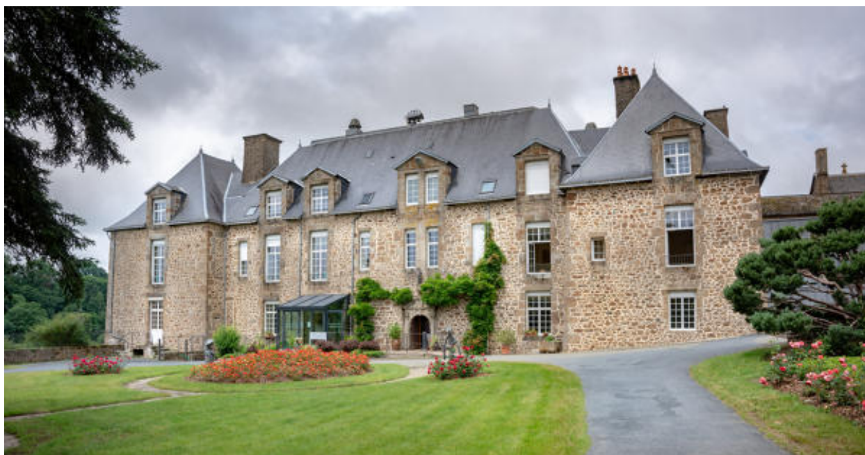
La façade antérieure du château.
