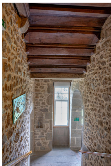
L'escalier du château. Phot. Pierre-Bernard Fourny IVR52_20215300437NUCA
