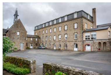
L'ancien dortoir. Phot. Pierre-Bernard Fourny IVR52_20215300424NUCA
