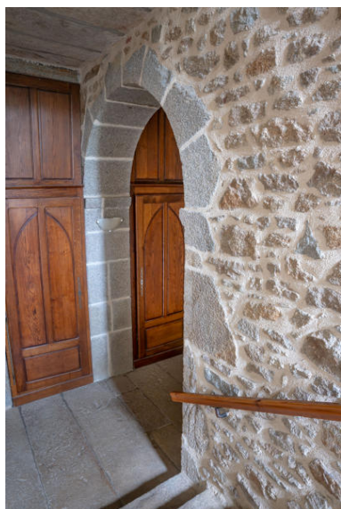
L'escalier du château. Phot. Pierre-Bernard Fourny IVR52_20215300459NUCA
