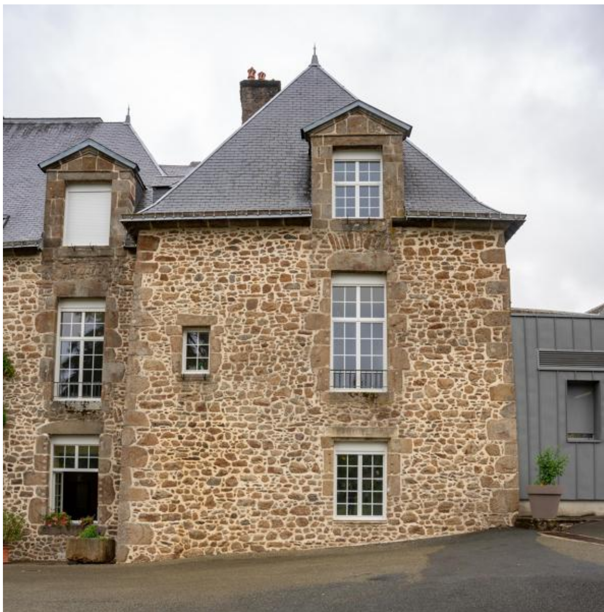
Le pavillon nord du château.
