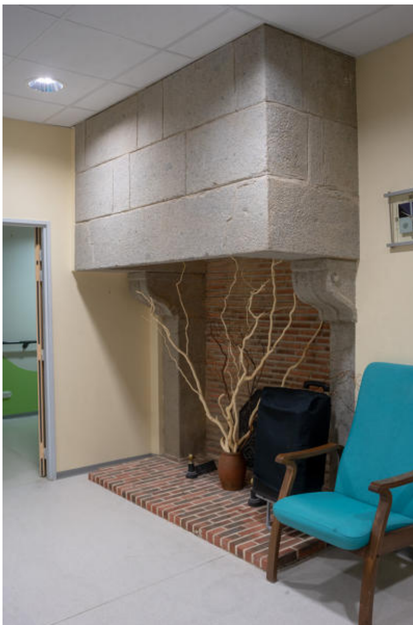
Une cheminée du premier étage.
