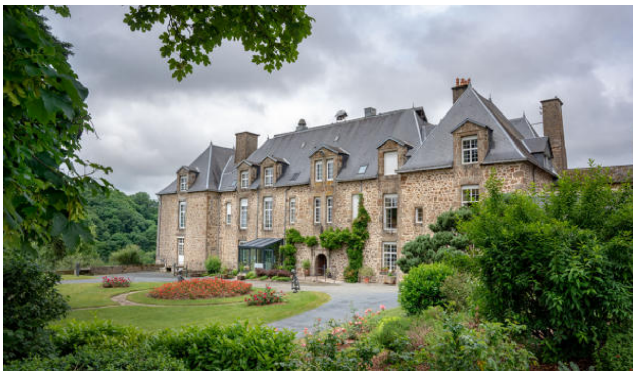
La façade antérieure du château.
