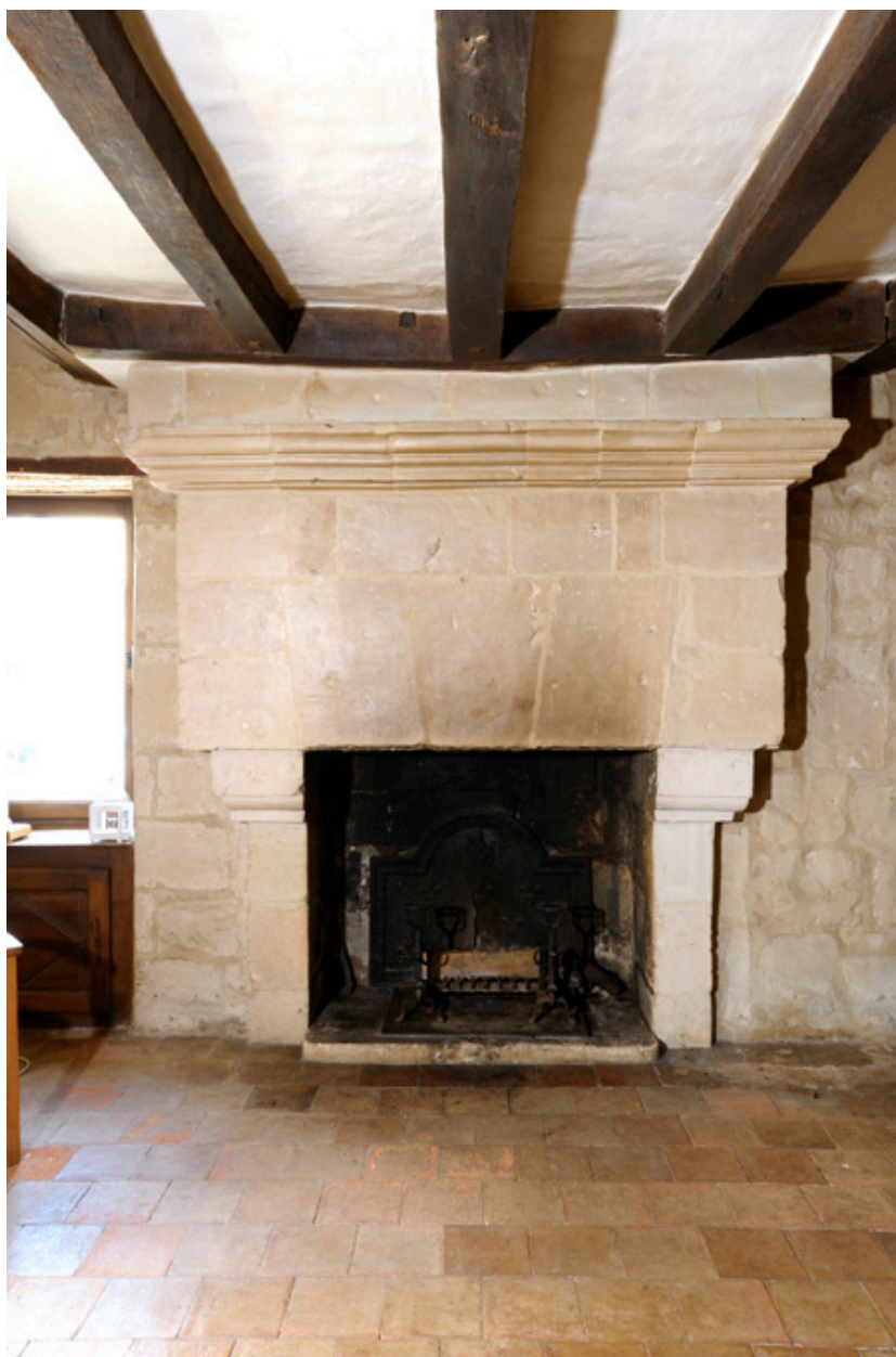
Rez-de-chaussée, salle ouest : cheminée du XVI e siècle.
