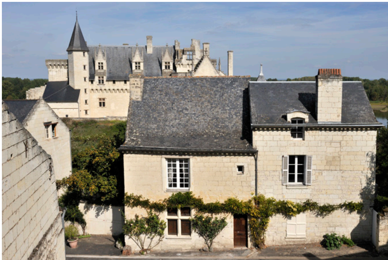
Vue d'ensemble, depuis le chemin du Coteau.
