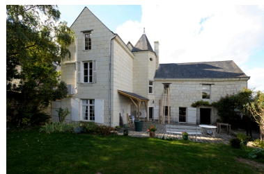
Façades sur cour. Phot. Bruno Rousseau IVR52_20124901914NUCA
