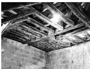
Etage de comble, angle postérieur droit. Phot. François Lasa IVR52_19844901436X
