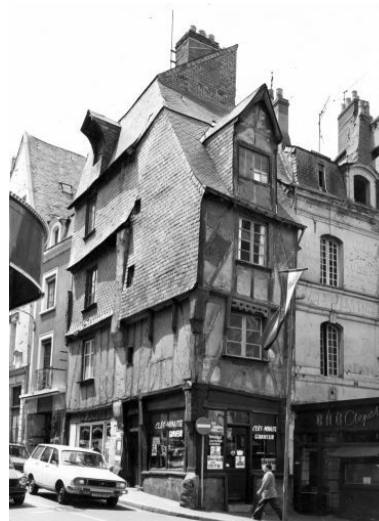
Vue d'ensemble depuis la place du Pilori. Phot. Patrice Giraud IVR52_19794901547X
