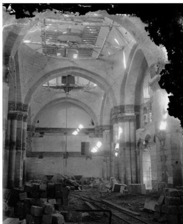
Prison, nef de l'abbatiale en cours de restauration, avec destruction des niveaux de plancher et des cloisonnements, suppression des planchers couvrant les voûtes tronquées (début du XXe siècle).
