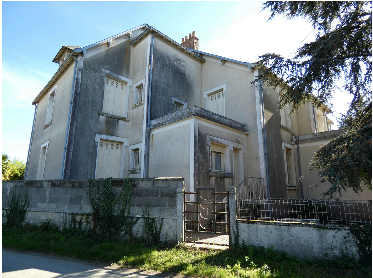
Le logement patronal vu depuis le nord. A droite, le corps principal, à gauche l'aile nord.
