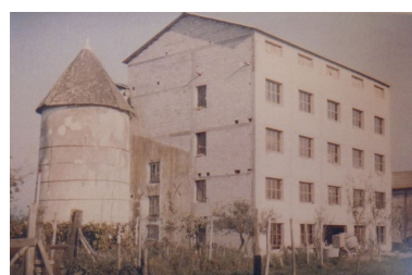
Le bâtiment de broyage, à l'arrière de la minoterie d'origine, en cours de construction en 1963, vu depuis le sud-ouest. Phot. Yannis (reproduction) Suire IVR52_20228501341NUCA
