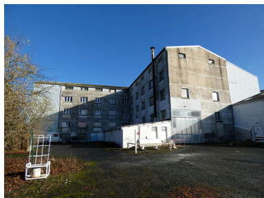
Le bâtiment de broyage de la farine, à gauche, et les silos en retour d'équerre, à droite, vus depuis le sud. Phot. Yannis Suire IVR52_20228500771NUCA
