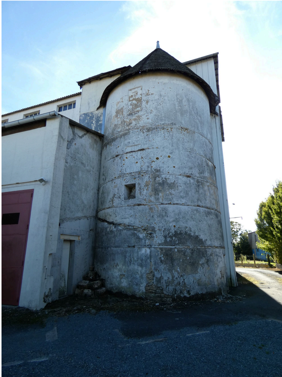
L'ancien moulin, englobé dans les bâtiments de la minoterie, vu depuis le nord.
