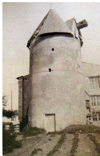
Le moulin, désaffecté, vu depuis l'ouest vers 1930. Phot. Yannis (reproduction) Suire IVR52_20228501338NUCA
