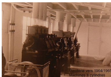
Machines à cylindres dans la nouvelle minoterie vers 1964-1965. Phot. Yannis (reproduction) Suire IVR52_20228501342NUCA
