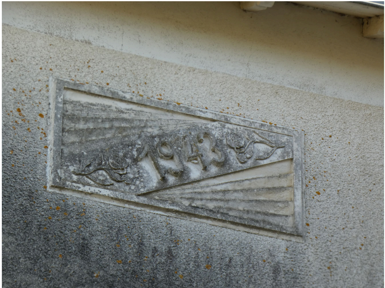
Le cartouche portant la date 1943, sur l'élévation ouest de l'aile nord du logement patronal.
