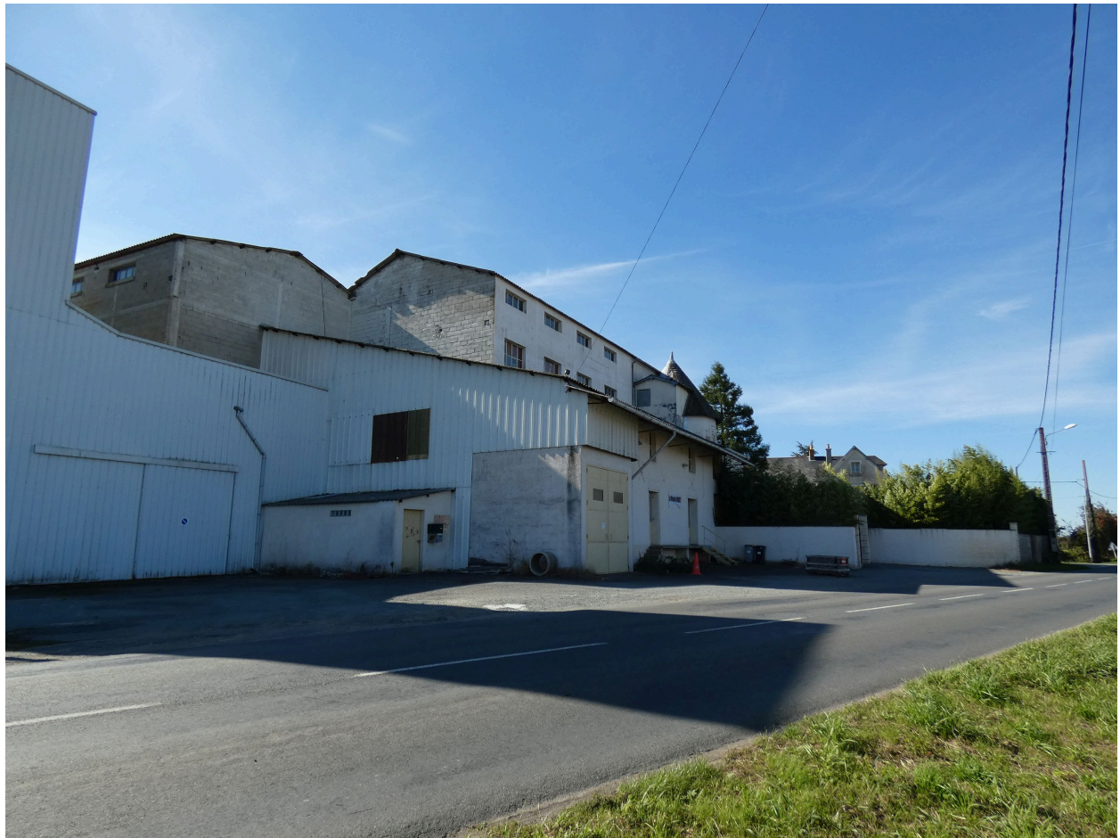
L'ancienne minoterie vue depuis l'est.
