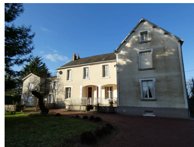
Le logement patronal vu depuis l'est. Phot. Yannis Suire IVR52_20228500768NUCA
