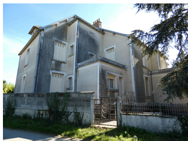
Le logement patronal vu depuis le nord. A droite, le corps principal, à gauche l'aile nord. Phot. Yannis Suire IVR52_20228500734NUCA
