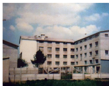
Les nouveaux bâtiments de la minoterie vus depuis le sud-ouest vers 1976. Phot. Yannis (reproduction) Suire IVR52_20228501347NUCA
