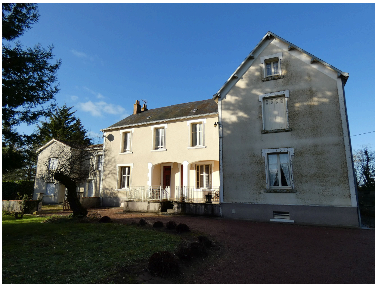
Le logement patronal vu depuis l'est.
