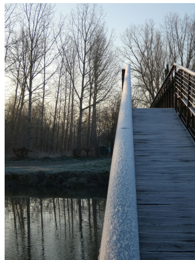
Détail de la passerelle. Phot. Yannis Suire IVR52_20238500212NUCA
