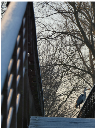
Détail de la passerelle. Phot. Yannis Suire IVR52_20238500211NUCA
