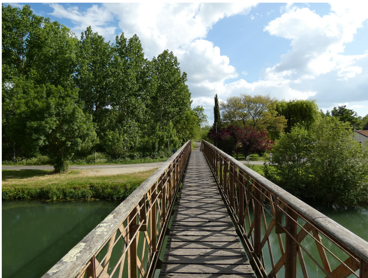
La passerelle vue depuis le nord.
