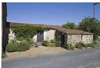
Maison et cellier, 17e-18e siècles. (La Bourchinière). Phot. Yves Guillotin IVR52_20114400602NUCA
