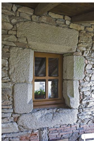
Petite baie à encadrement de granite délardé, 17e siècle. (La Bourchinière). Phot. Yves Guillotin IVR52_20114400599NUCA
