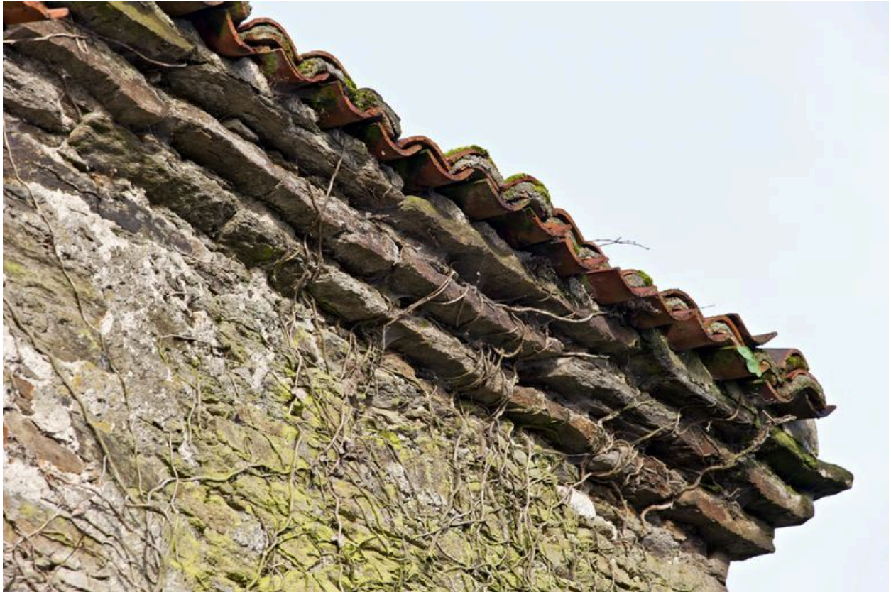
Larmier composé de trois rangées de pierres de schiste, 18e siècle. (Maison de la Hautière)
