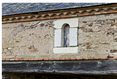
Génoise, première moitié du 19e siècle. (Wilthebert) Phot. Yves Guillotin IVR52_20124401515NUCA
