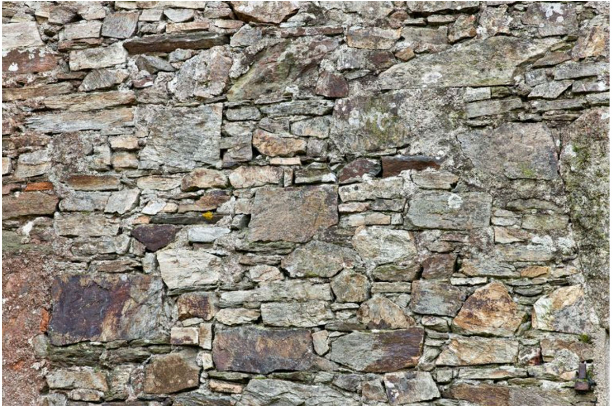
Appareillage irrégulier de moëllons de schiste, 18e siècle. (La Hautière)
