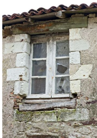
Baie à encadrement de calcaire, 17e-18e siècles. (La Cantrie) Phot. Yves Guillotin IVR52_20124400016NUCA
