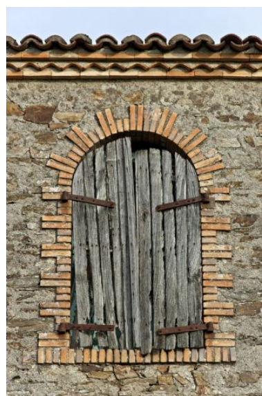
Baie cintrée à encadrement de brique, vers 1860. (Le bourg, rue Beauregard) Phot. Yves Guillotin IVR52_20124400010NUCA
