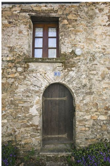
Porte cintrée à arc de schiste et fenêtre à linteau de bois, 18e siècle. (La Bourchinière). Phot. Yves Guillotin IVR52_20114400591NUCA
