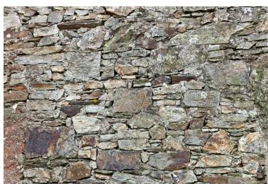
Appareillage irrégulier de moëllons de schiste, 18e siècle. (La Hautière) Phot. Yves Guillotin IVR52_20124400005NUCA
