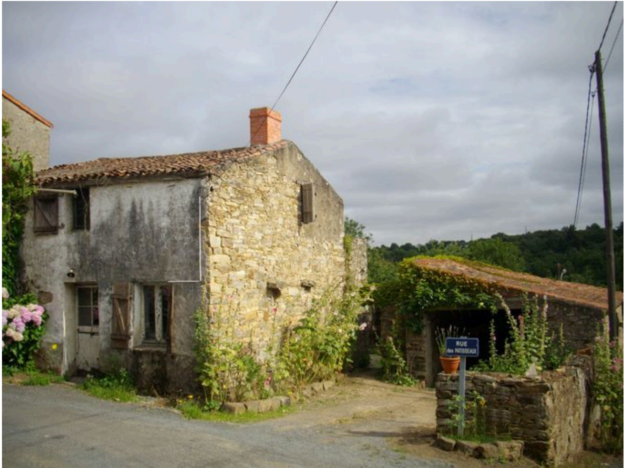
Mur pignon traversé par les corbeaux de pierre de la cheminée, 18e siècle. (La Pétière).
