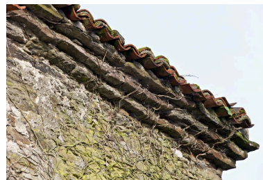
Larmier composé de trois rangées de pierres de schiste, 18e siècle. (Maison de la Hautière) Phot. Yves Guillotin IVR52_20124400003NUCA
