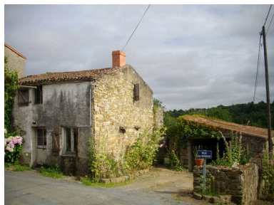
Mur pignon traversé par les corbeaux de pierre de la cheminée, 18e siècle. (La Pétière). Phot. Sylvie Mounier IVR52_20114400717NUCA
