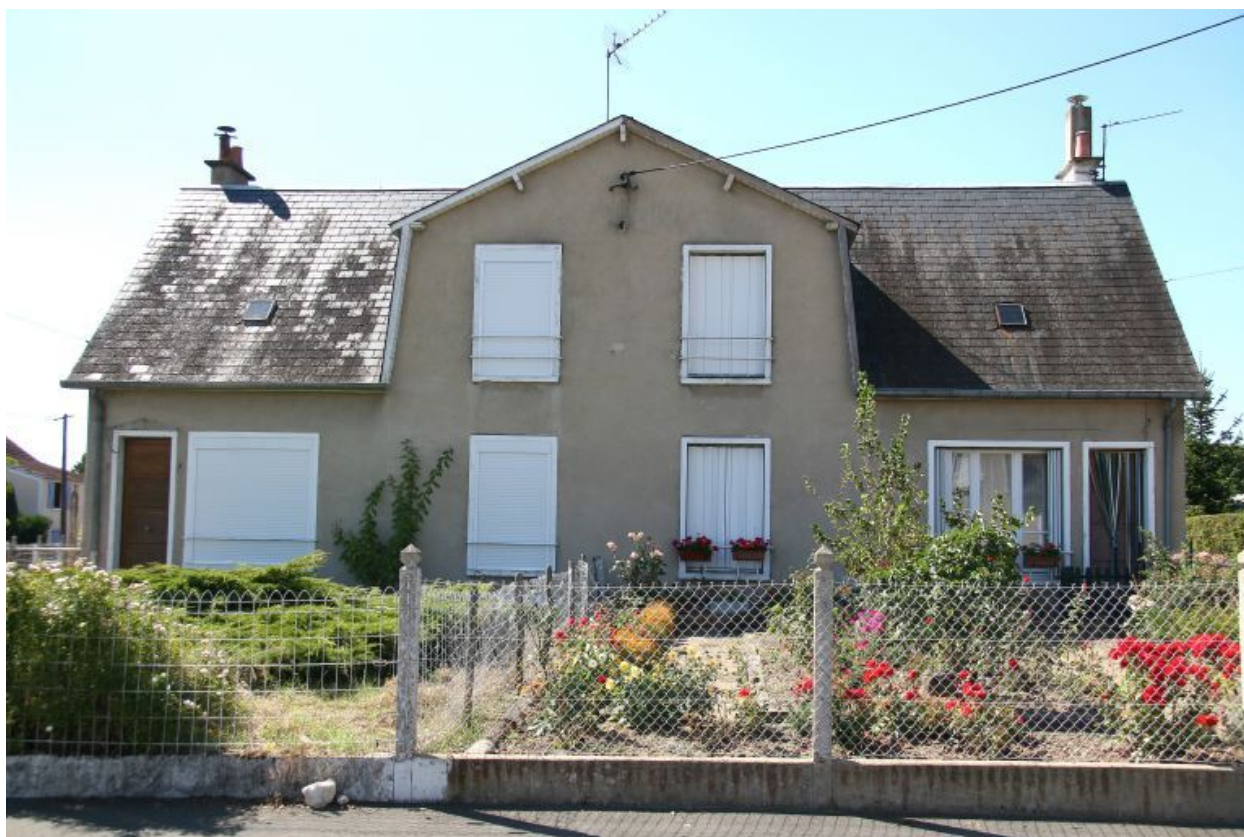
Numéro 1 et 3 : façade sur rue.
