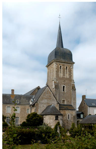
Église de Brissarthe. Phot. Bruno Rousseau IVR52_20064901601NUCA
