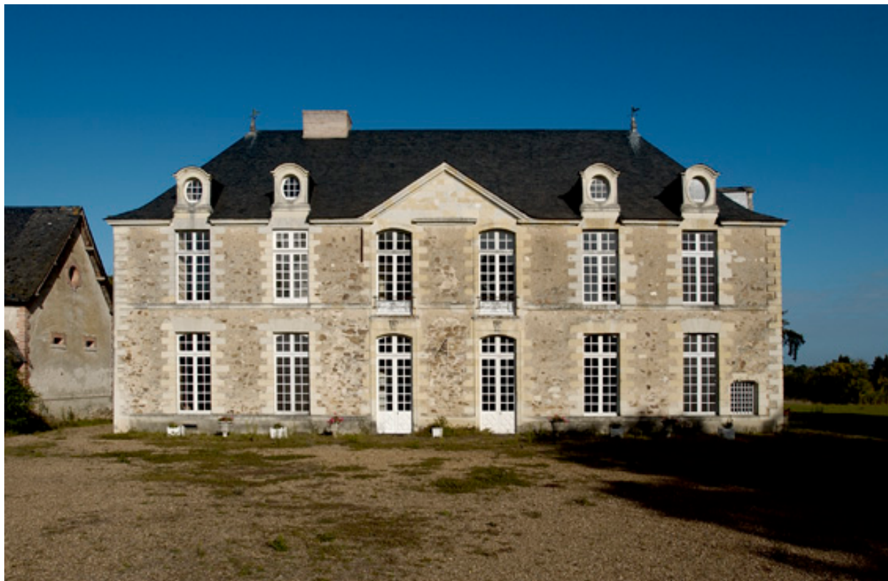
La Cour de Cellières (Juardeil).
