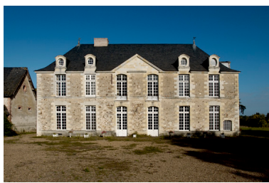
La Cour de Cellières (Juvardeil). Phot. Bruno Rousseau IVR52_20054903385NUCA
