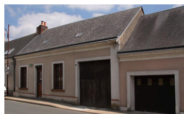
Bourg, maison en rez-de-chaussée, 3 rue de Saint-Hubert. Phot. Jean-Baptiste Darrasse IVR52_20107201245NUCA
