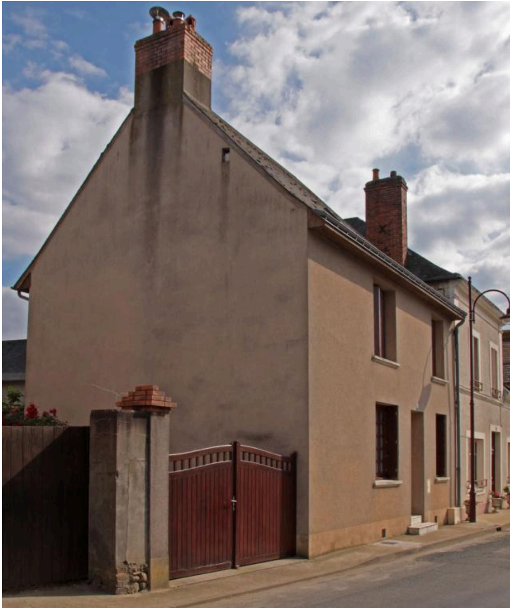
Bourg, maison à étage, 7 rue du Bourg ancien.
