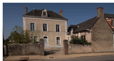
Bourg, maison bourgeoise, 4 rue du 19-mars-1962. Phot. Jean-Baptiste Darrasse IVR52_20107201190NUCA
