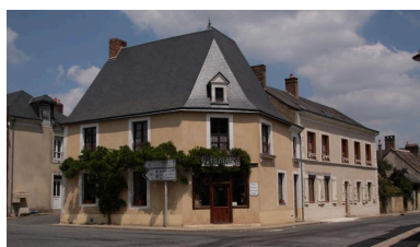
Bourg, maison d'angle (coupé) à étage, 19 place André-Ricordeau. Phot. Jean-Baptiste Darrasse IVR52_20107201233NUCA
