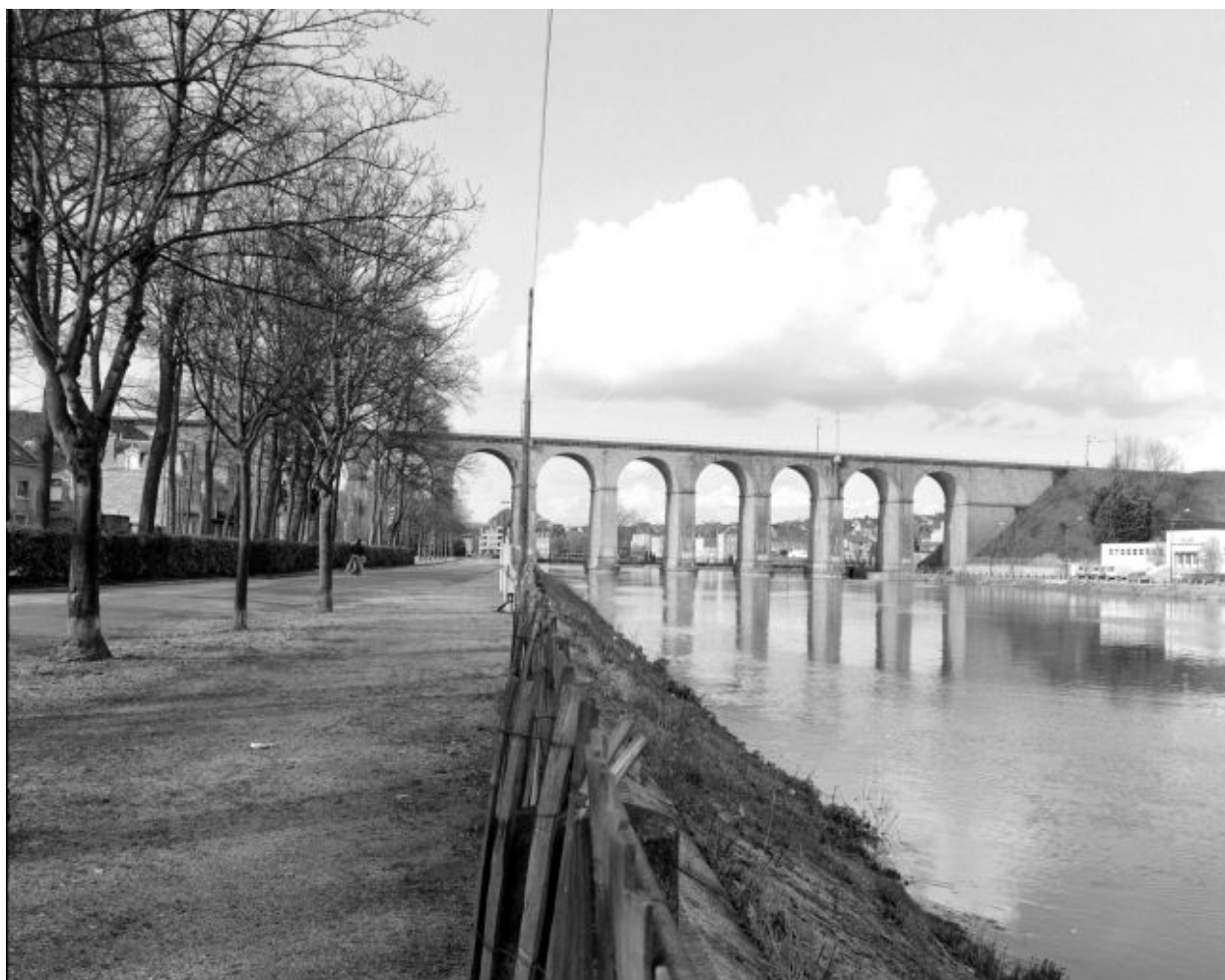
Vue d'ensemble du viaduc depuis la rive droite, en aval.
