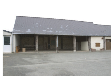
Le préau vu depuis la cour à l'est. Phot. François Lasa IVR52_20045303295NUCA
