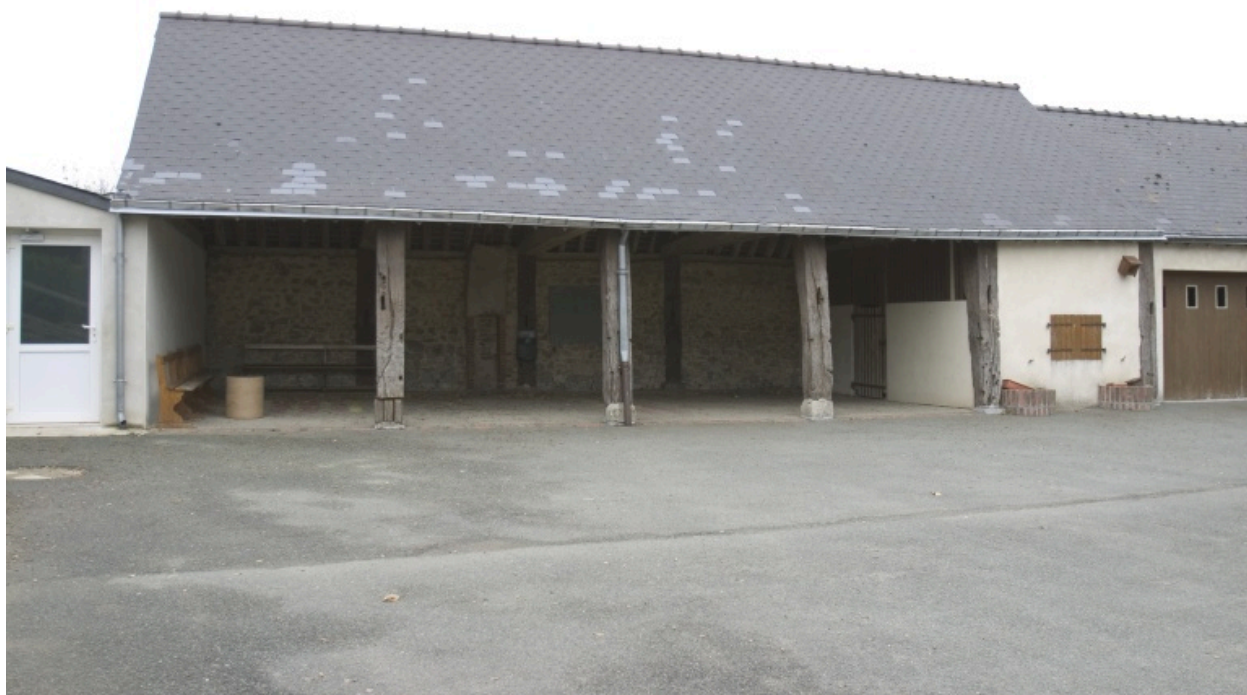
Le préau vu depuis la cour à l'est.
