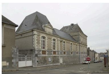
La façade sur la rue vue depuis le sud-est. Phot. François Lasa IVR52_20045303284NUCA
