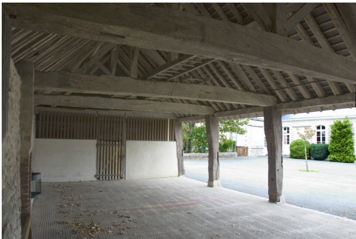
L'intérieur du préau vu depuis le sud-ouest.
