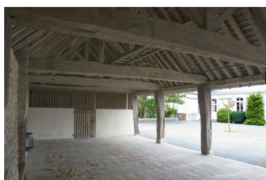
L'intérieur du préau vu depuis le sud-ouest.
