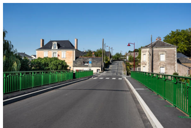
Le pont et l'entrée du bourg de Daon.
