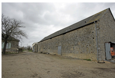
L'étable à vaches-écurie-grange vue depuis la cour au sud-est. Au bout, la remise. Phot. François Lasa
