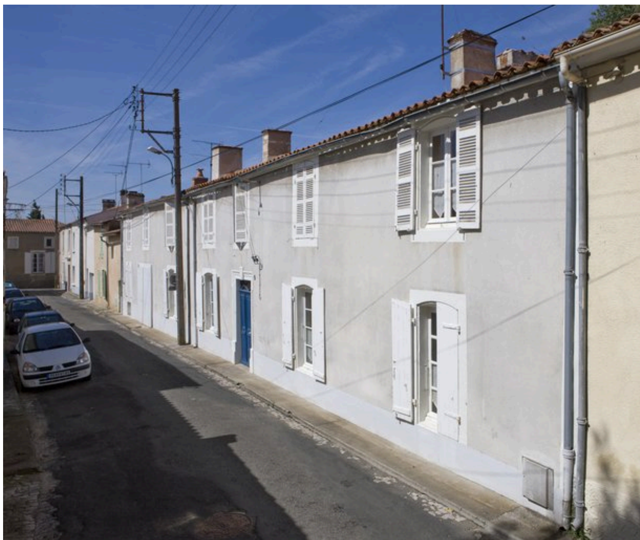
Vue de la façade sur rue, prise du nord.
