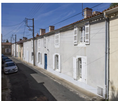
Vue de la façade sur rue, prise du nord. Phot. Patrice Giraud IVR52_20108500348NUCA
