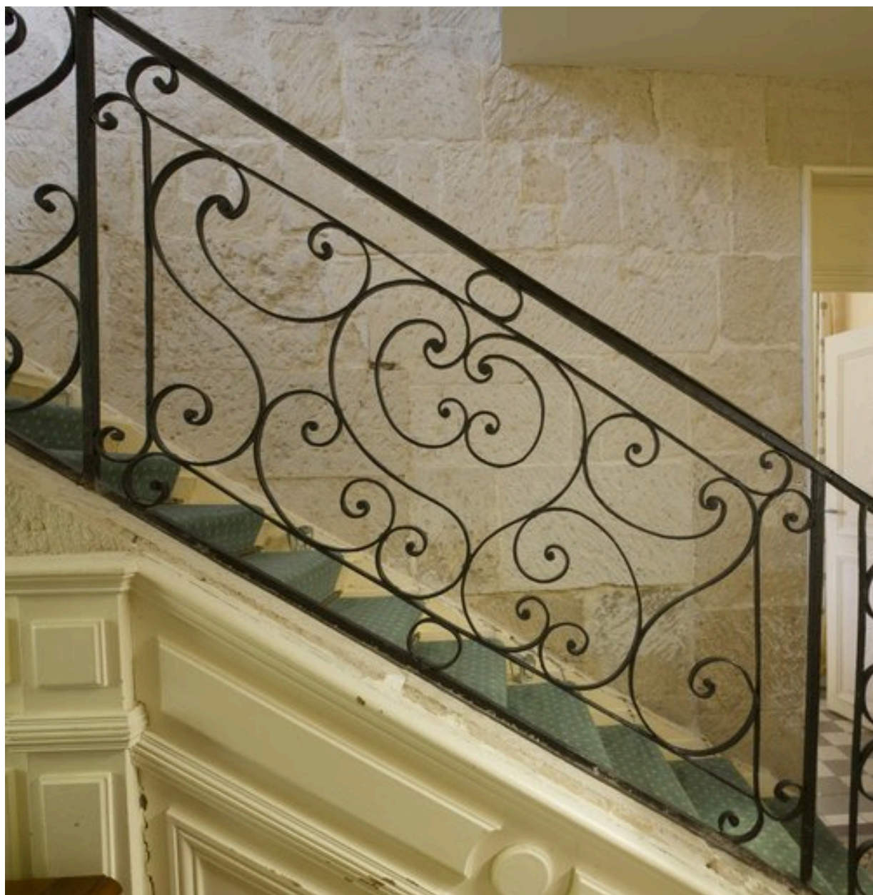
Détail de la rampe d'escalier.
