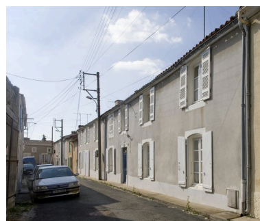
Vue de la façade sur rue, prise du nord. Phot. Patrice Giraud IVR52_20098500508NUCA
