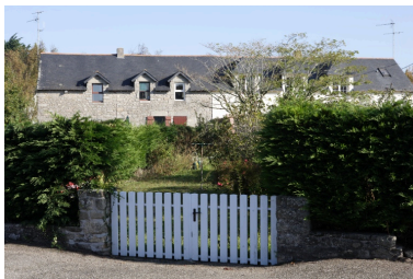
Vue d'ensemble de la rangée depuis le sud. Phot. Denis Pillet IVR52_20074401292NUCA
