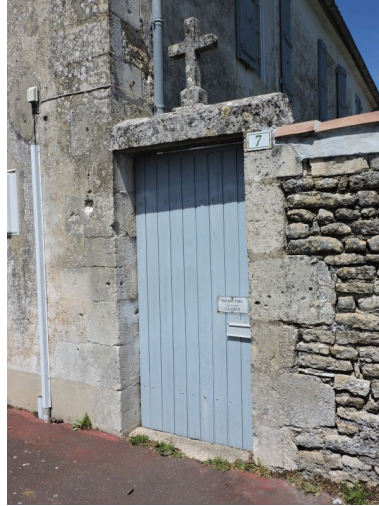
La porte piétonne surmontée d'une croix. Phot. Yannis Suire IVR52_20198501291NUCA
