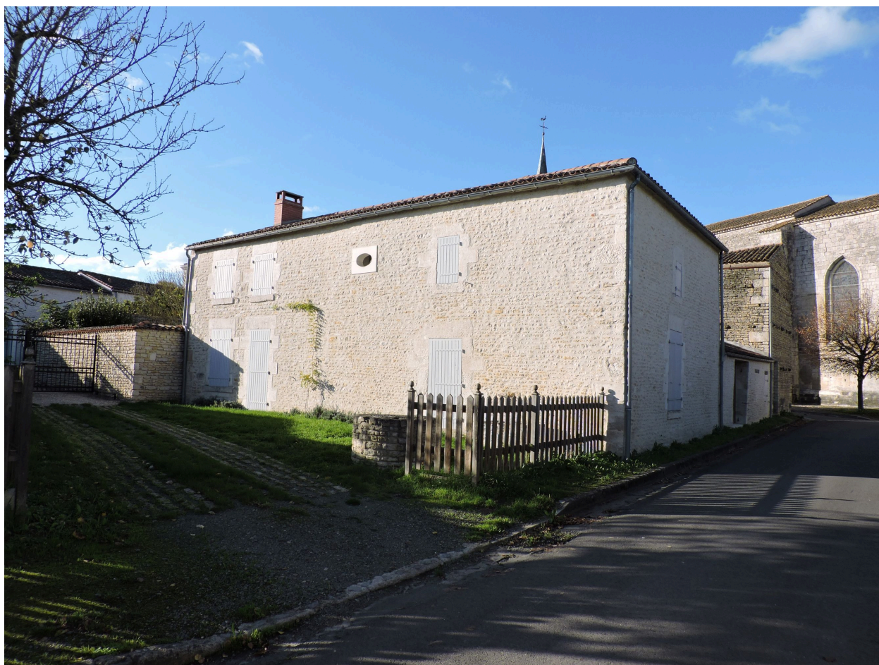
La maison vue depuis le sud-est.
