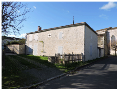
La maison vue depuis le sud-est.
