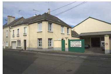
Vue depuis la rue. La maison est la deuxième à gauche. Phot. François Lasa IVR52_20045303100NUCA
