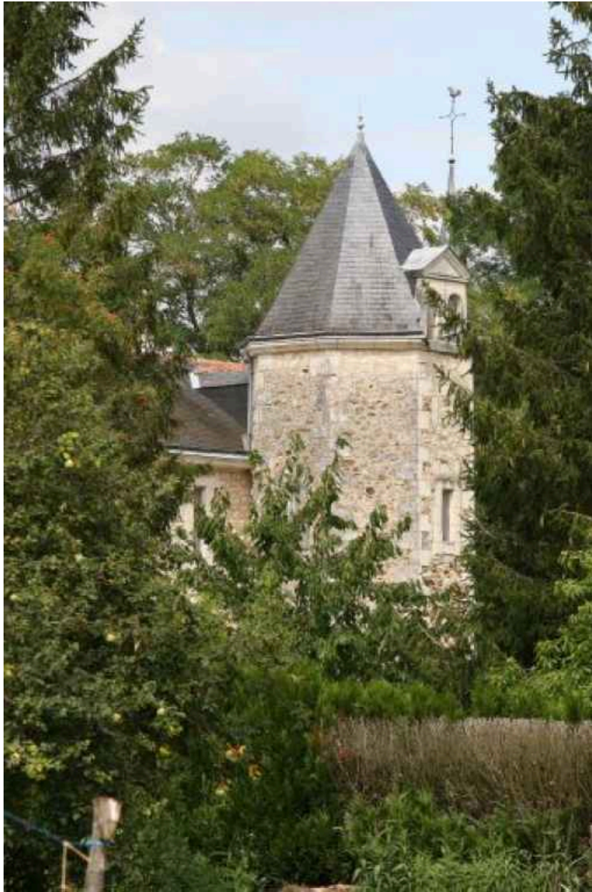
Vue de volume de la tourelle d'escalier polygonale.
