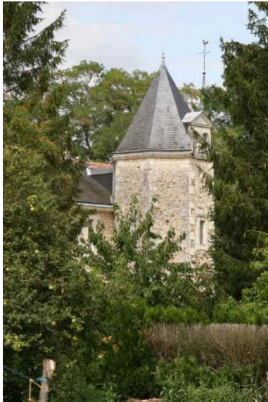
Vue de volume de la tourelle d'escalier polygonale. Phot. Jean-Baptiste Darrasse IVR52_20057203463NUCA
