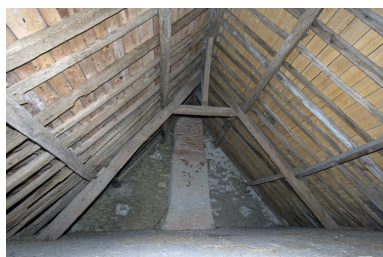
N° 10 rue Basse. Comble. Vue d'ensemble de la charpente. Phot. Denis Pillet IVR52_20094400032NUCA
