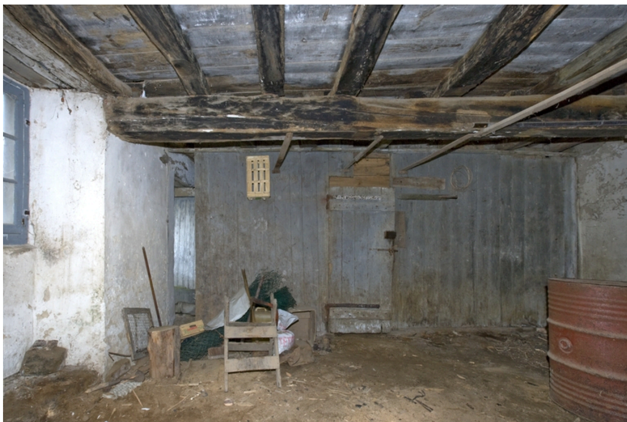
N° 10 rue Basse. Vue de la pièce du rez-de-chaussée depuis l'ouest.
