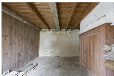
N° 10 rue Basse. Étage. Vue d'ensemble depuis le nord. Phot. Denis Pillet IVR52_20094400022NUCA
