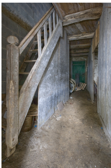
N° 10 rue Basse. Escalier. Phot. Denis Pillet IVR52_20094400016NUCA
