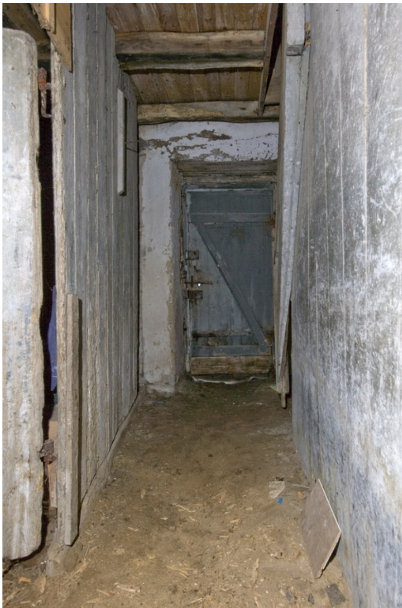
N° 10 rue Basse. Couloir d'entrée.
