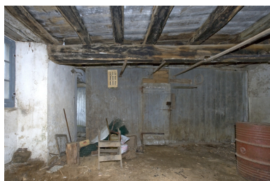
N° 10 rue Basse. Vue de la pièce du rez-de-chaussée depuis l'ouest. Phot. Denis Pillet IVR52_20094400018NUCA
