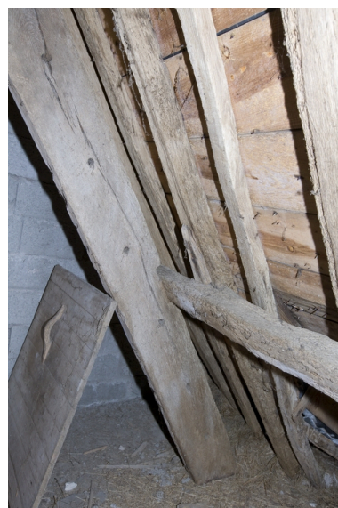
N° 10 rue Basse. Comble. Trappe d'accès au comble. Phot. Denis Pillet IVR52_20094400033NUCA
