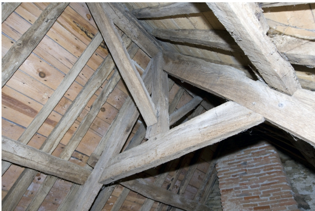
N° 10 rue Basse. Charpente.
