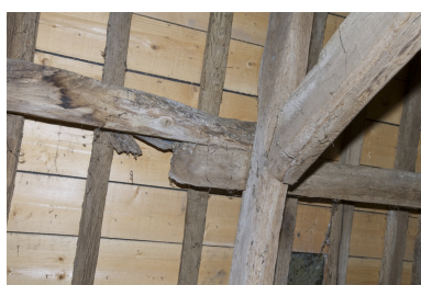
N° 10 rue Basse. Charpente. Assemblage des pannes. Phot. Denis Pillet IVR52_20094400036NUCA
