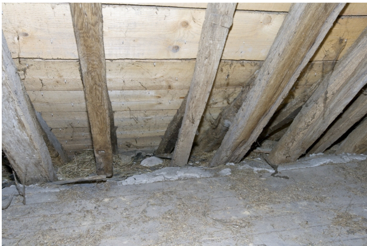
N° 10 rue Basse. Charpentes. Sablières.
