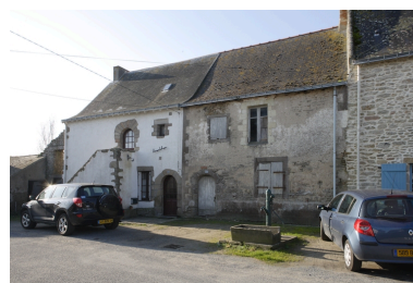
Vue du 1er et du 2e logis (10 et 12 rue Basse). Phot. Denis Pillet IVR52_20084400241NUCA
