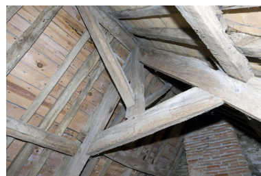
N° 10 rue Basse. Charpente. Phot. Denis Pillet IVR52_20094400035NUCA
