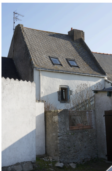
Vue de la façade sud du 3e logis (n° 6 rue Basse). Phot. Denis Pillet IVR52_20084400239NUCA
