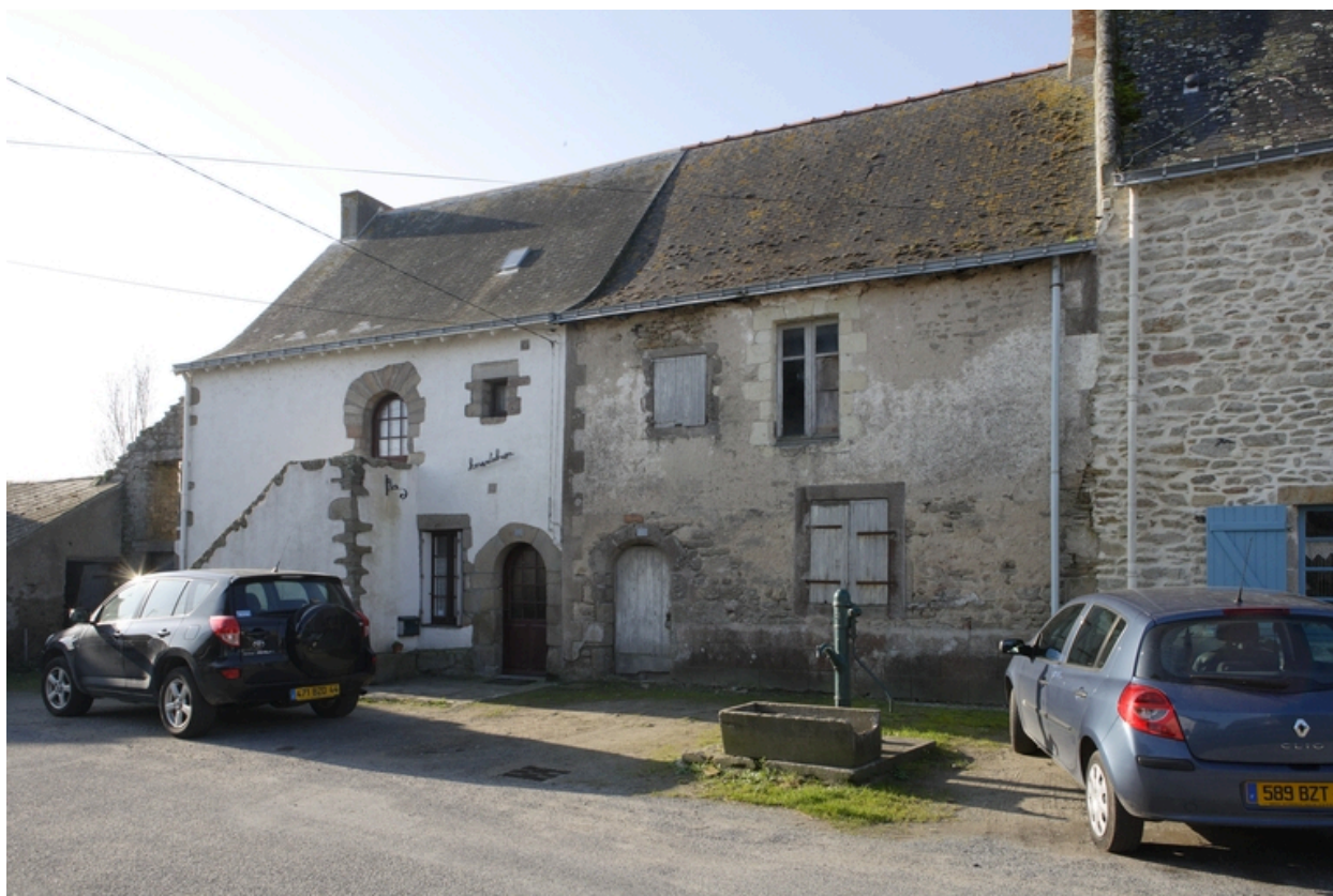
Vue du 1er et du 2e logis (10 et 12 rue Basse).
