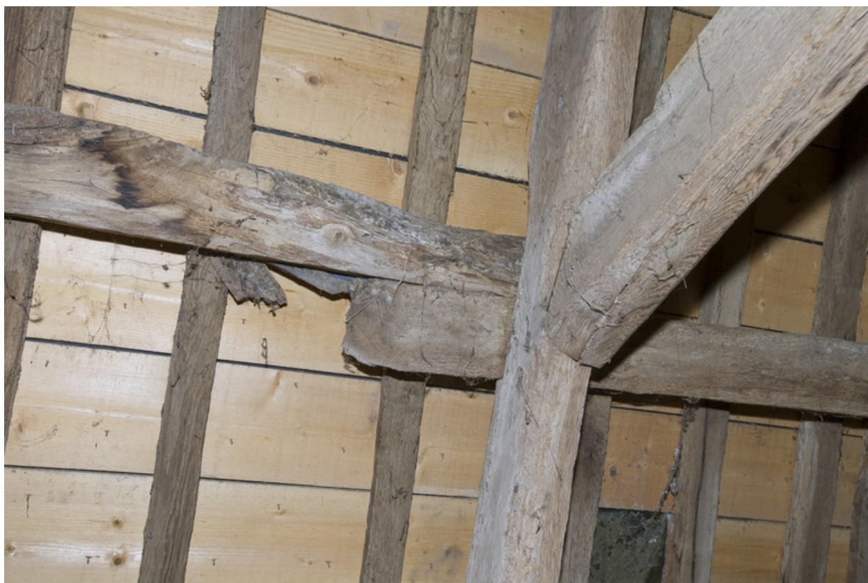
N° 10 rue Basse. Charpente. Assemblage des pannes.
